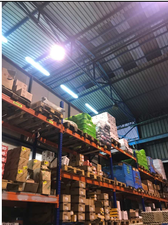
Foto 32 - Sub 2 deposito vendita ferramenta
