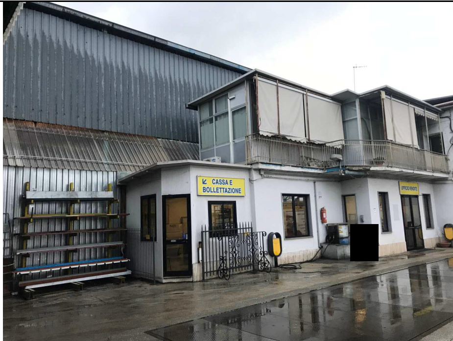
Foto 3: u.i.Sub 1 oggetto di stima : Palazzina Uffici
