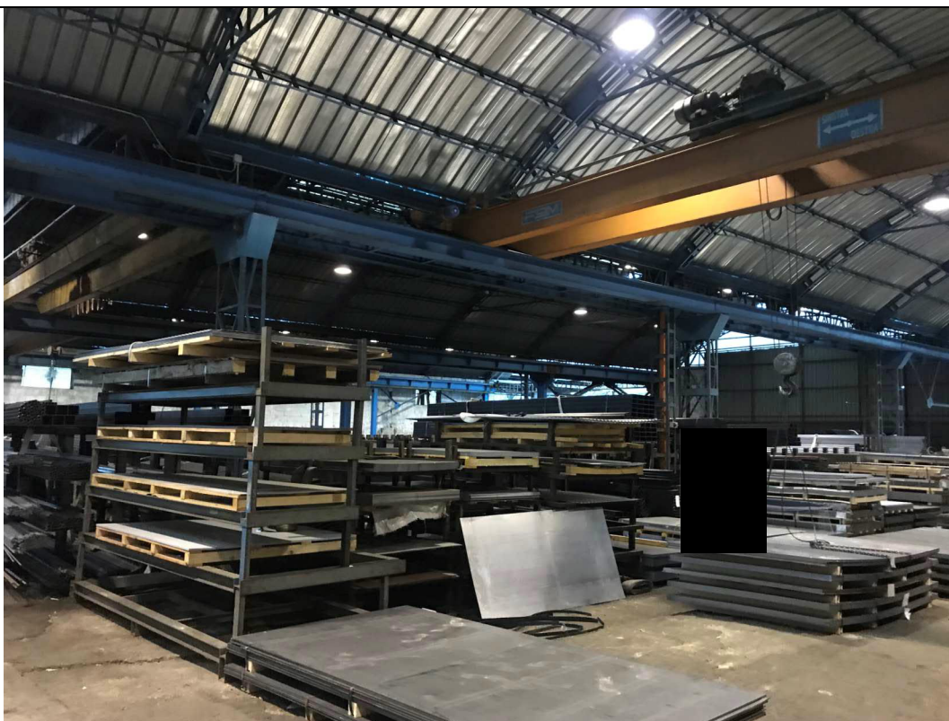
Foto 25– capannone – altra angolazione
