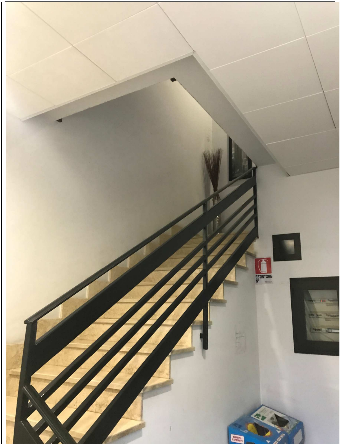
Foto 6: u.i. Sub1 oggetto di stima – scala accesso piano primo uffici
