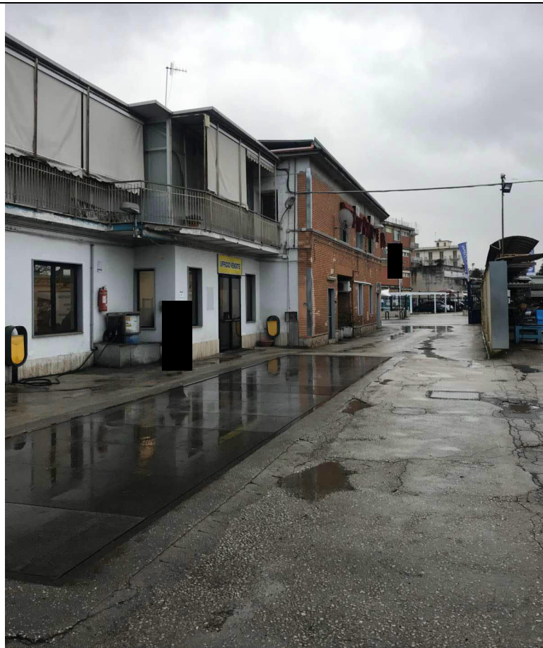
Foto 4: u.i. Sub 1 oggetto di stima : Palazzina Uffici
