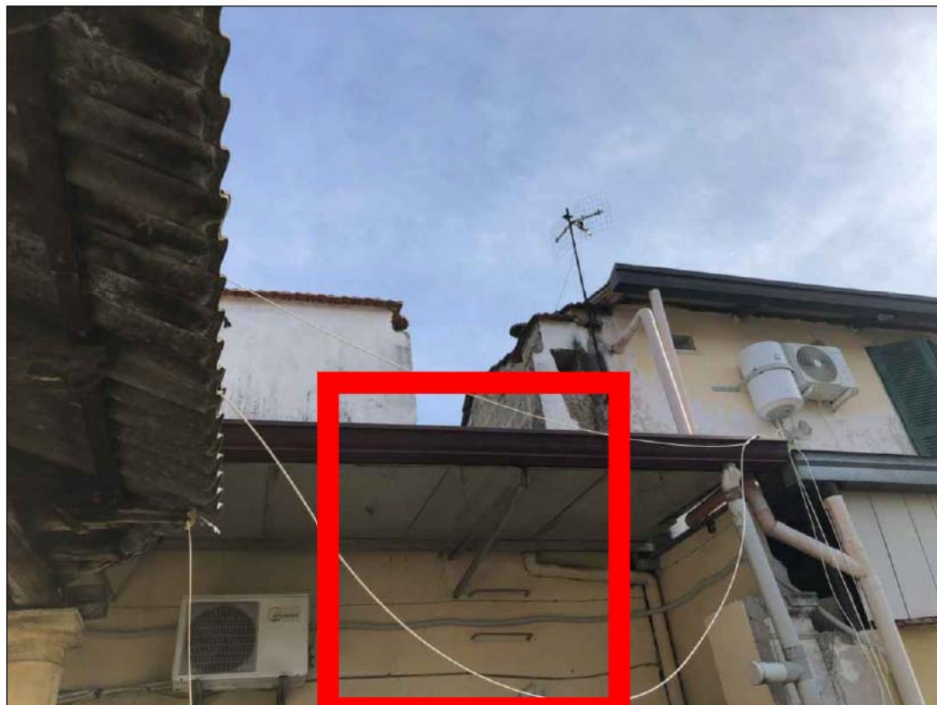
FOTO 9: SCALA PER ACCEDERE AL LASTRICO SOLARE
