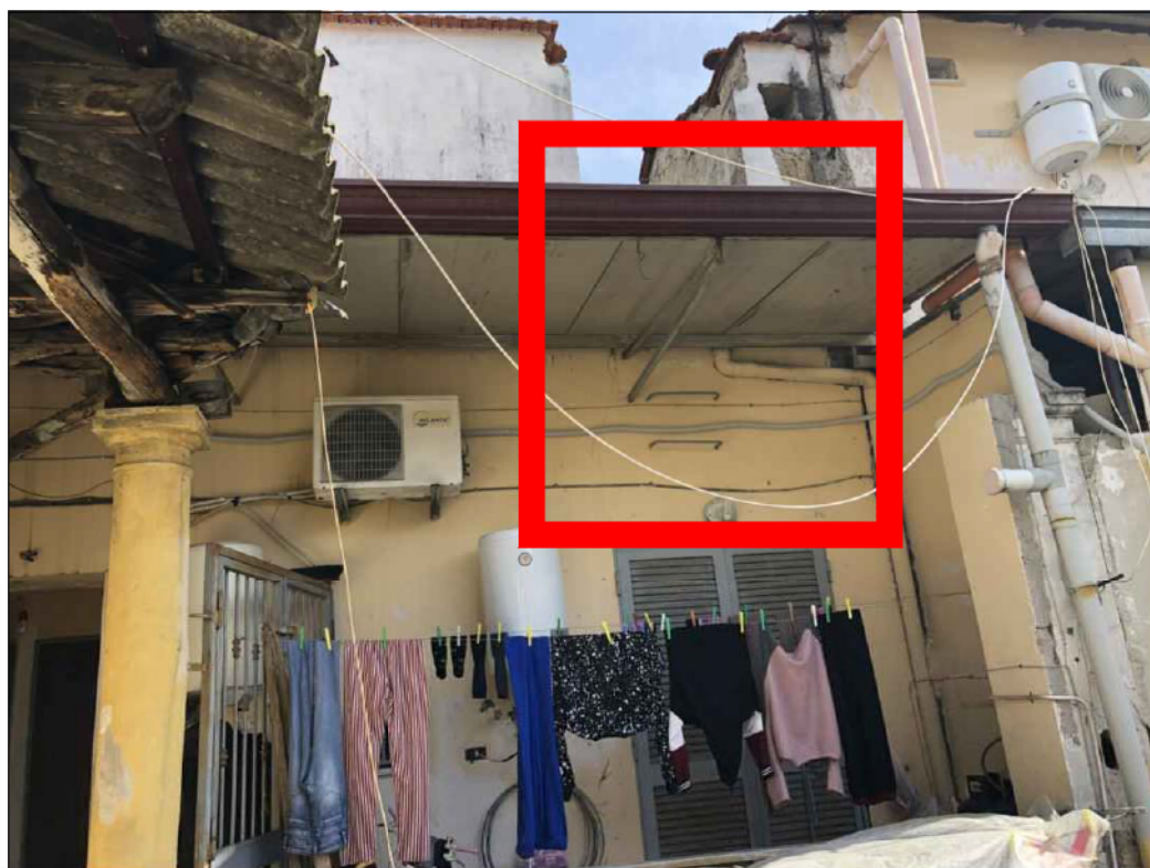
FOTO 8: SCALA PER ACCEDERE AL LASTRICO SOLARE
