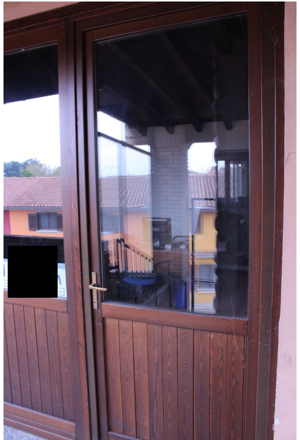
Balcone con ingresso appartamento
