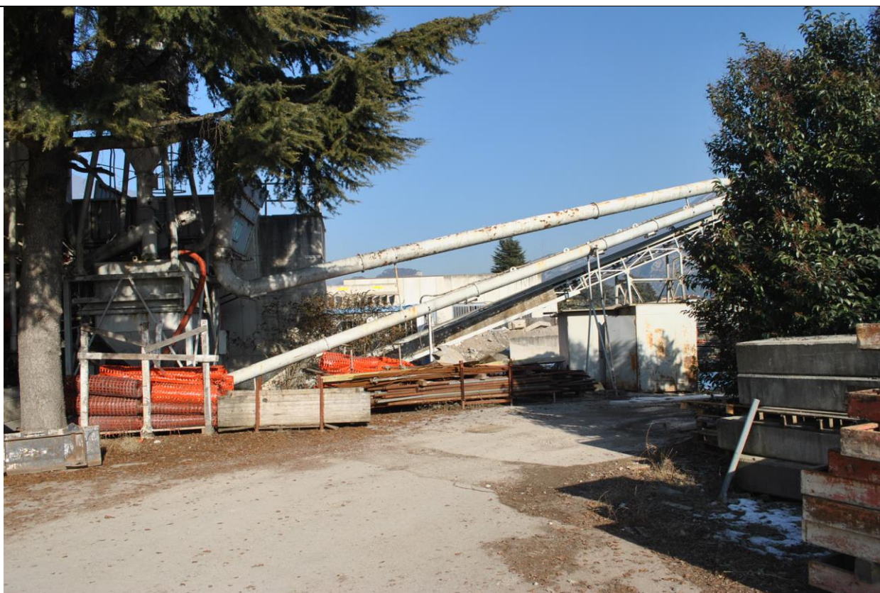
Impianto di betonaggio
