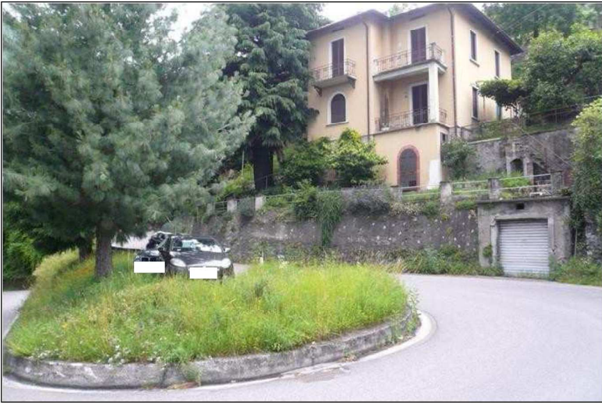
FT. N.1 - VISTA ESTERNA CASA
