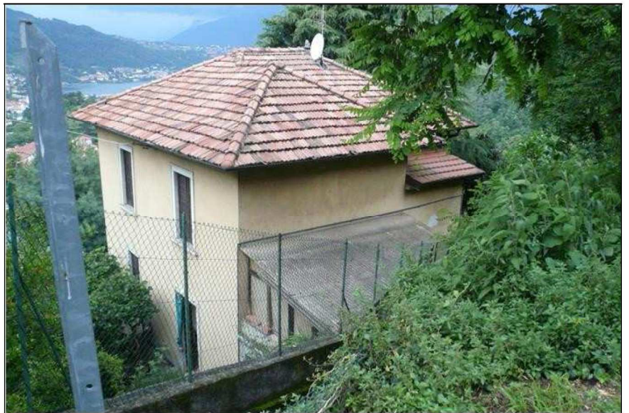
FT. N.2 - VISTA ESTERNA CASA
