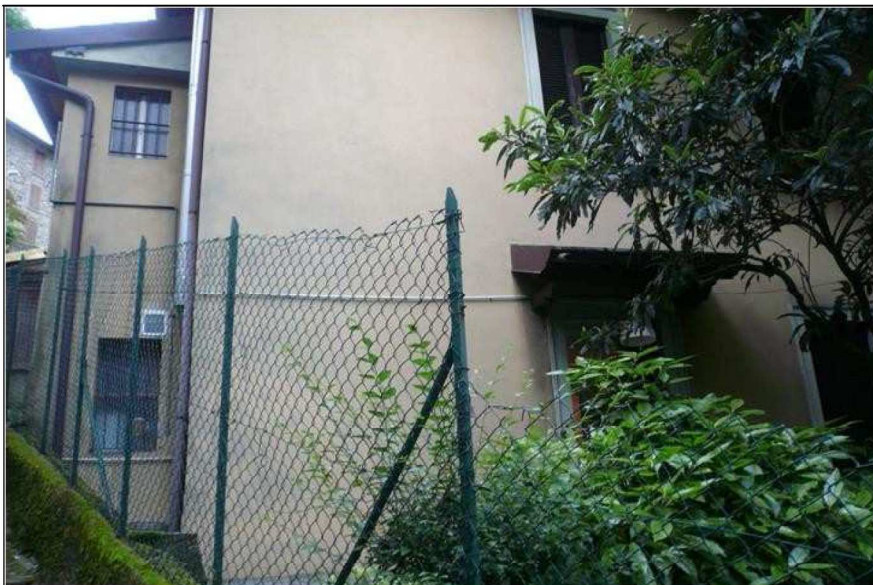
FT. N.3 - VISTA ESTERNA CASA
