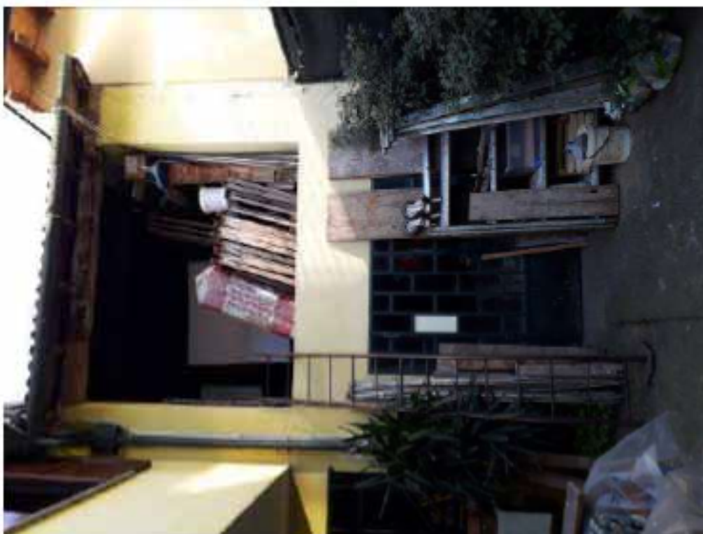
Ingresso autorimessa dal cortile comune con sovrastante fienile part. 33 sub.12
