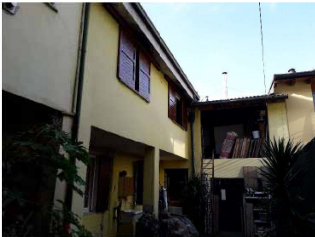
Cortile comune in fondo i mapp 33-14 autorimessa a PT e il fienile mapp 33-12=34-13 parte a P1
