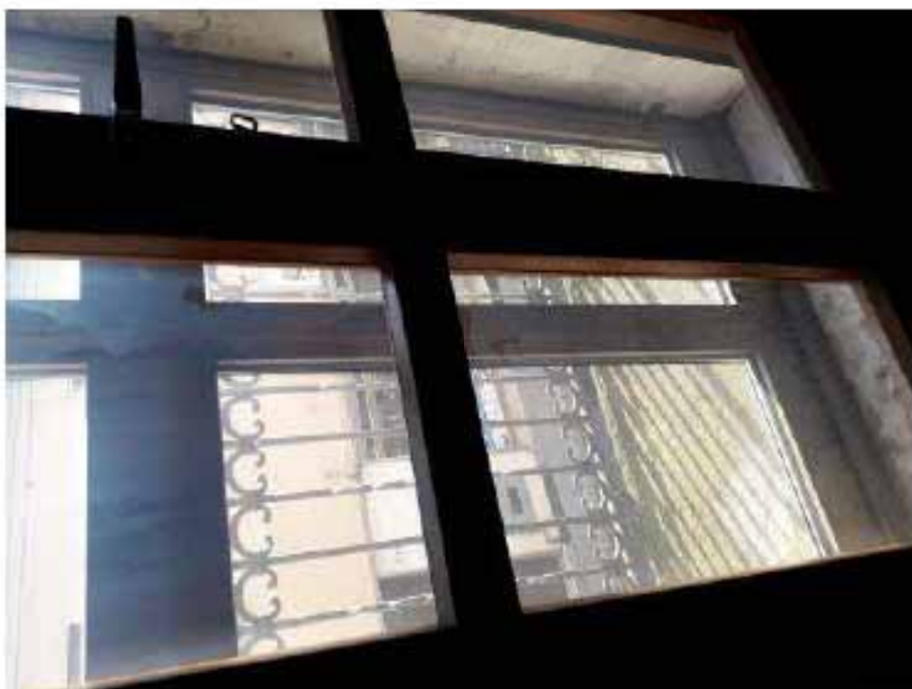
Serramento legno vetro singolo con serramento alluminio su via Badia e balcone
