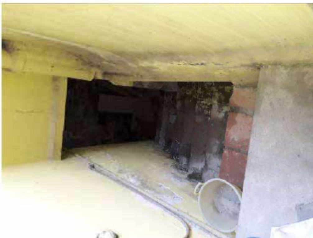
Scale alla cantina interrata dal cortile comune
