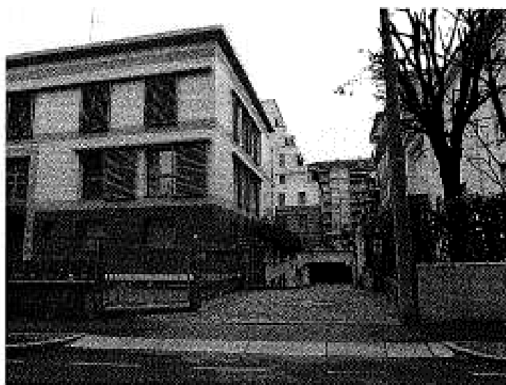
VIA DEI PARTIGIANI N.118 INGRESSO CARRALE AI BOX
