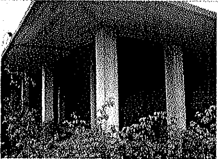
La club house in costruzione
