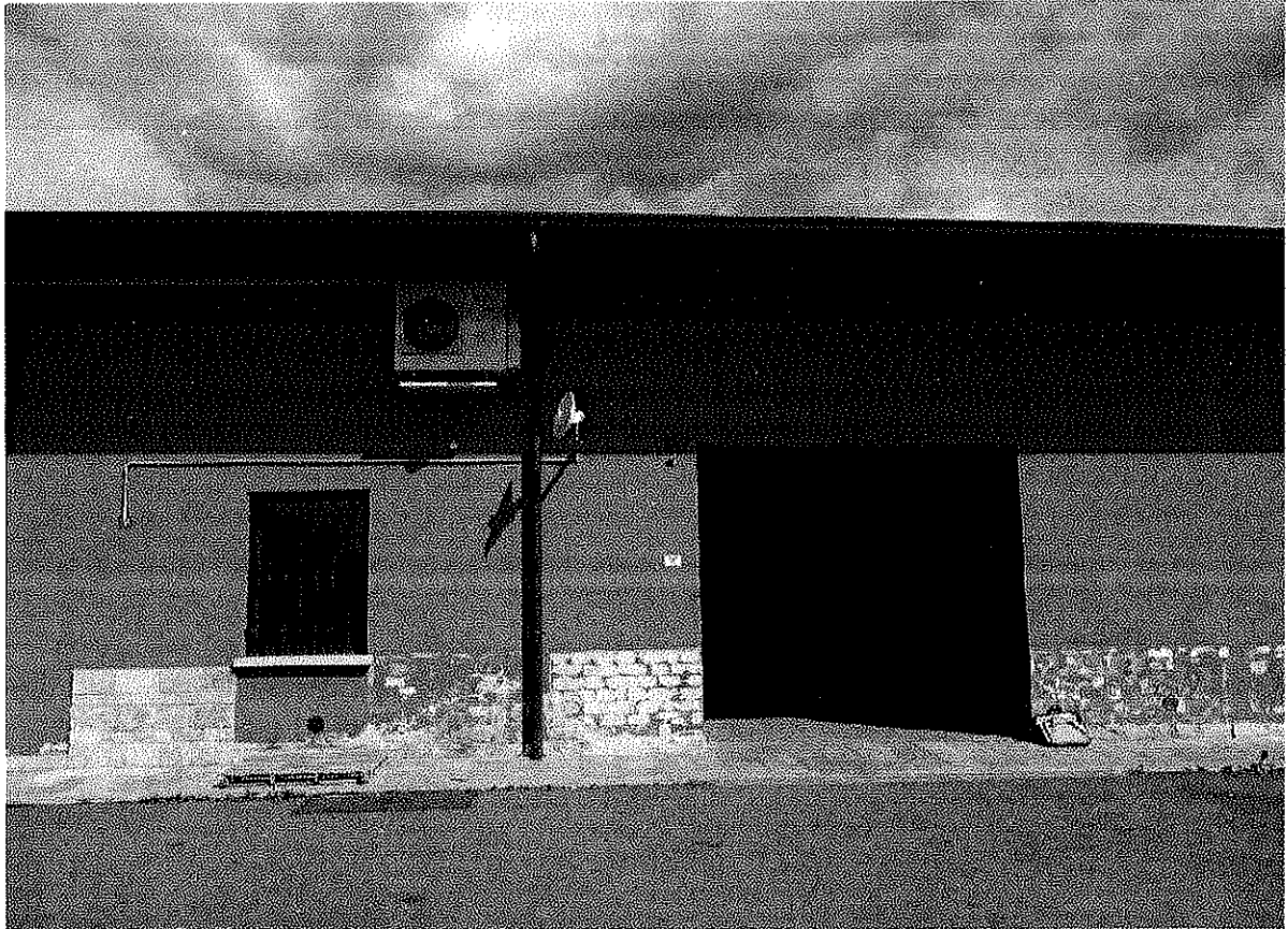
Fig. 17 – Vista dell'accesso carrale al laboratorio/magazzino (lato sud-ovest edificio)
