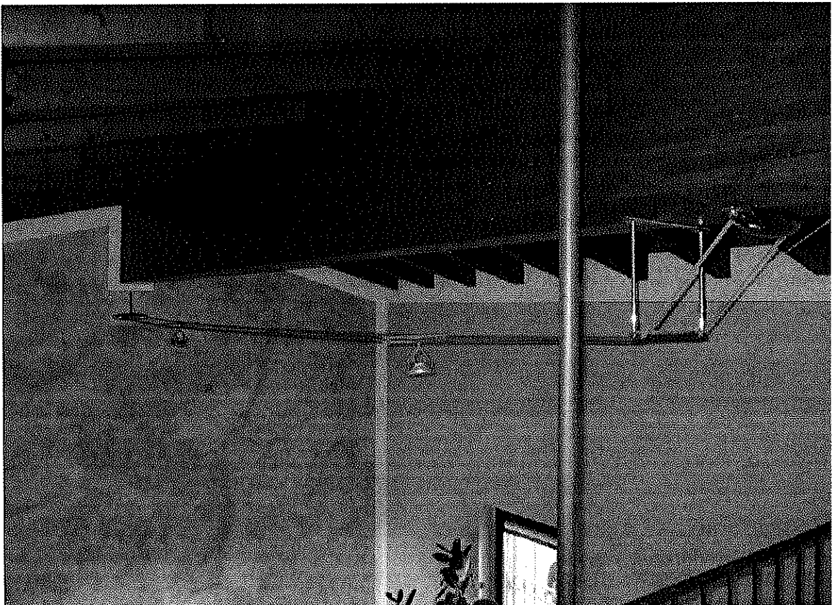
Fig. 41 – Vista della copertura in legno
