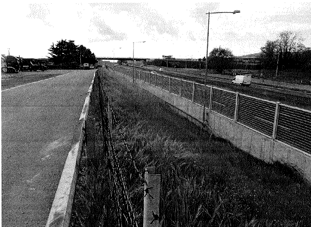
Fig. 3 – Vista della strada interna alla proprietà che fiancheggia l'autostrada
