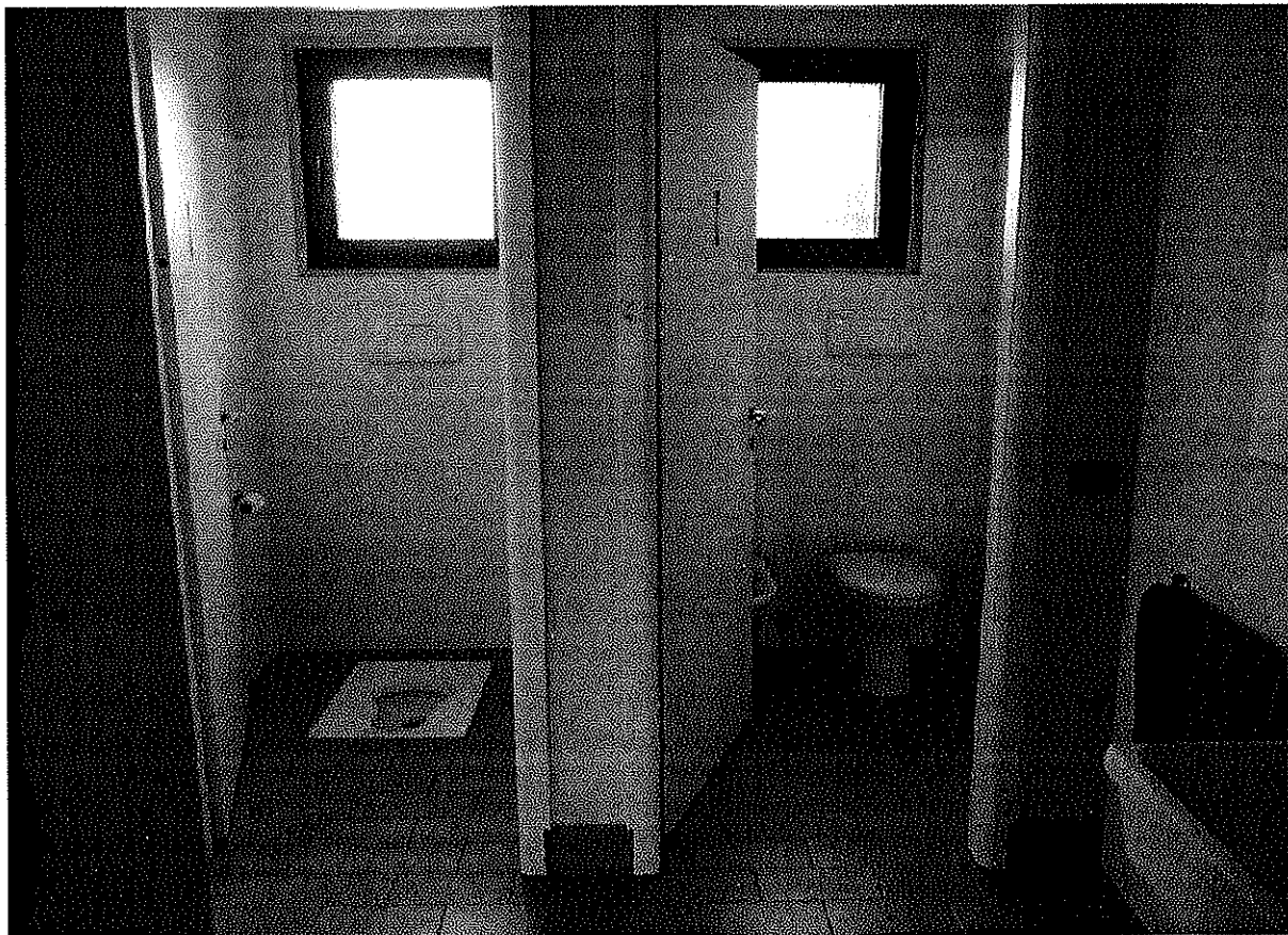
Fig. 26 – Vista dei wc installati nel bagno
