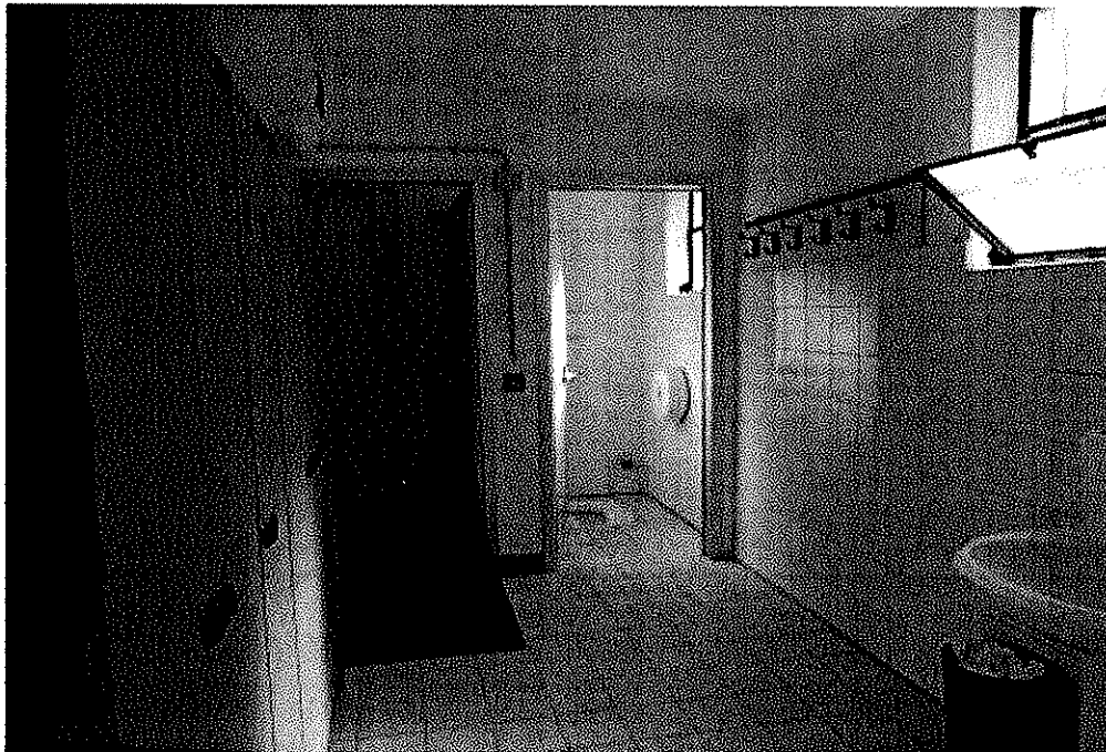
Foto 10 – bagno e spogliatoio
