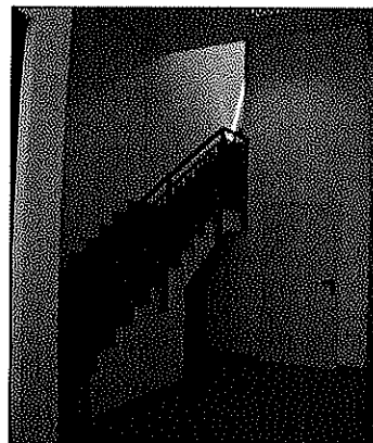
Vano scale comune, identificato con il sub. 760
