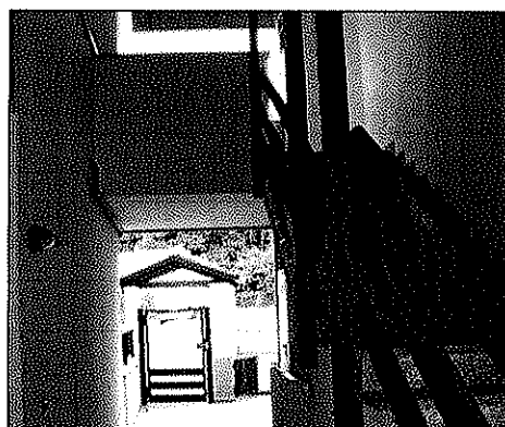
Vano scale comune
