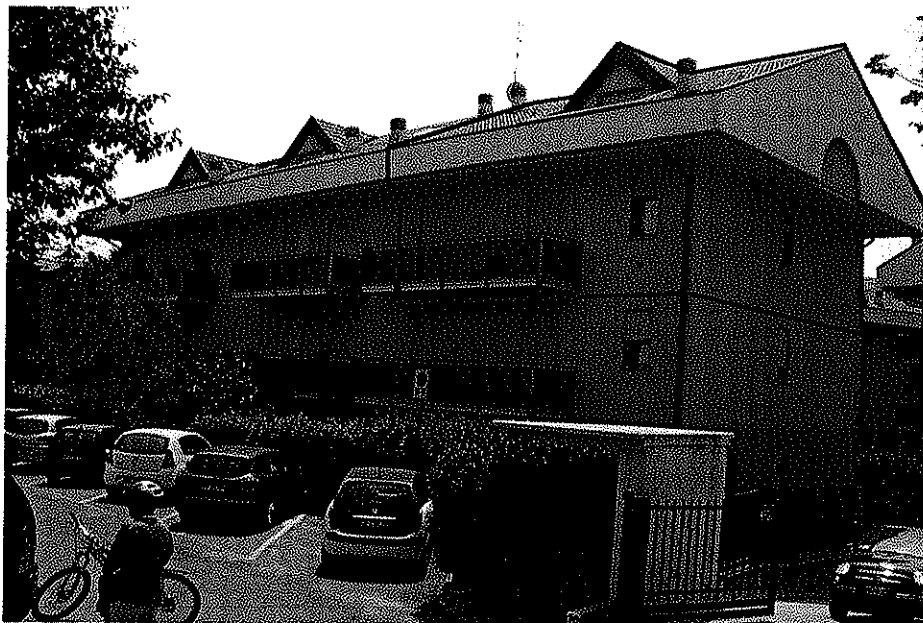
Appartamento oggetto di valutazione
