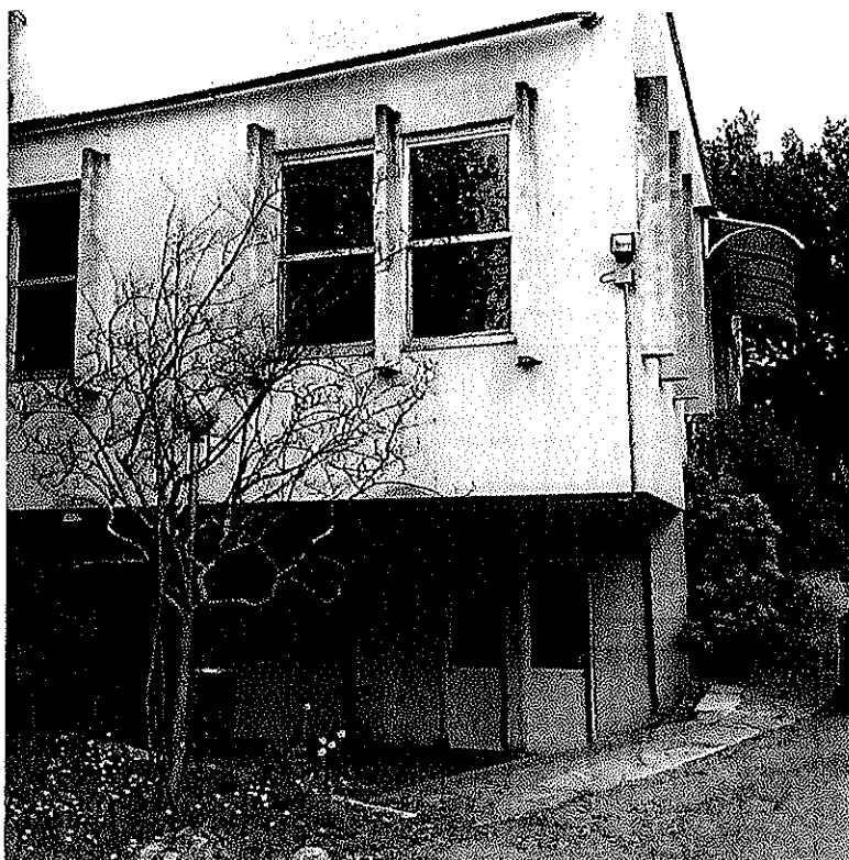
Foto 2: Palazzina uffici e casa del custode
