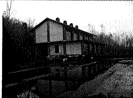
Le foresterie in costruzione
