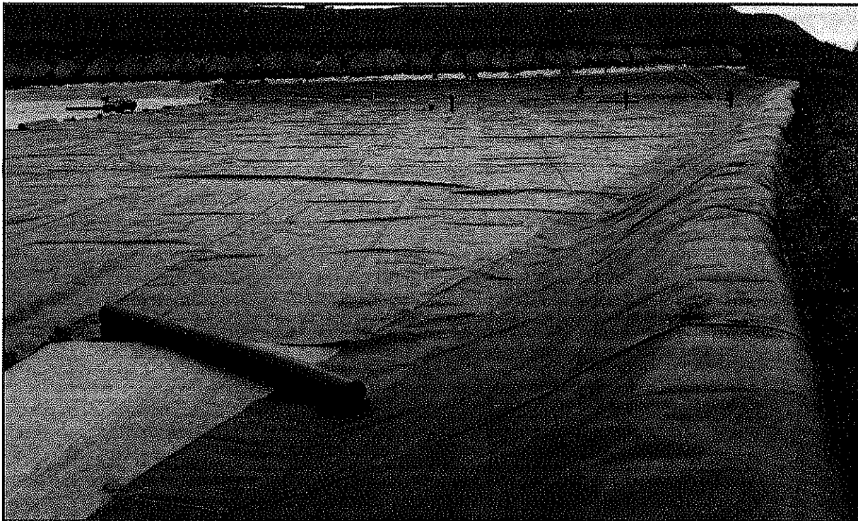
Foto 13: Interventi di impermeabilizzazione 3° vasca
