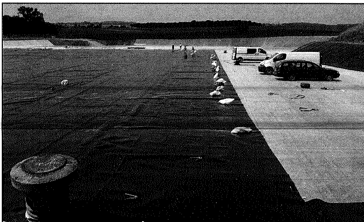
Foto 14: Interventi di impermeabilizzazione 3° vasca
