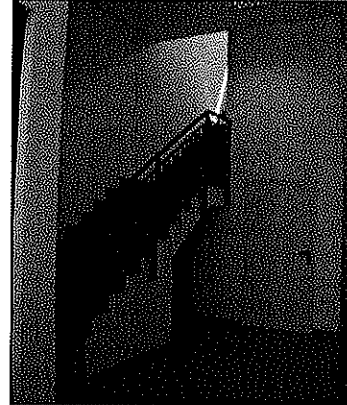
Vano scale comune, identificato con il sub. 760
