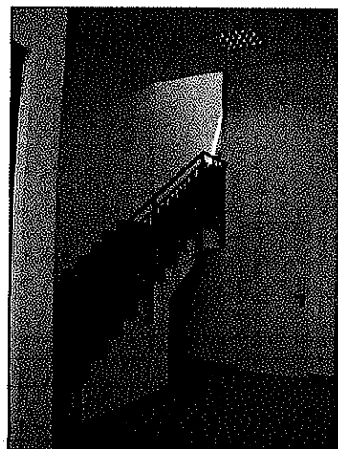
Vano scale comune
