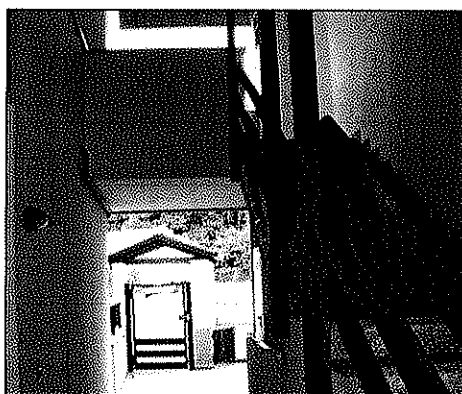
Vano scale comune
