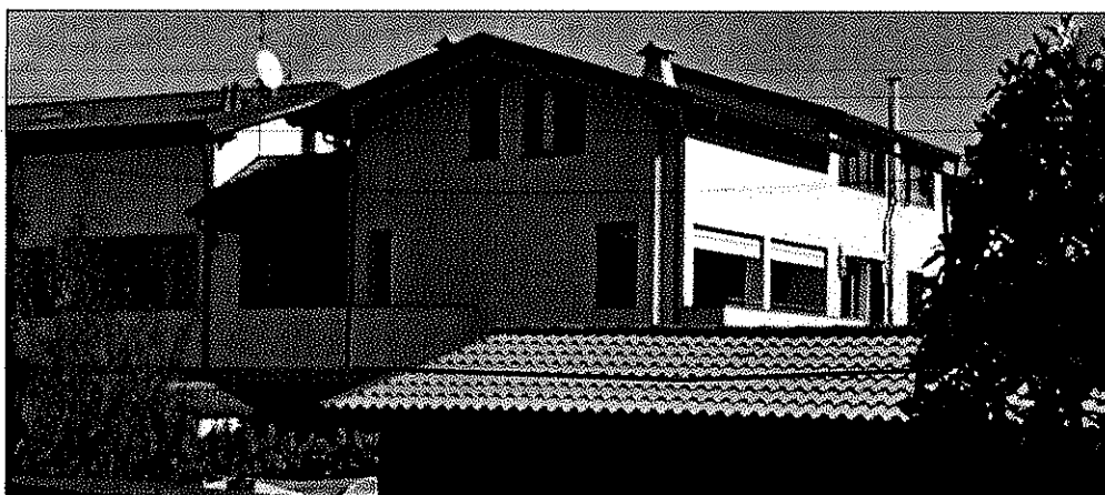
Appartamento oggetto di valutazione
