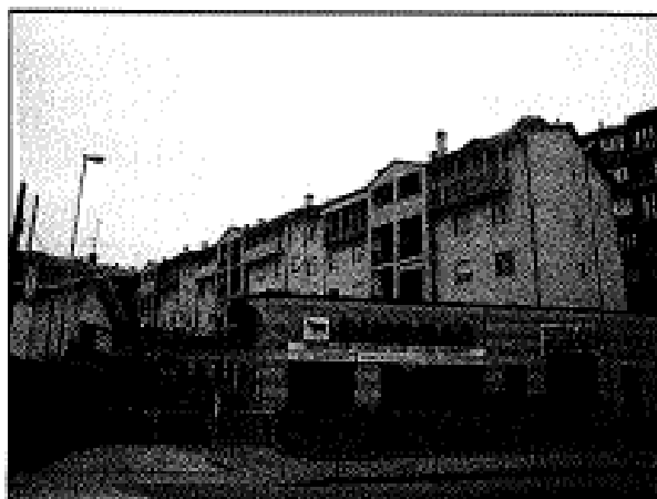
Facciate sud ed ovest del condominio
