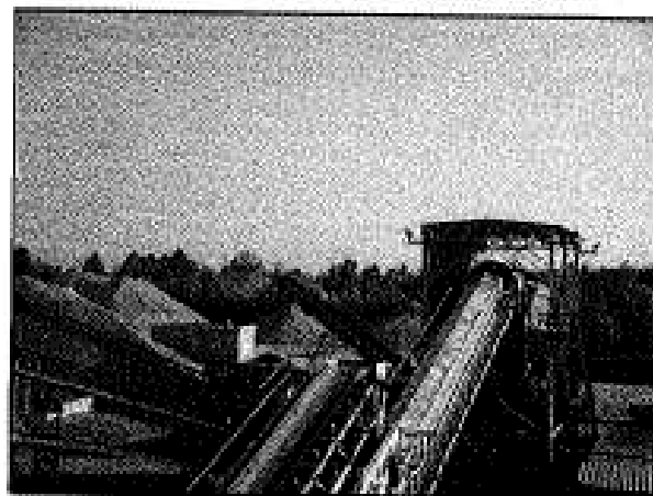
Impianto di frantumazione e selezione inerti I
