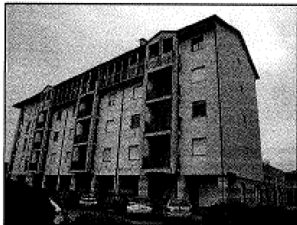
Facciata nord del condominio
