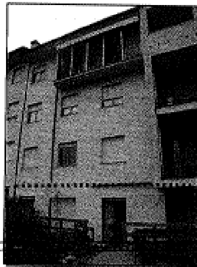
Prospetto ovest – l'unità immobiliare in oggetto è contornata con linea tratteggiata rossa
