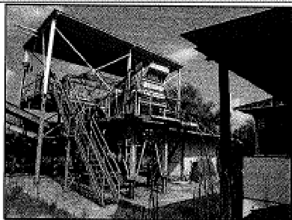
Impianto di frantumazione e selezione inerti
