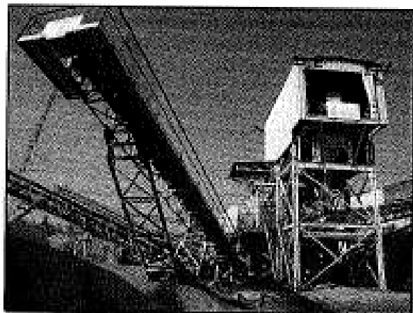
Impianto di frantumazione e selezione inerti I
