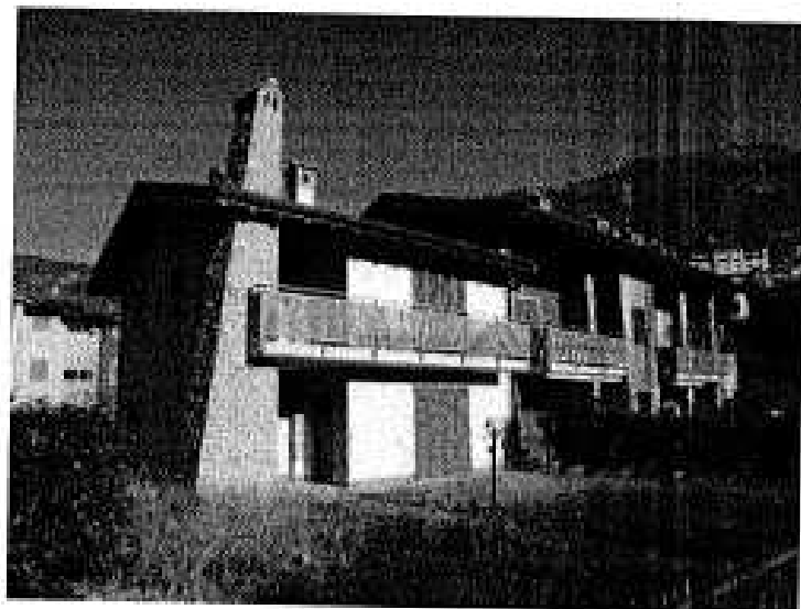
Foto 62 - Vista Blocco -d-:
