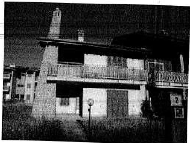
Foto 69 - Vista Villetta Blocco -d-:
