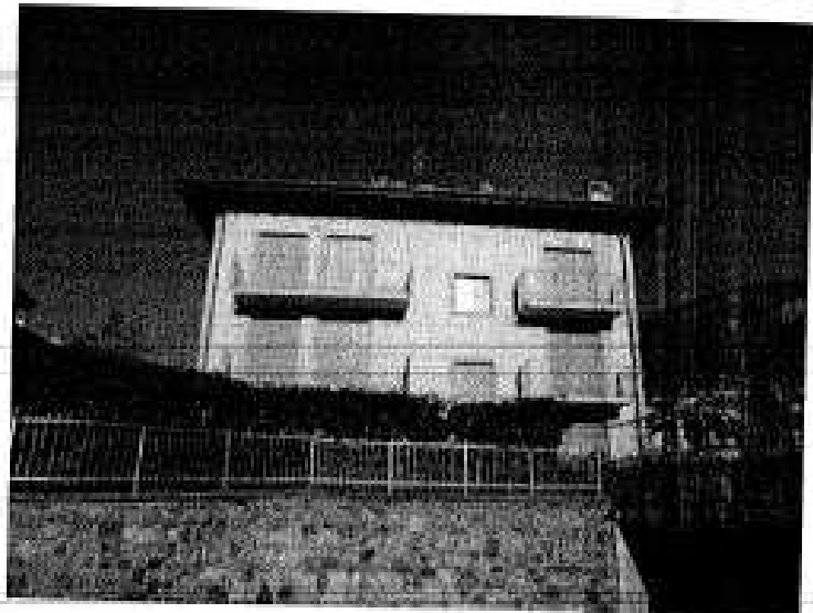
Foto 20 - Vista Blocco -b-:
