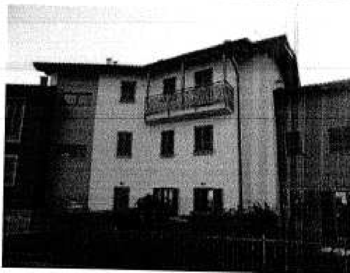
Foto 64 - Vista Blocco -d-:
