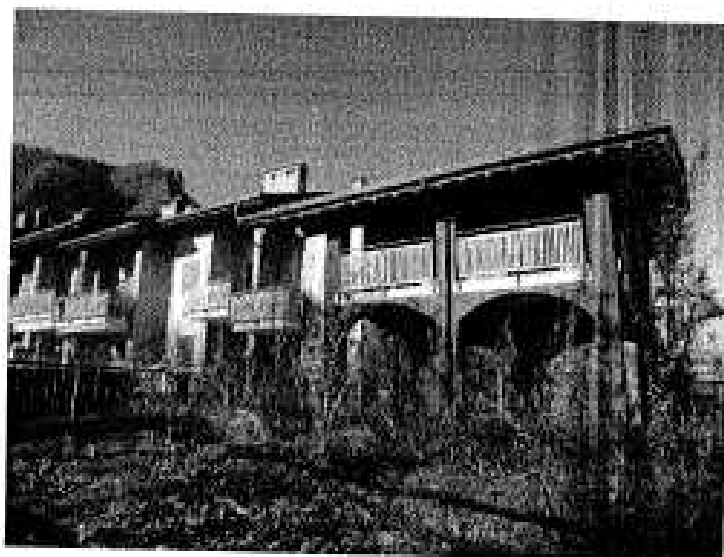
Foto 59 - Vista Blocco -d-:
