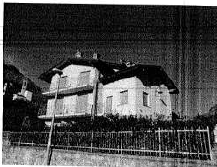
Foto 12 - Vista Blocco -a-:
