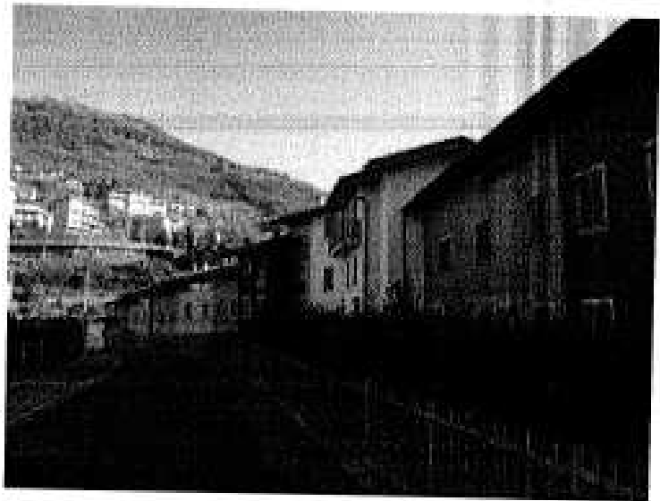
Foto 67 - Vista Blocco -d-:
