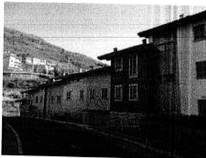
Foto 63 - Vista Blocco -d-:
