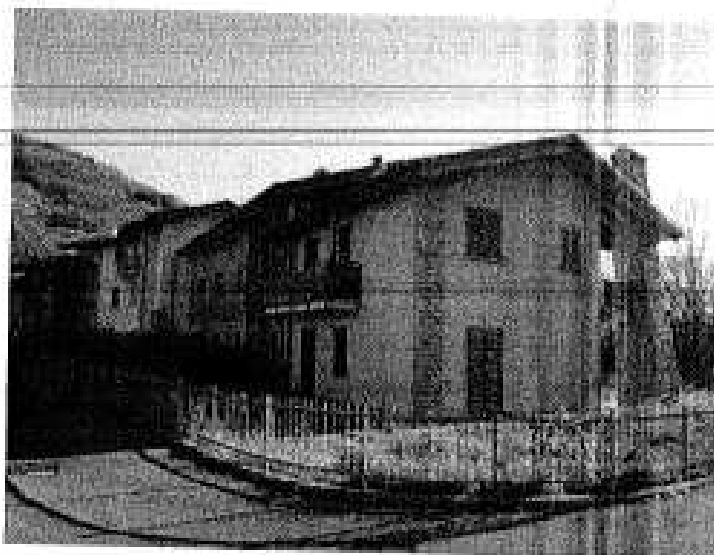
Foto 66 - Vista Blocco -d-:
