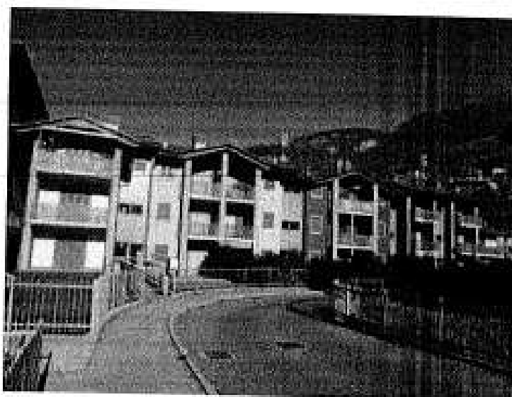
Foto 46 - Vista Blocco -c-:
