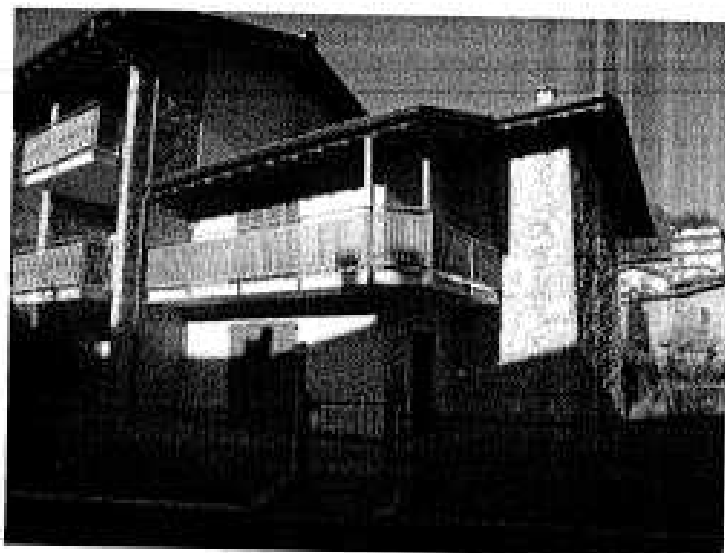
Foto 50 - Vista Blocco -c-;
