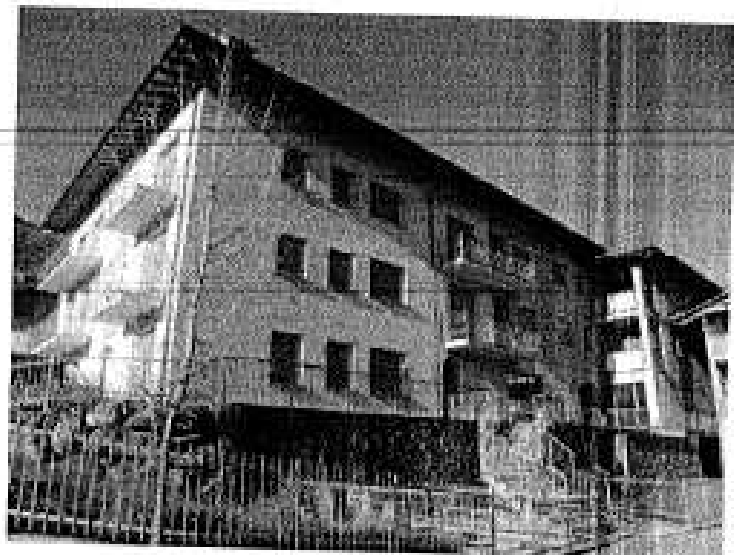
Foto 21 - Vista Blocco -b-:
