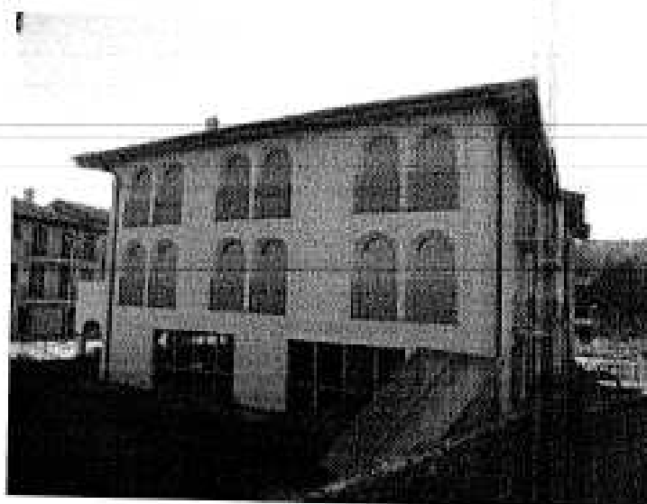
Foto 9 - Vista Blocco -a-:
