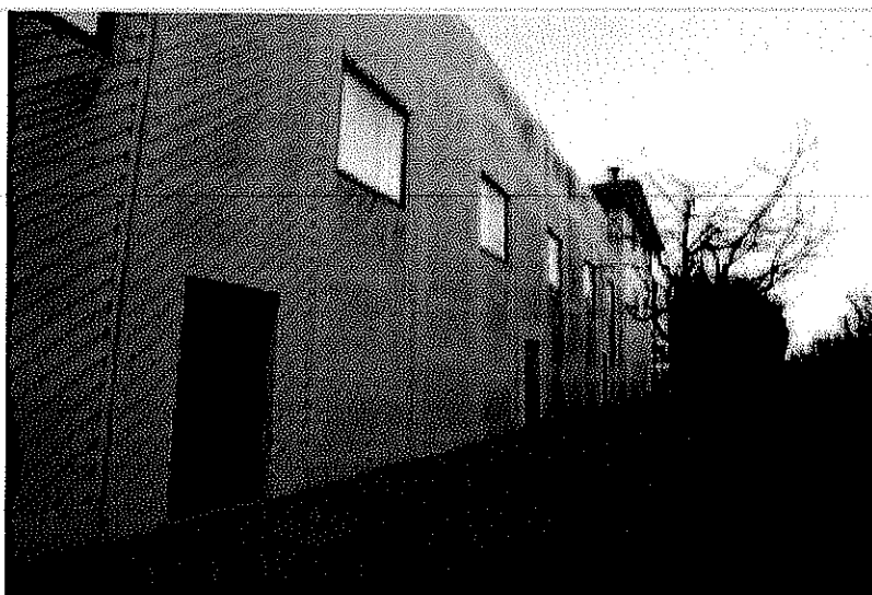
20-Vista del capannone, facciata a ovest
