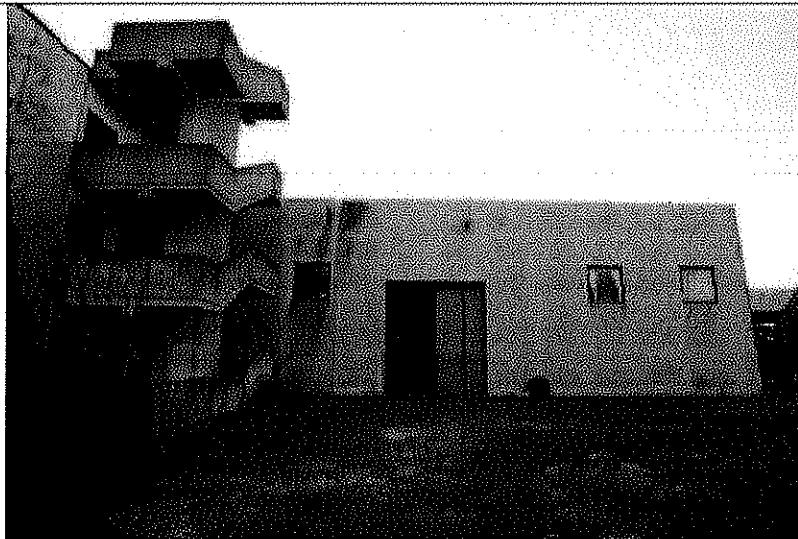
17- Il capannone dal piazzale interno.
