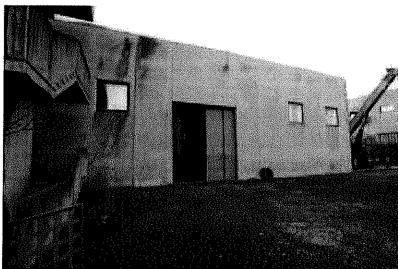
18- Vista del capannone dal piazzale interno.
