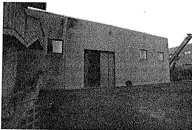
18- Vista del capannone dal piazzale interno.
