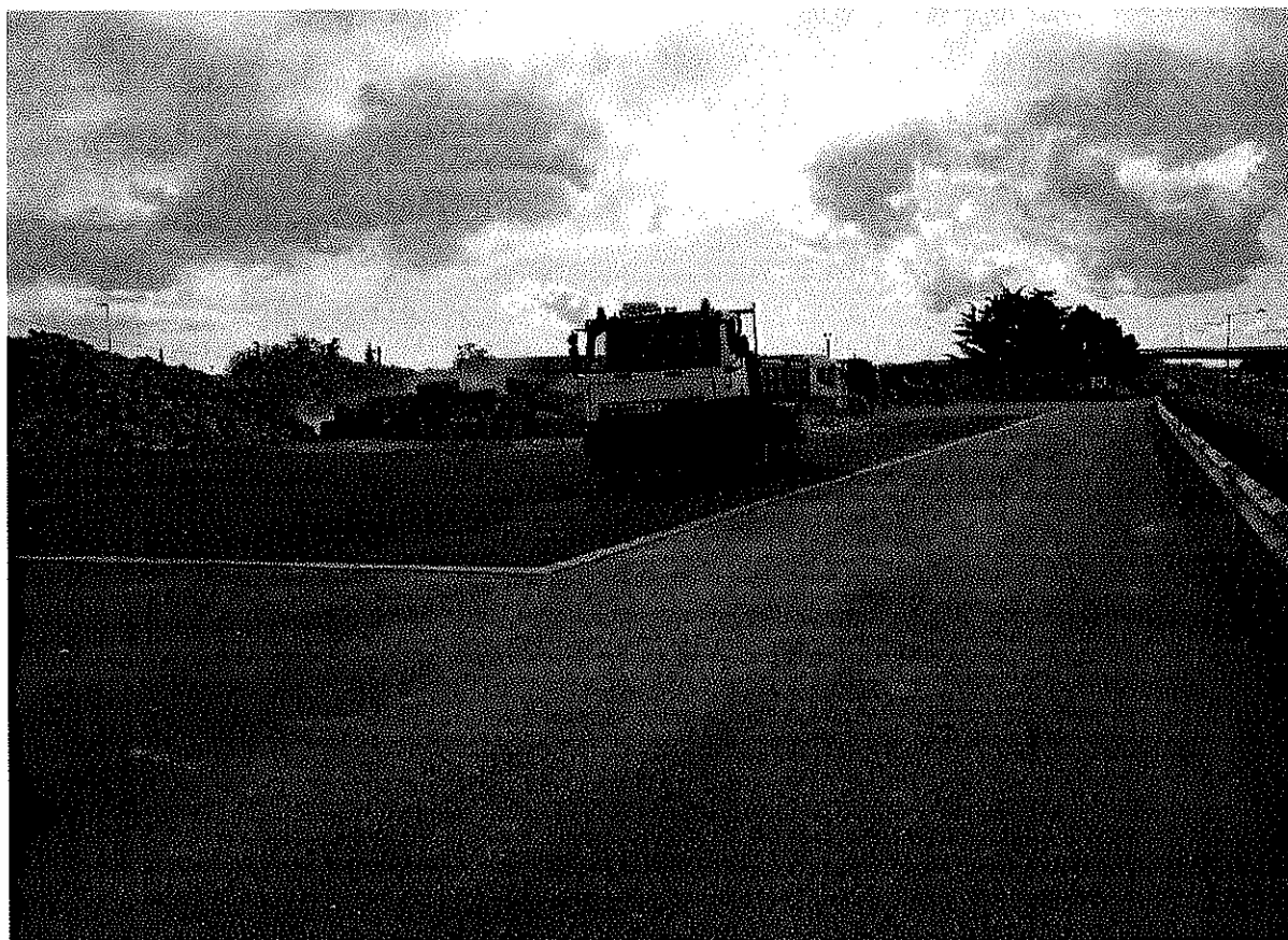
Fig. 6 – Vista d'insieme dell'area/piazzale oggetto di perizia (mapp. 8995 e 8992)
