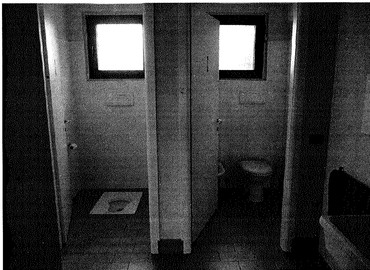
Fig. 26 – Vista dei wc installati nel bagno
