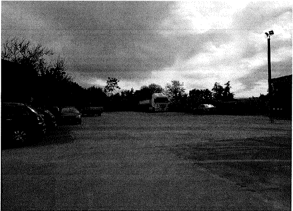
Fig. 11 – Vista del piazzale sul lato ovest del fabbricato magazzino/uffici (mapp. 672, sub. 703)
