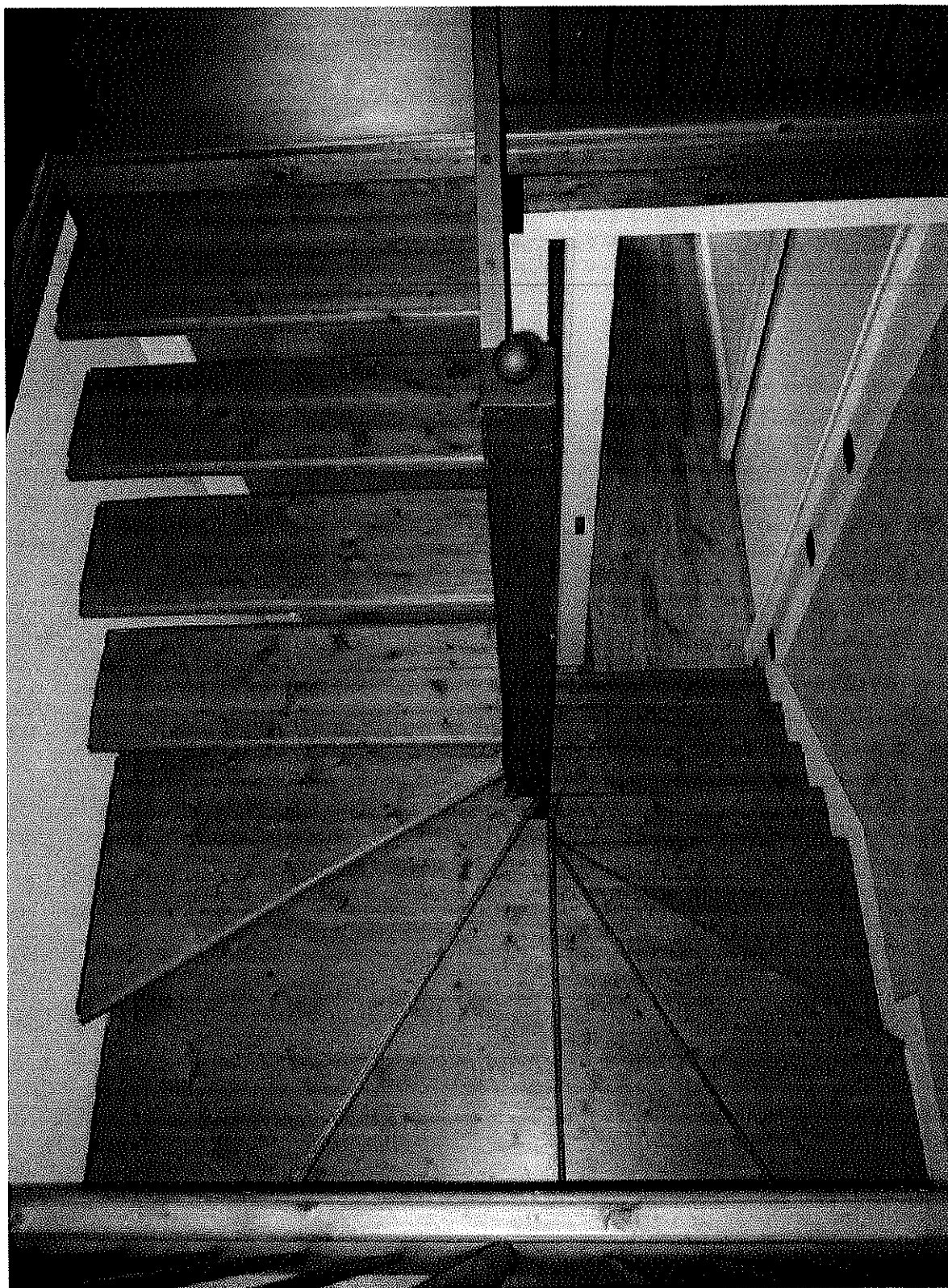
Fig. 28 – Vista della scala che collega l'ufficio al piano soppalcato
