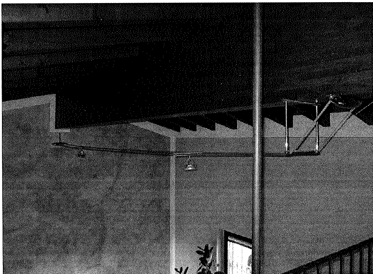
Fig. 41 – Vista della copertura in legno
