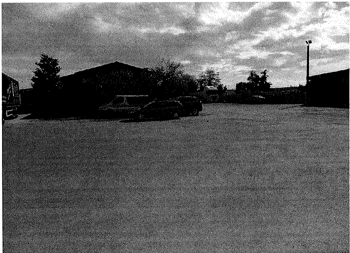
Fig. 10 – Vista del piazzale asfaltato antistante il fabbricato magazzino/uffici (mapp. 672, sub. 703)
