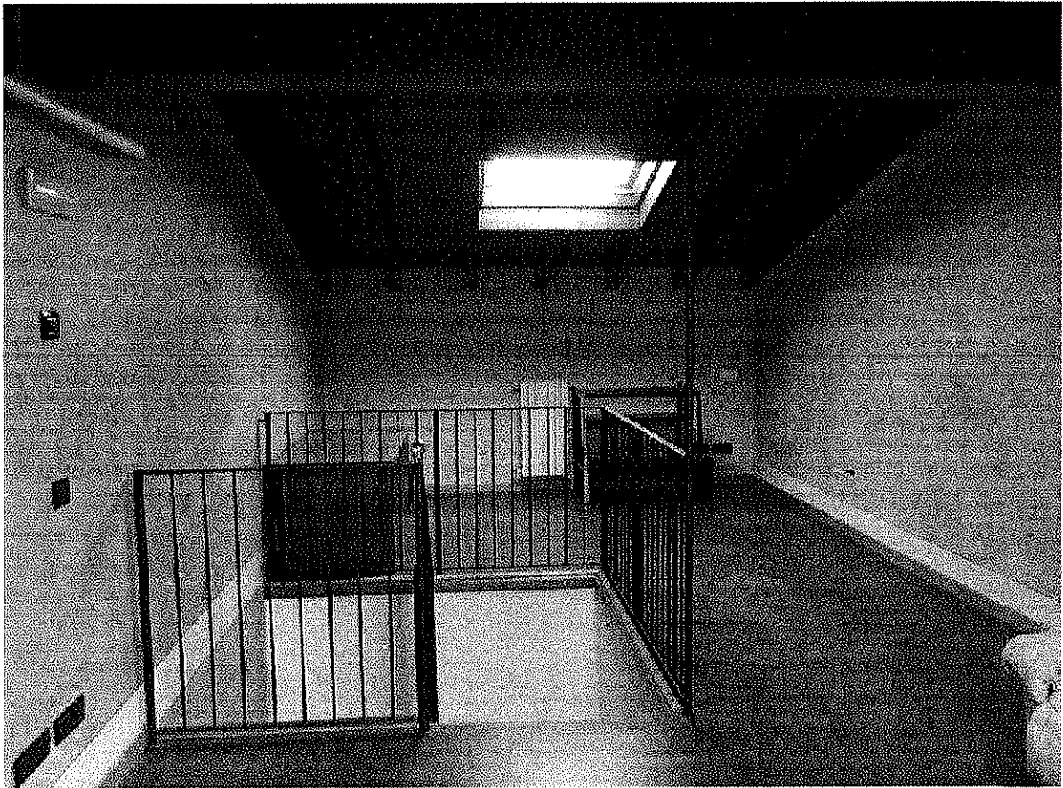
Fig. 29 – Vista d'insieme del piano soppalcato (lato est)
