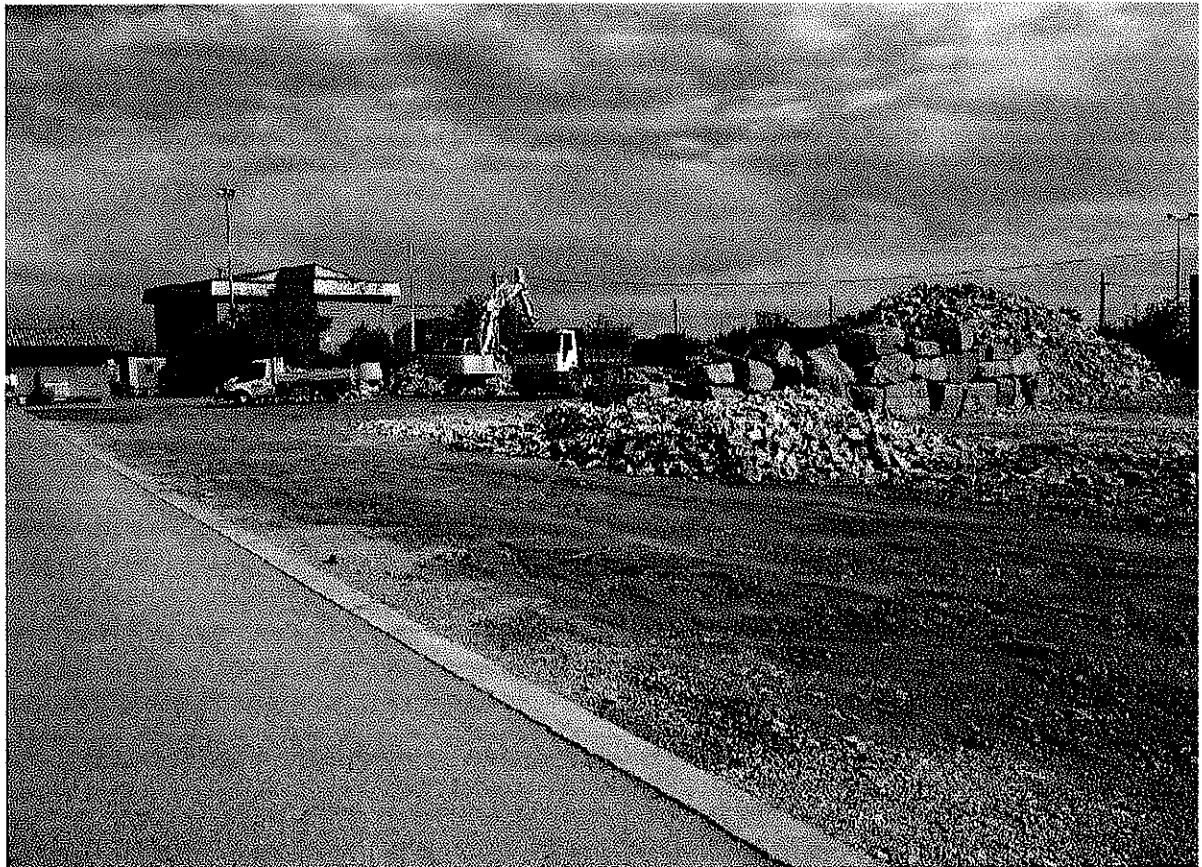
Fig. 7 – Vista del piazzale in ghiaia adibito allo stoccaggio delle pietre
