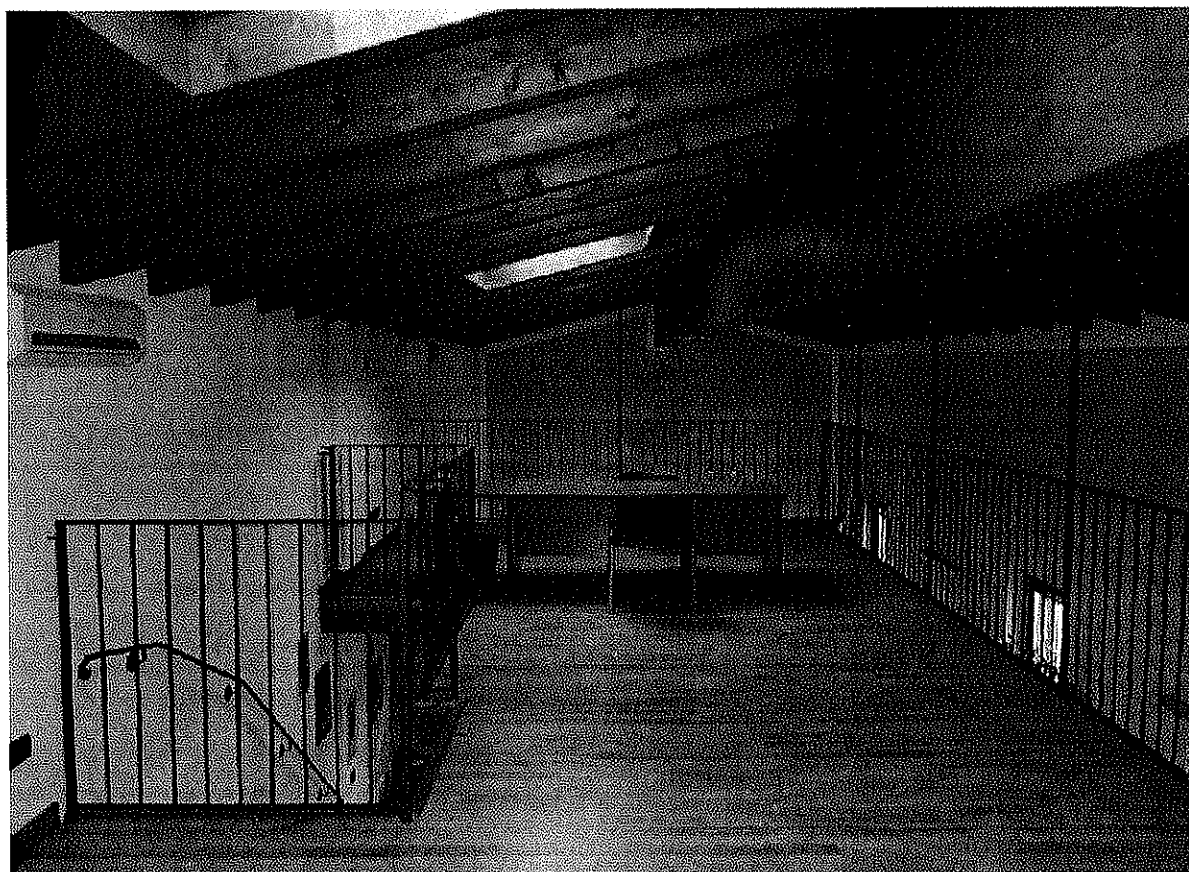
Fig. 39 – Vista d'insieme del soppalco (lato nord)
