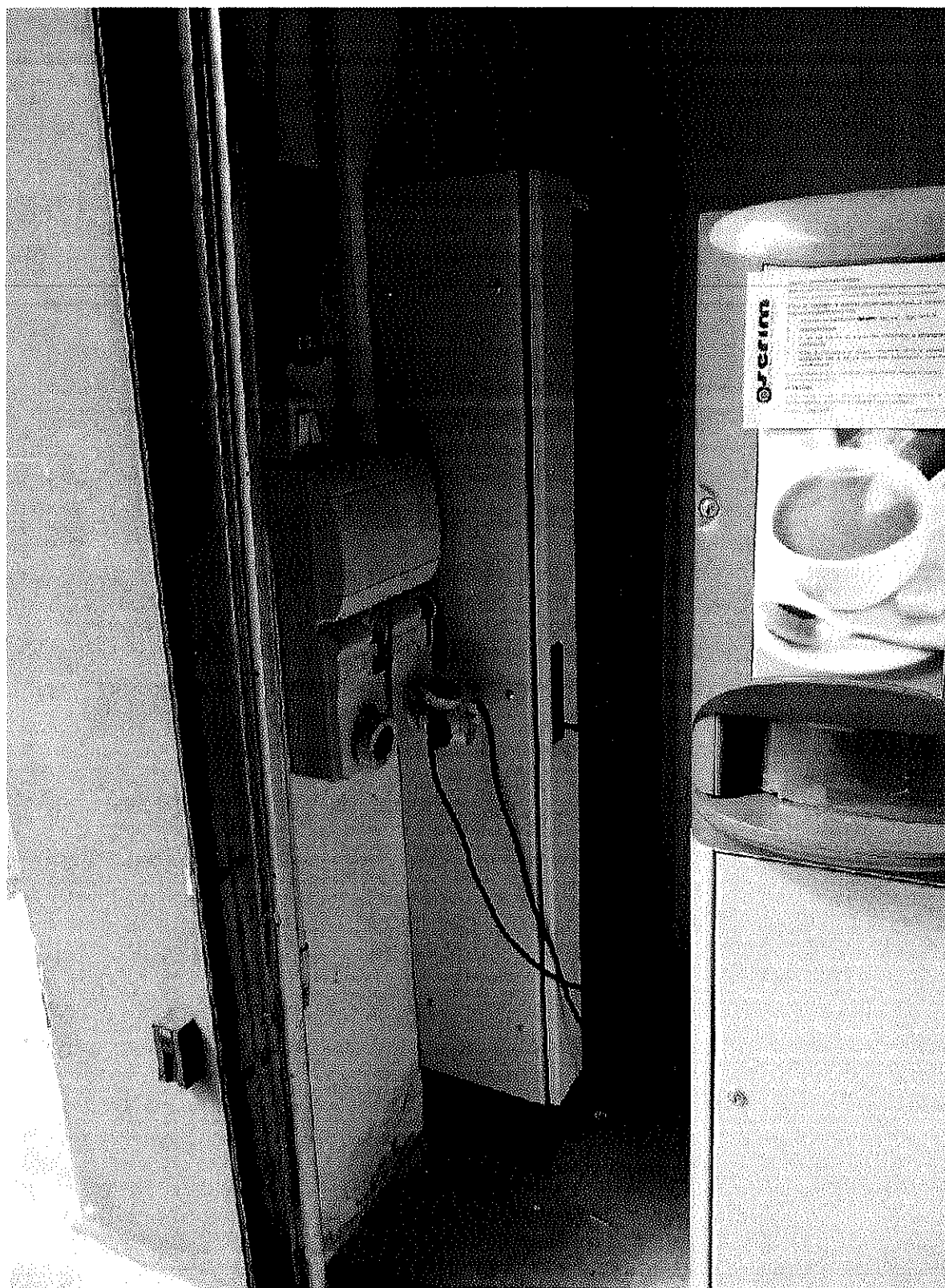
Fig. 22 – Vista del quadro elettrico e dell'armadietto installati all'interno del laboratorio/magazzino
