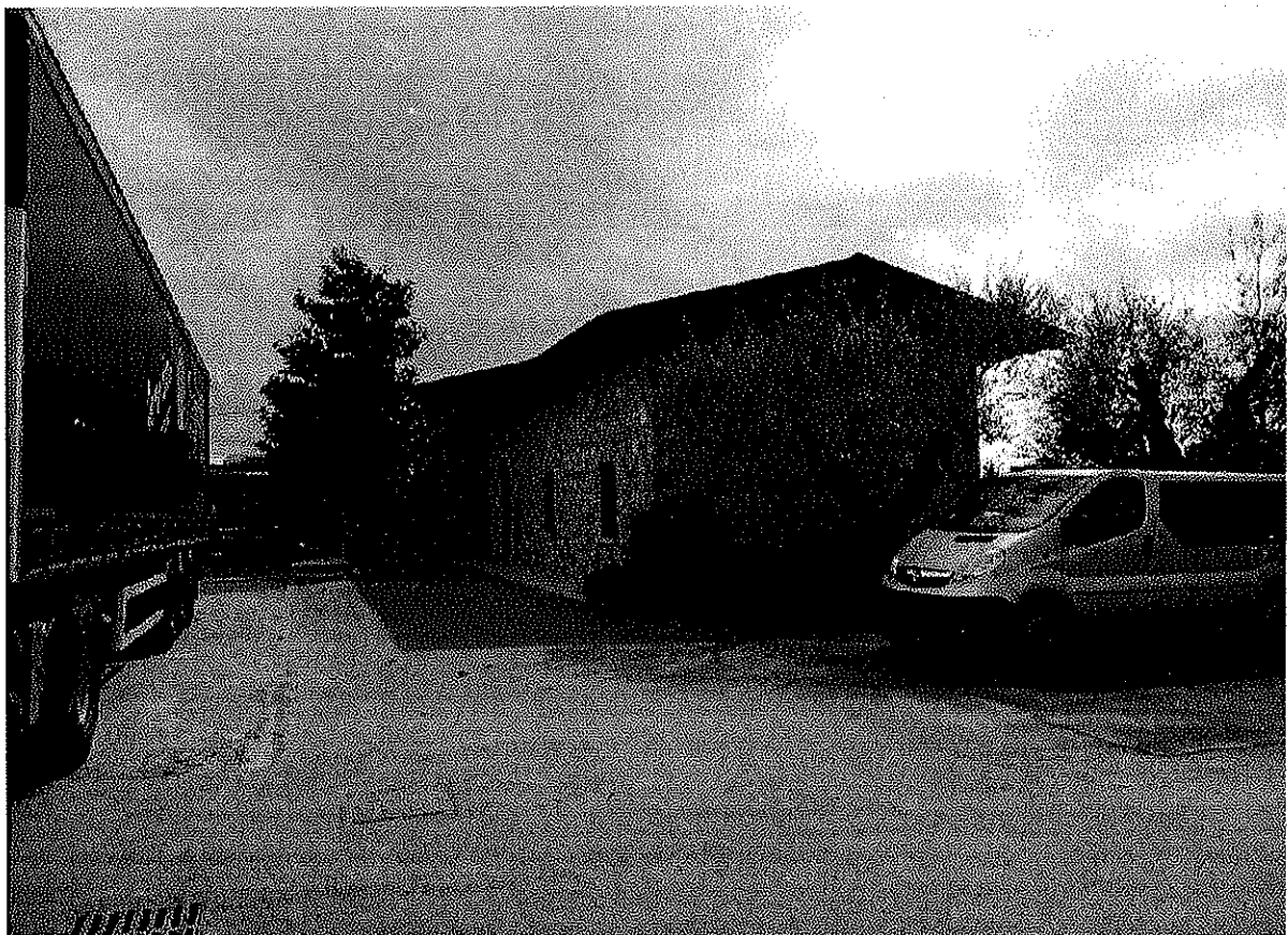
Fig. 14 – Vista del prospetto nord del fabbricato magazzino/uffici (mapp. 672, sub.704)
