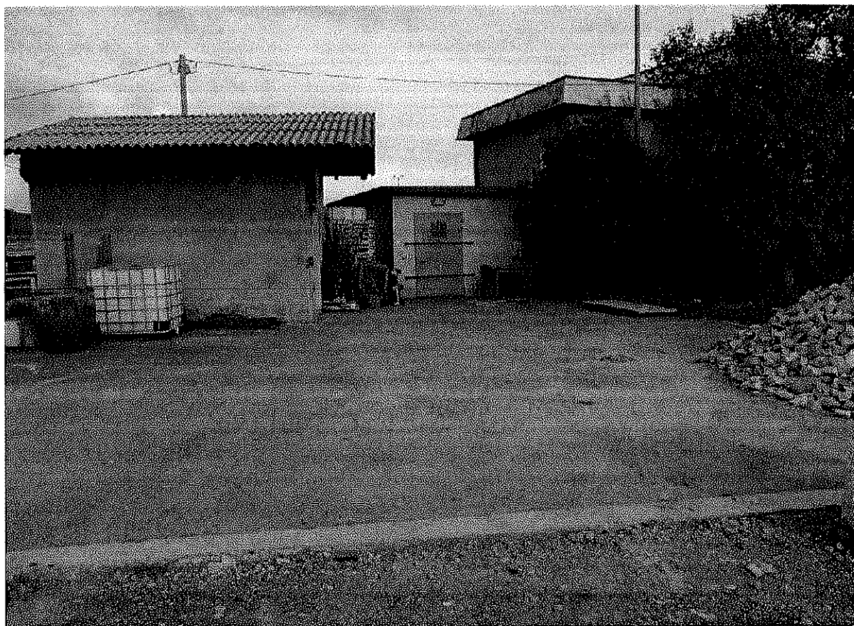
Fig. 5 – Vista del deposito (tinteggiato arancione) con antistante piazzale asfaltato (mapp. 8995)
