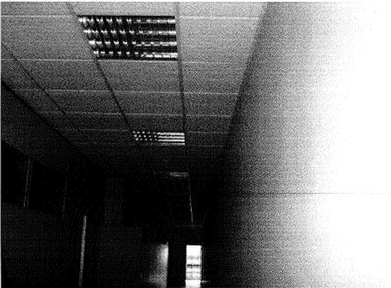
P. PRIMO CONTROSOFFITTO
