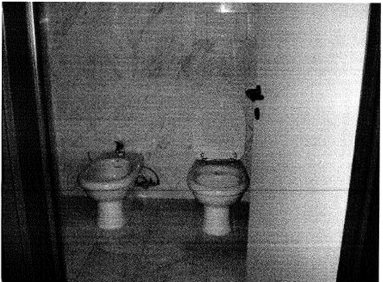
P. PRIMO BAGNO INGRESSO
