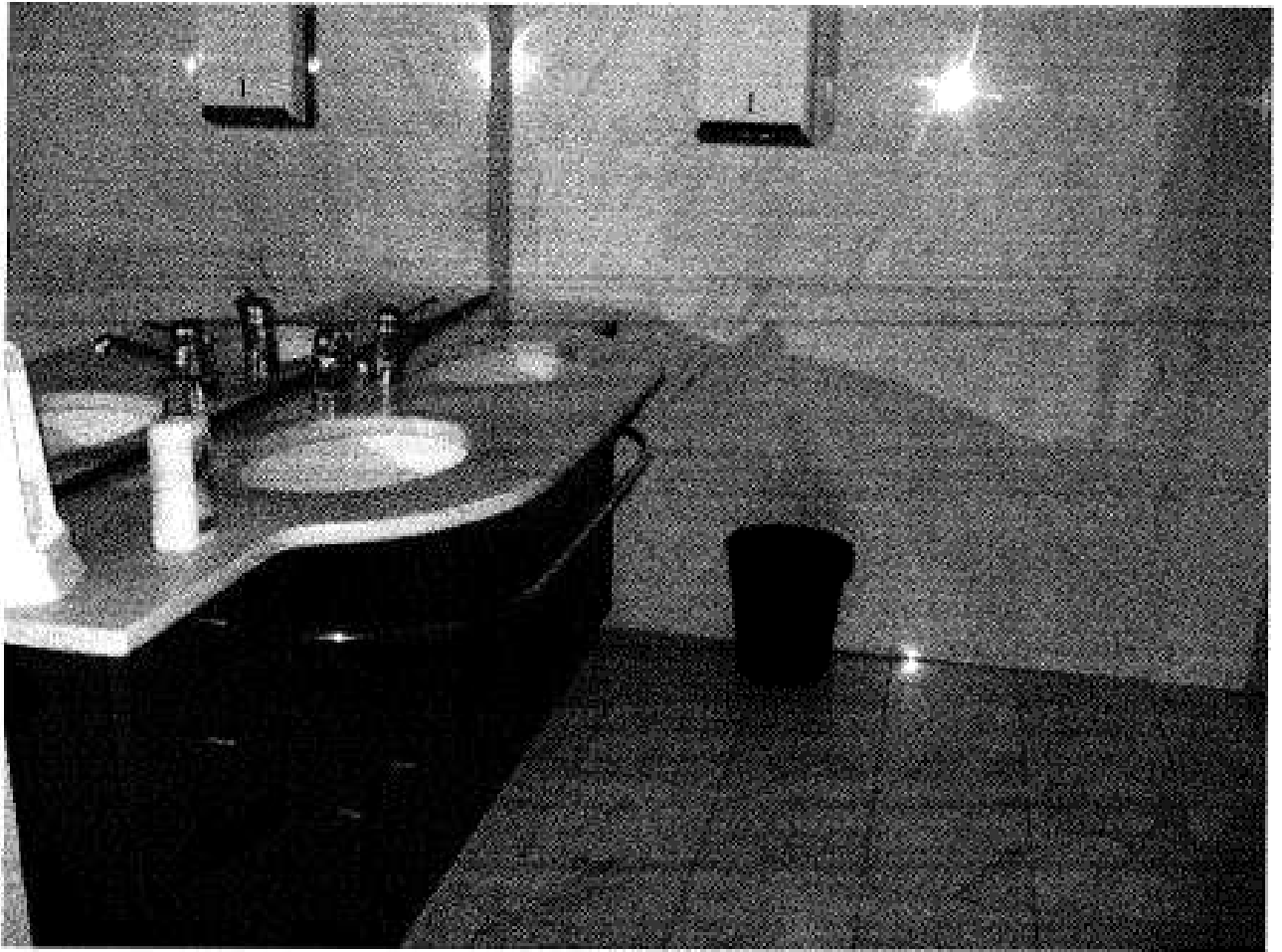
P. PRIMO BAGNO INGRESSO
