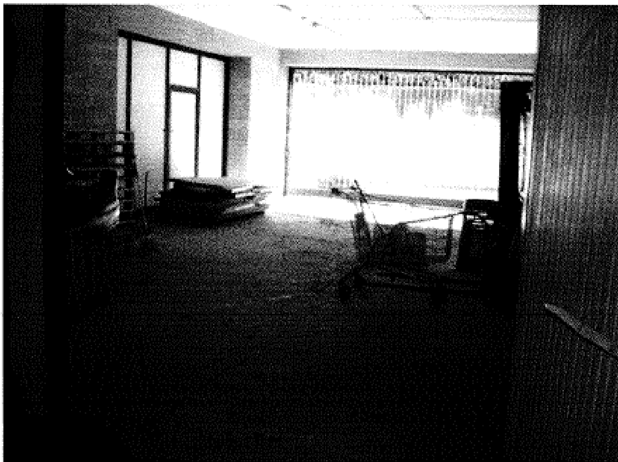
INTERRATO ZONA SCARICO
