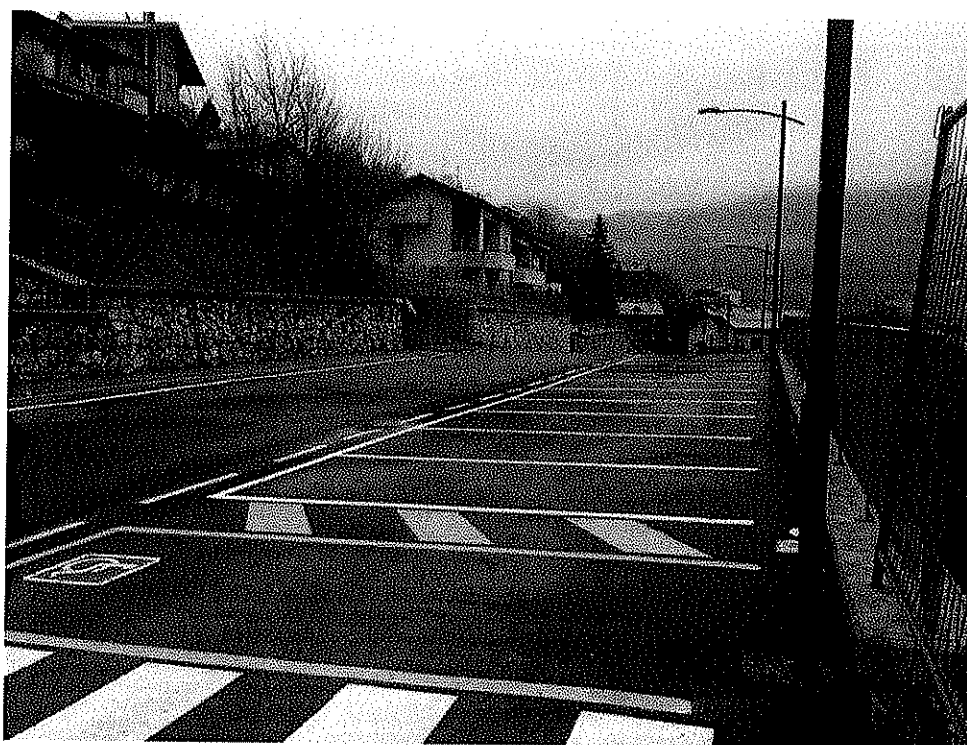
Strada di lottizzazione - vista da ovest
