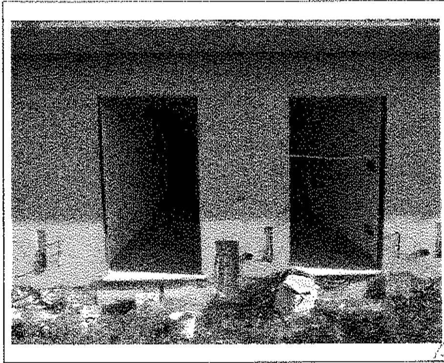
- Lotto n. A01: mapp. 482, fabbricato F2, u.i.u. n°3: prospetto Sud -
