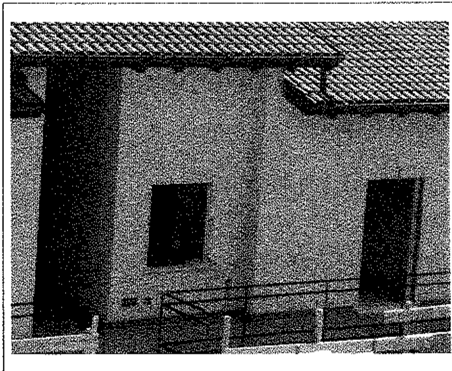
- Lotto n. A01: mapp. 482, fabbricato F5, u.i.u. n°6: prospetto Nord -
