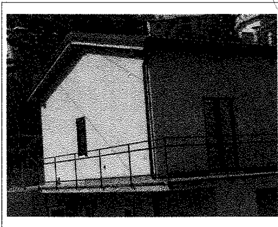
- Lotto n. A01: mapp. 482, Fabbricato F1, u.i.u. n°3: prospetti Sud-Ovest e Sud-Est -
