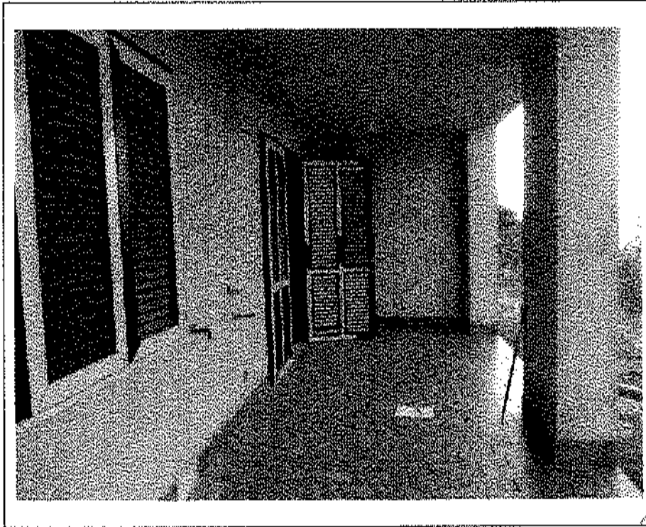
- Lotto n. A01: mapp. 482, Fabbricato F4, u.i.u. n°1: porticato su prospetto Sud -
