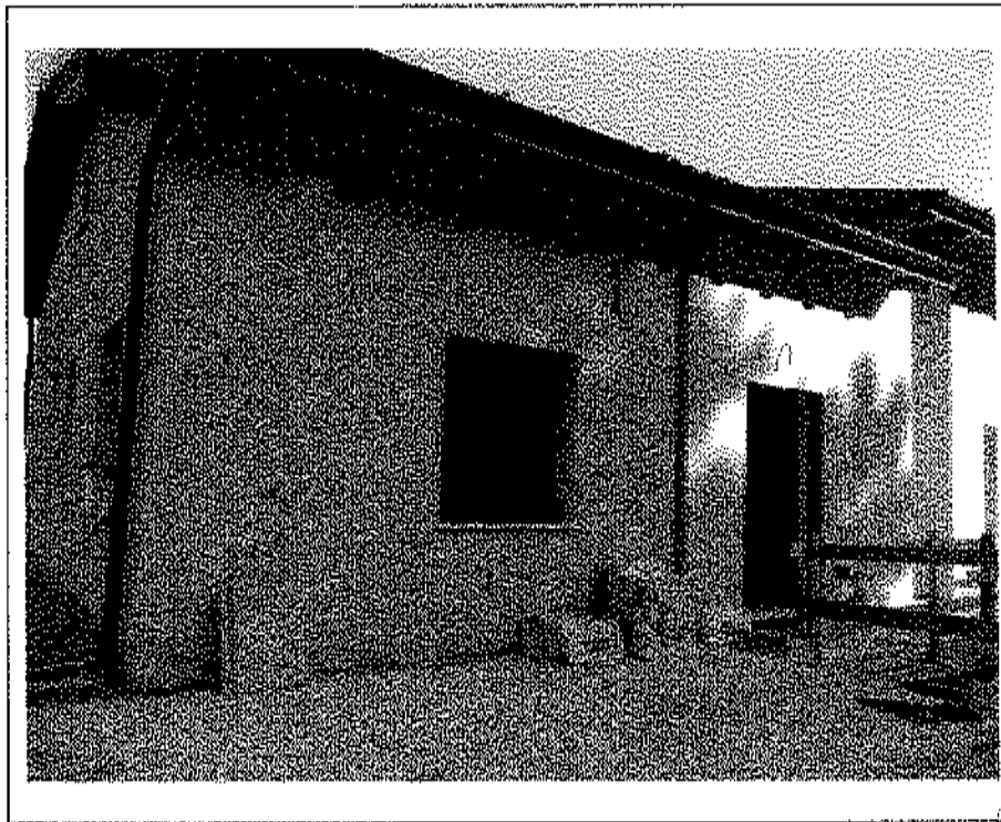
- Lotto n. A01: mapp. 482, fabbricato F3, u.i.u. n°7: prospetto Nord-Ovest -
