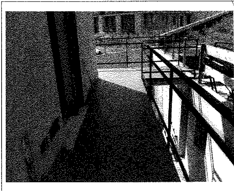
- Lotto n. A01: mapp. 482, fabbricato F5, u.i.u. n°5: balcone su prospetto Nord -
