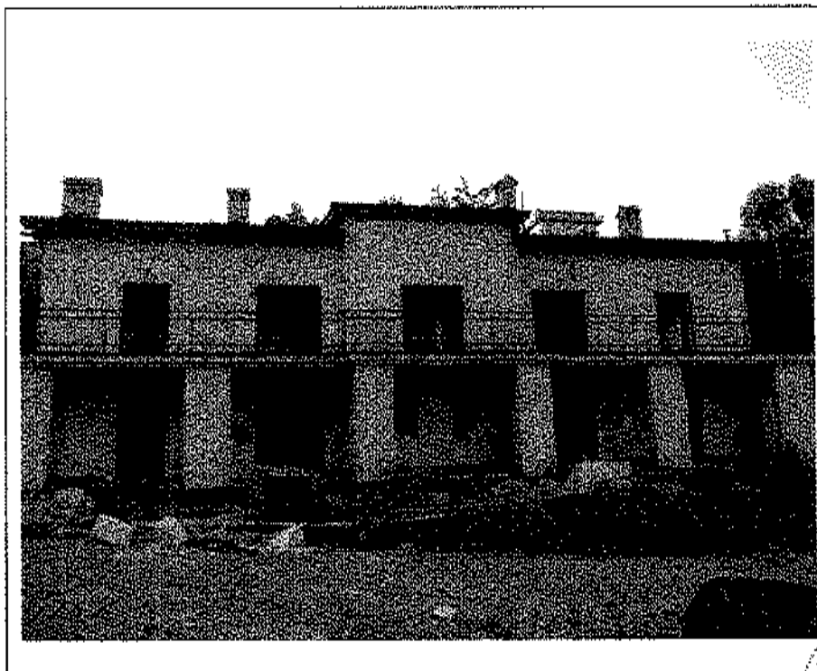
- Lotto n. A01: Fabbricato F3 denominato "Vernazza": prospetto Sud-Est, insistente sul mapp. 482 -
