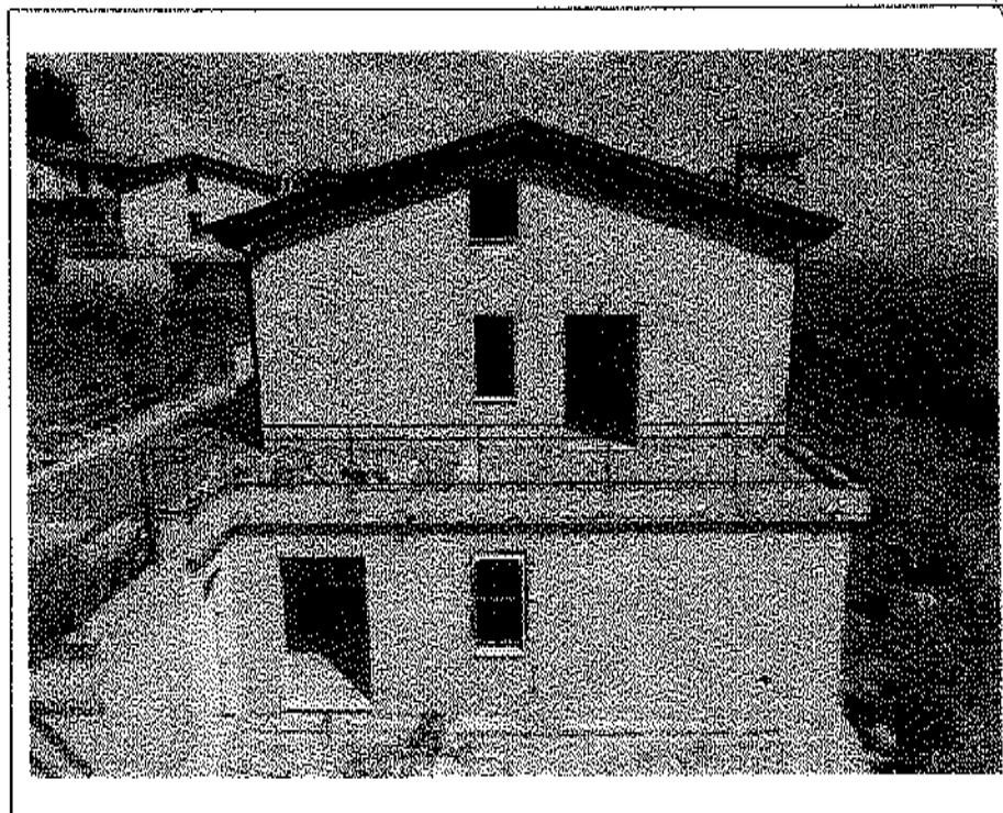
- Lotto n. A01: Fabbricato F2 denominato "Manarola": prospetto Ovest, insistente sul mapp. 482 -
