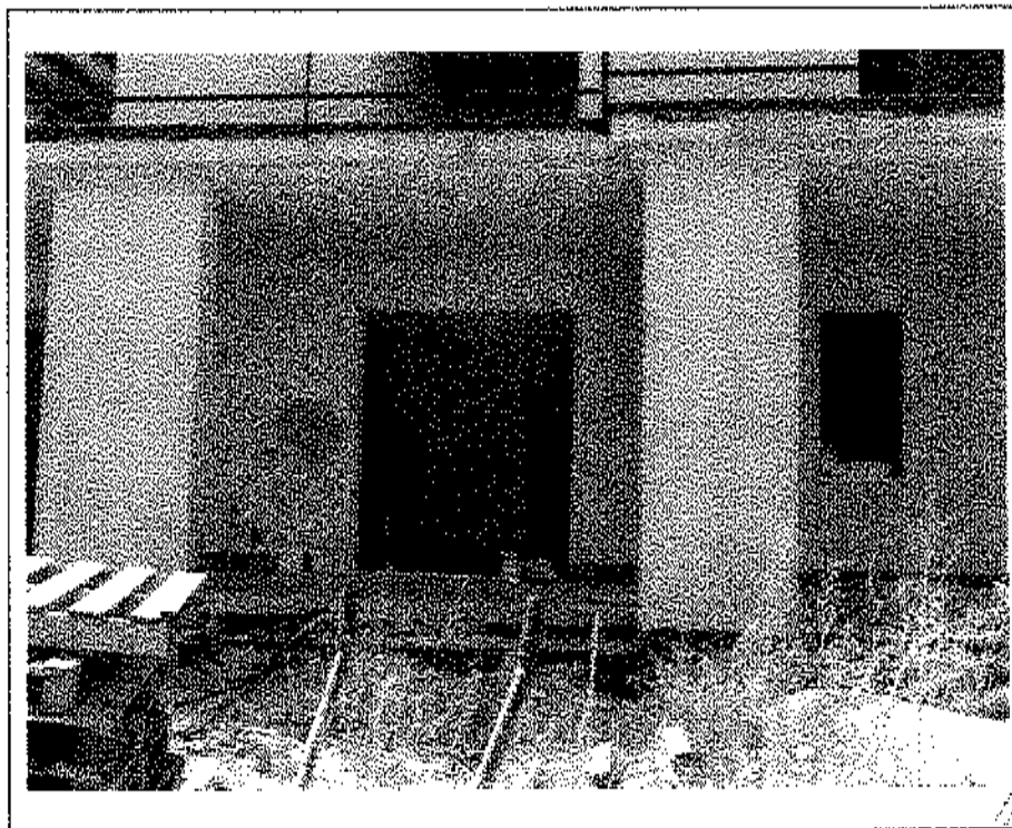
- Lotto n. A01: mapp. 482, fabbricato F3, u.i.u. n°2: prospetto Sud-Est -
