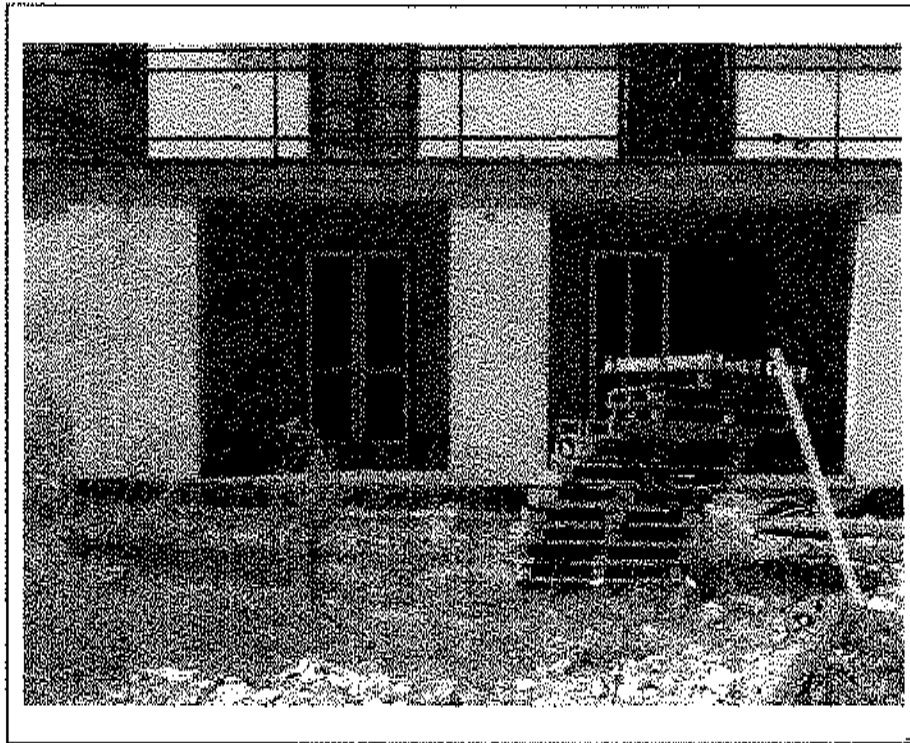
- Lotto n. A01: mapp. 482, Fabbricato F1, u.i.u. n°1: prospetto Sud-Est -
