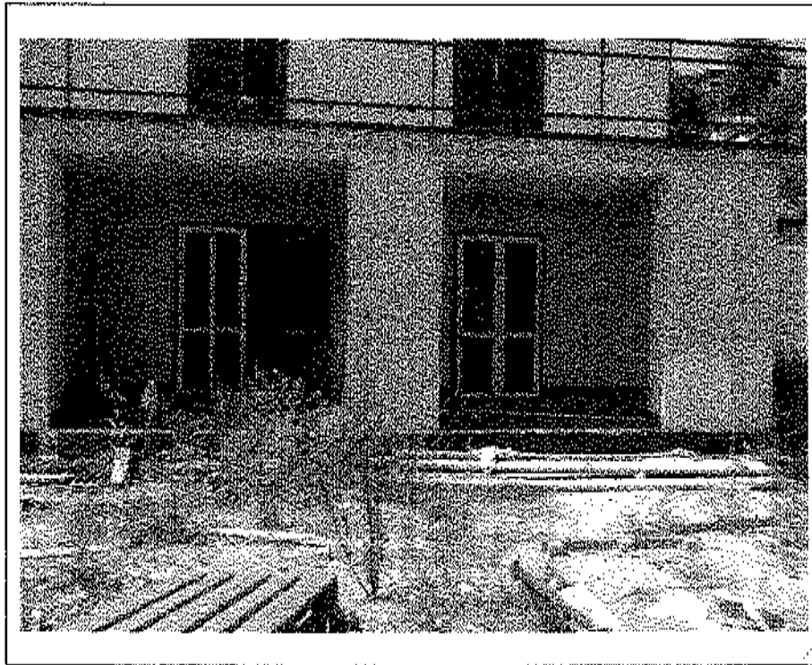
- Lotto n. A01: mapp. 482, Fabbricato F1, u.i.u. n°2: prospetto Sud-Est -
