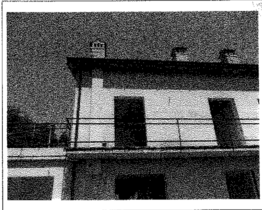
- Lotto n. A01: mapp. 482, fabbricato F2, u.i.u. n°6: prospetto Sud -
