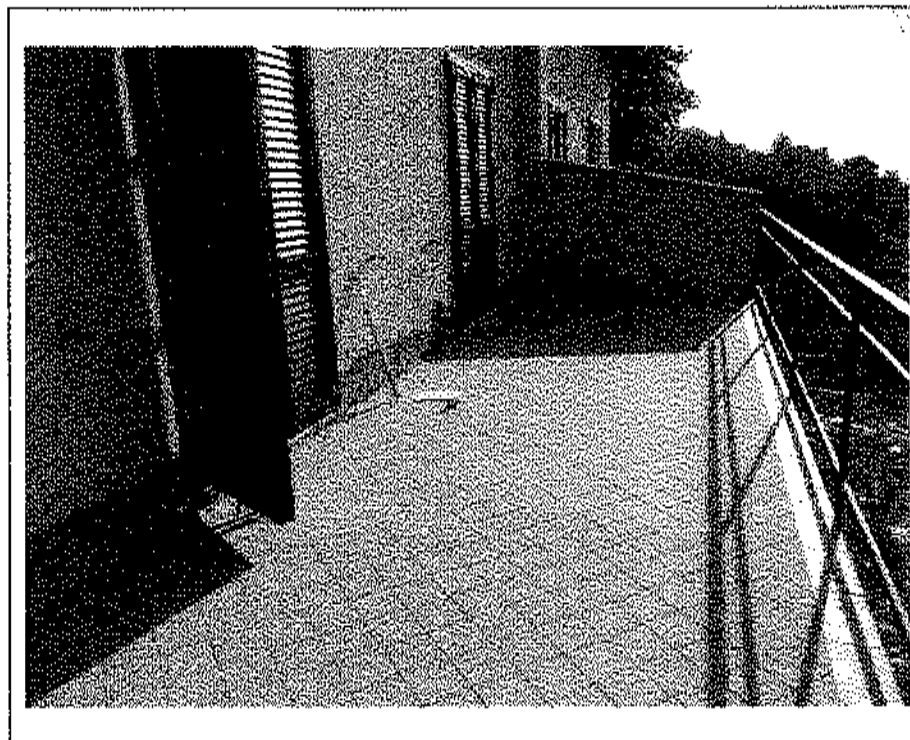
- Lotto n. A01: mapp. 482, fabbricato F4, u.i.u. n°3: terrazzo su prospetto Sud -
