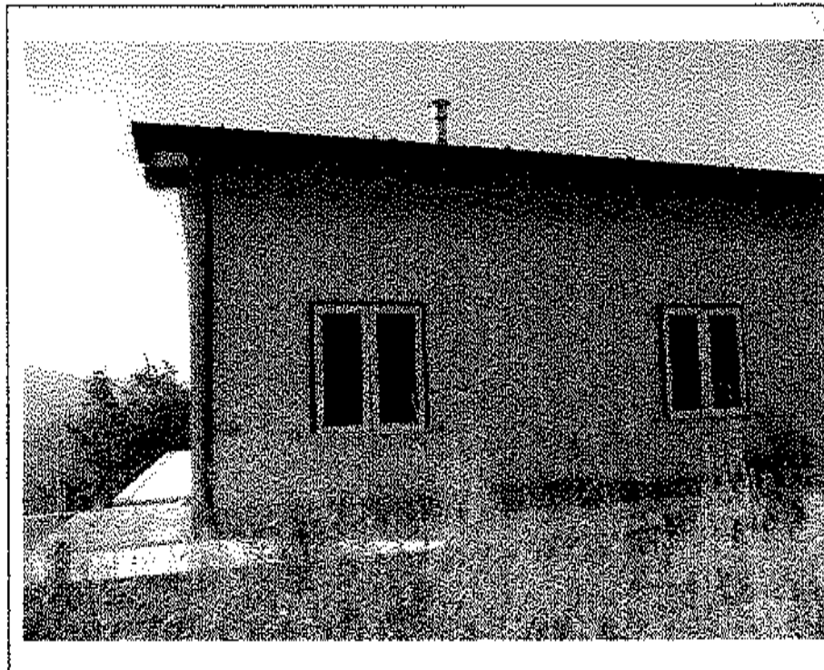
- Lotto n. A01: mapp. 482, fabbricato F4, u.i.u. n°4: prospetto Nord -
