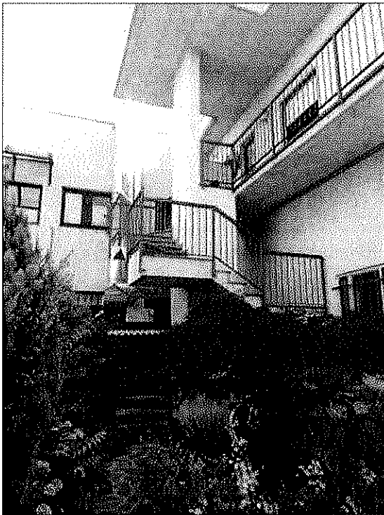
FOTOGRAFIA 41 - Vano scala esterno
