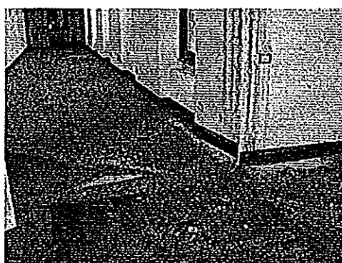
PARTICOLARI DEI DANNI PROVOCATI SUGLI INTONACI E SUI PAVIMENTI
