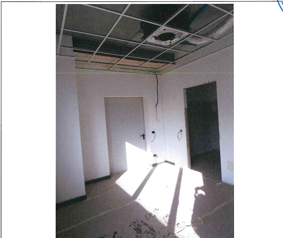
- Lotto 2: capannone industriale in Via delle Orobie, 282 a Urgnano (BG) – interno uffici: spogliatoio sx p.t. -
