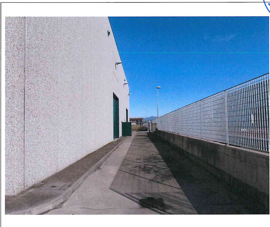
- Lotto 2: capannone industriale in Via delle Orobie, 282 a Urgnano (BG): area esterna su prospetto Est -
