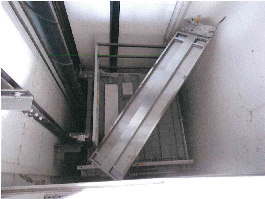
- Lotto 2: capannone industriale in Via delle Orobie, 282 a Urgnano (BG) – interno uffici: vano ascensore visto dal p. primo -
