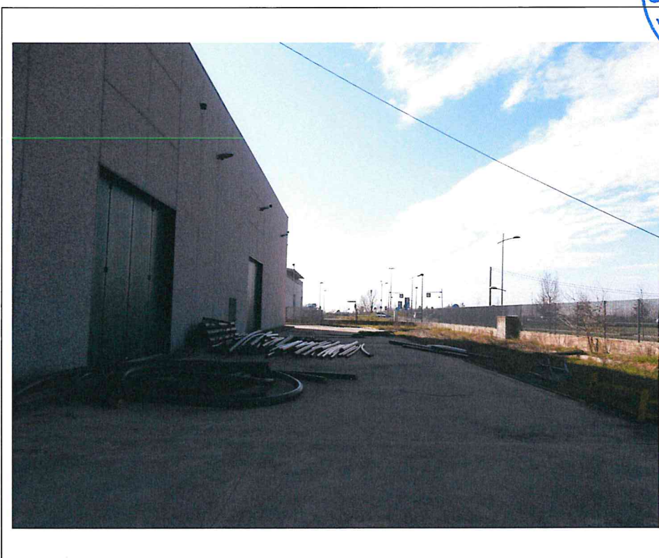
- Lotto 2: capannone industriale in Via delle Orobie, 282 a Urgnano (BG): area esterna su prospetto Ovest -
