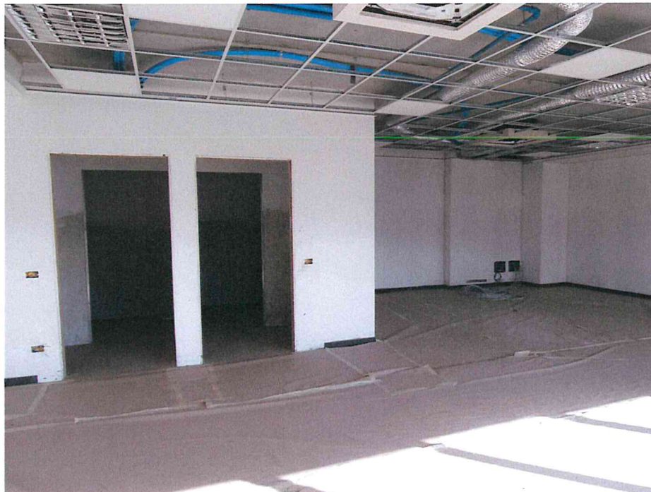
- Lotto 2: capannone industriale in Via delle Orobie, 282 a Urgnano (BG) – interno uffici: ufficio sx p.primo -
