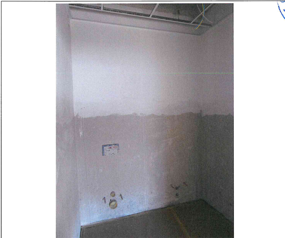
- Lotto 2: capannone industriale in Via delle Orobie, 282 a Urgnano (BG) – interno uffici: bagno 1 ufficio sx p. primo -
