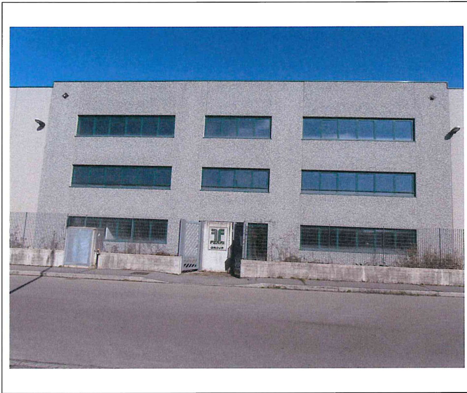
- Lotto 2: capannone industriale in Via delle Orobie, 282 a Ugnano (BG): prospetto Sud uffici -
