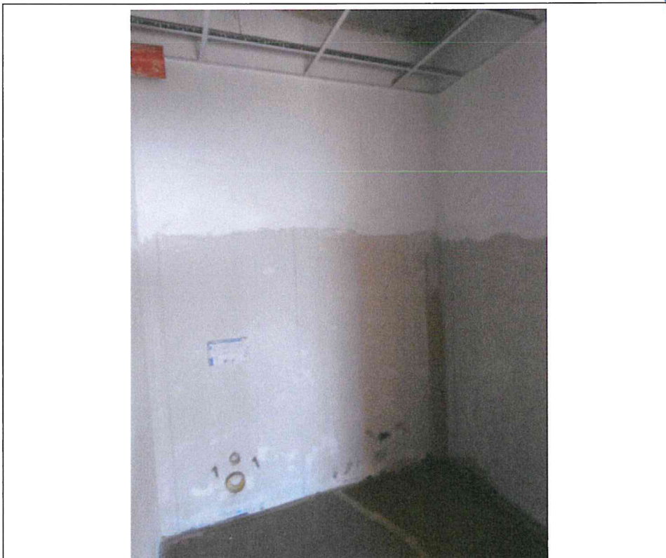
- Lotto 2: capannone industriale in Via delle Orobie, 282 a Urgnano (BG) – interno uffici: bagno 1 sx p. secondo -
