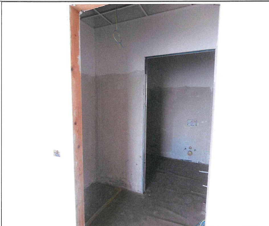
- Lotto 2: capannone industriale in Via delle Orobie, 282 a Urgnano (BG) – interno uffici: antibagno 1 dx p. secondo -
