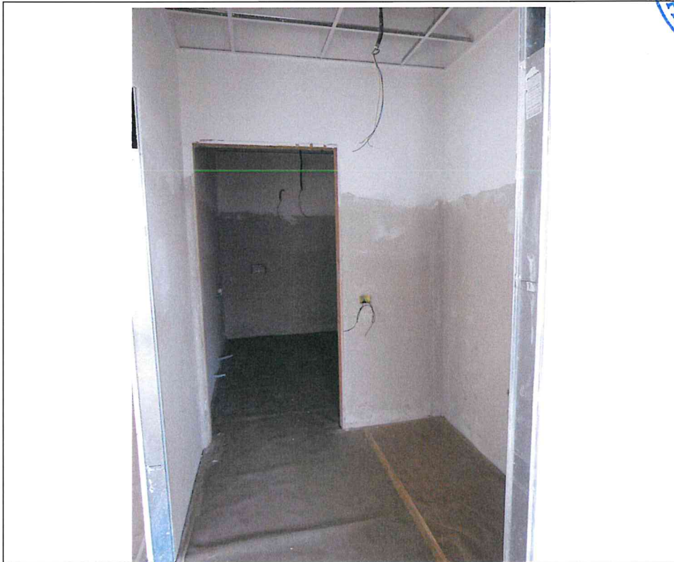
- Lotto 2: capannone industriale in Via delle Orobie, 282 a Urgnano (BG) – interno uffici: antibagno ufficio dx p.t. -
