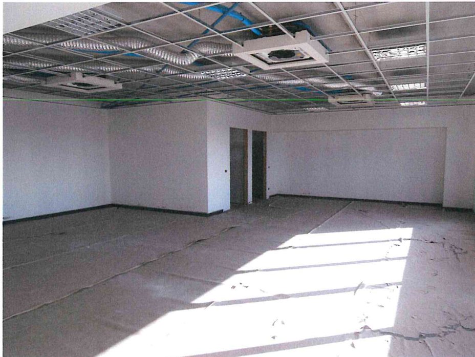
- Lotto 2: capannone industriale in Via delle Orobie, 282 a Urgnano (BG) – interno uffici: ufficio dx p. secondo -
