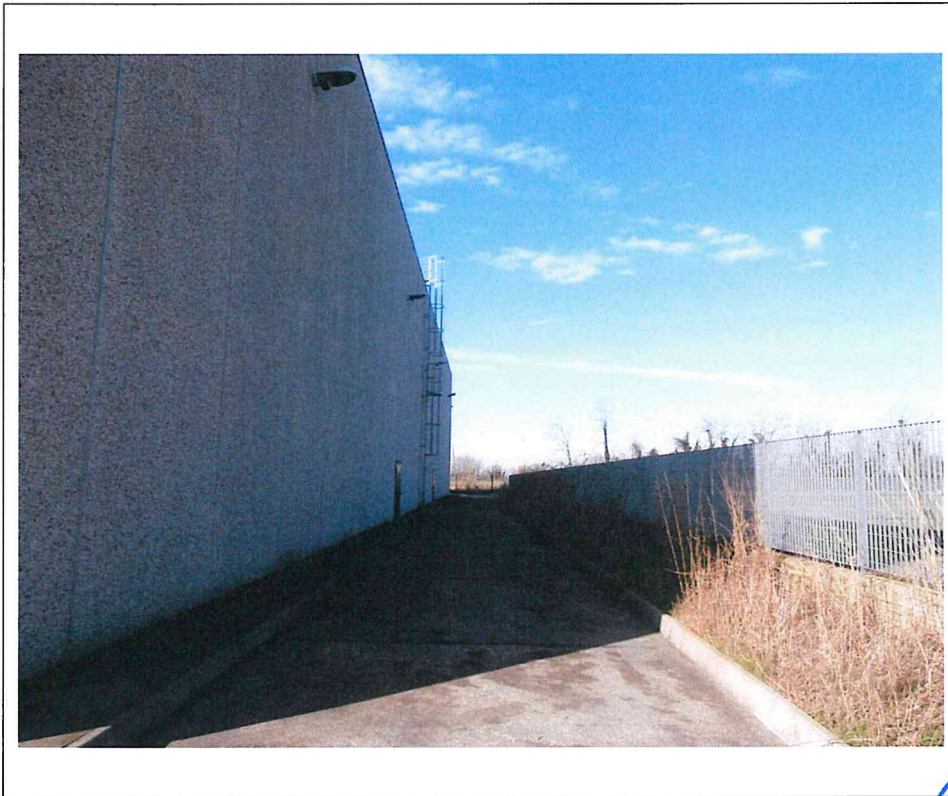
- Lotto 2: capannone industriale in Via delle Orobie, 282 a Urgnano (BG): area esterna su prospetto Nord -
