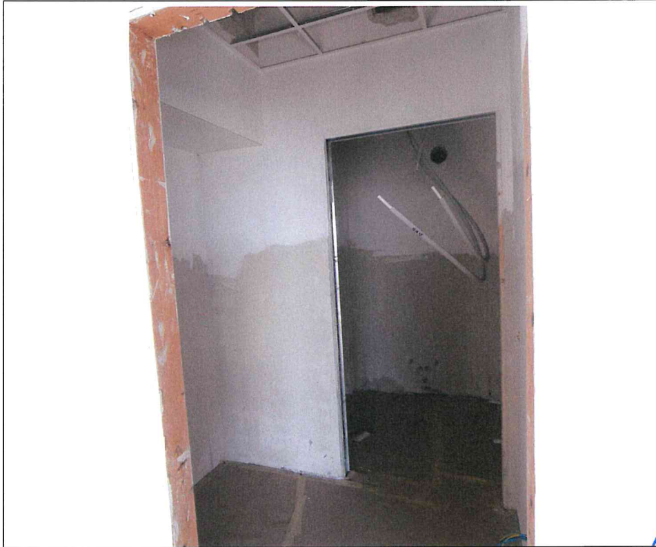
- Lotto 2: capannone industriale in Via delle Orobie, 282 a Urgnano (BG) – interno uffici: antibagno 2 sx p. secondo -
