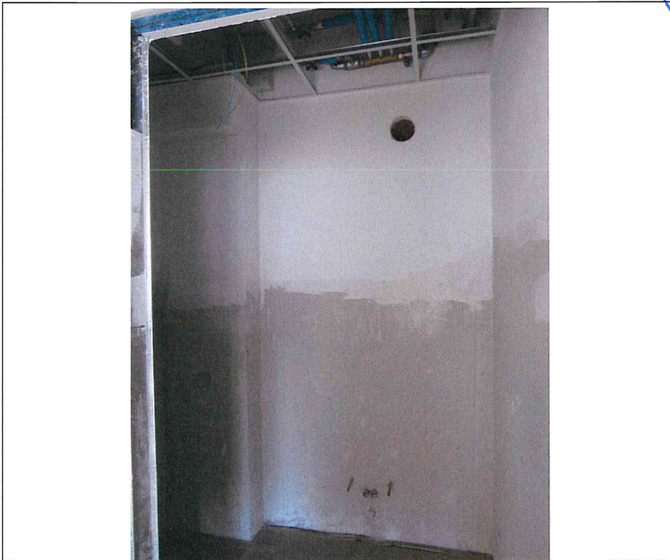
- Lotto 2: capannone industriale in Via delle Orobie, 282 a Urgnano (BG) – interno uffici: bagno 2 ufficio sx p. primo -
