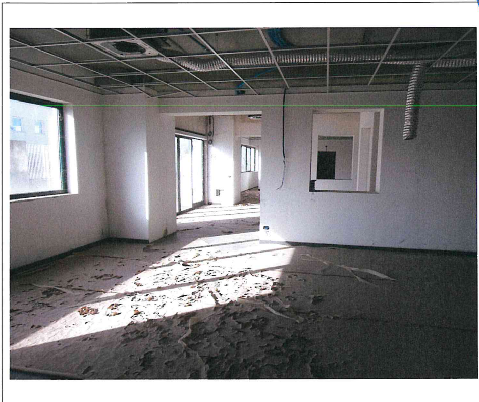
- Lotto 2: capannone industriale in Via delle Orobie, 282 a Urgnano (BG) – interno uffici: ingresso p.t. (vista sx) -
