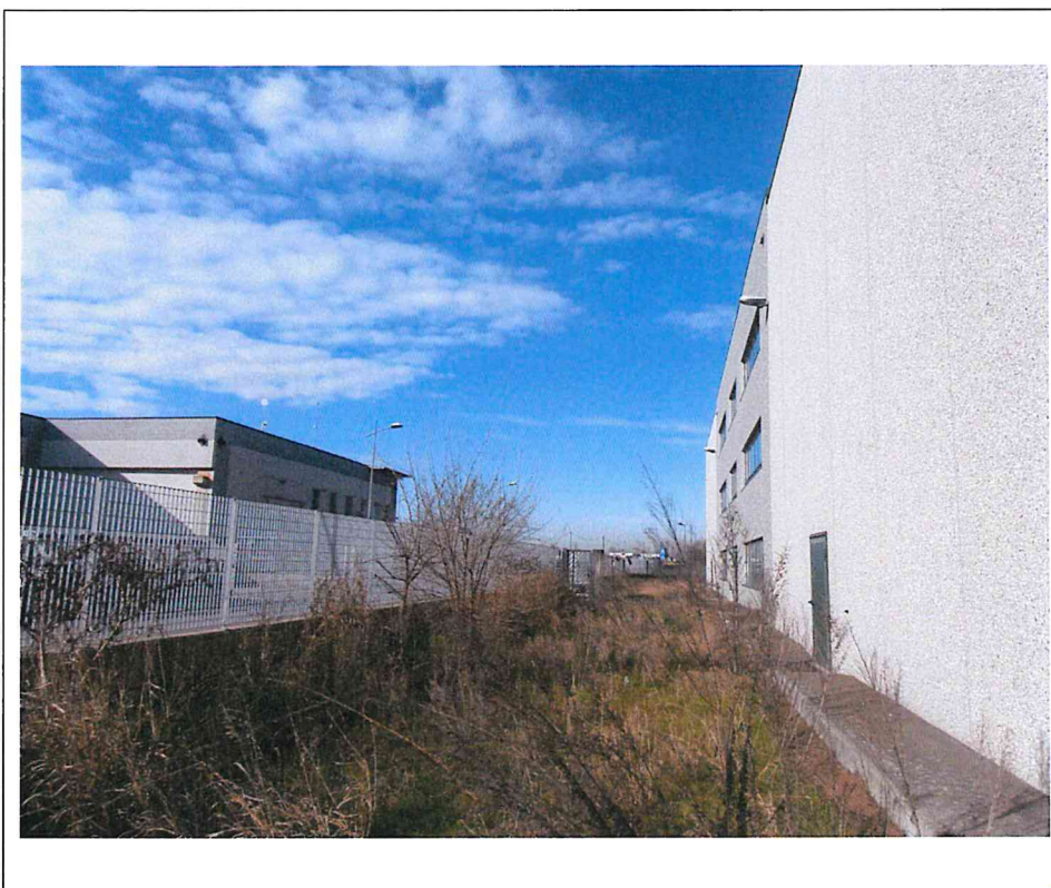
- Lotto 2: capannone industriale in Via delle Orobie, 282 a Urgnano (BG): area esterna su prospetto Sud -
