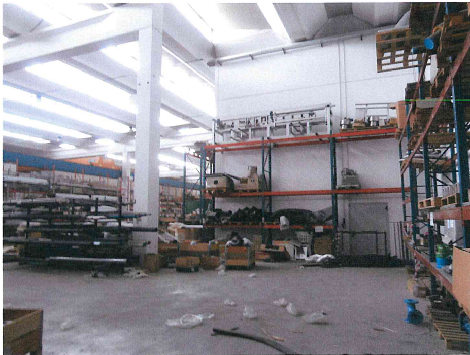
- Lotto 2: capannone industriale in Via delle Orobie, 282 a Ugnano (BG) – interno capannone: angolo Sud-Ovest -
