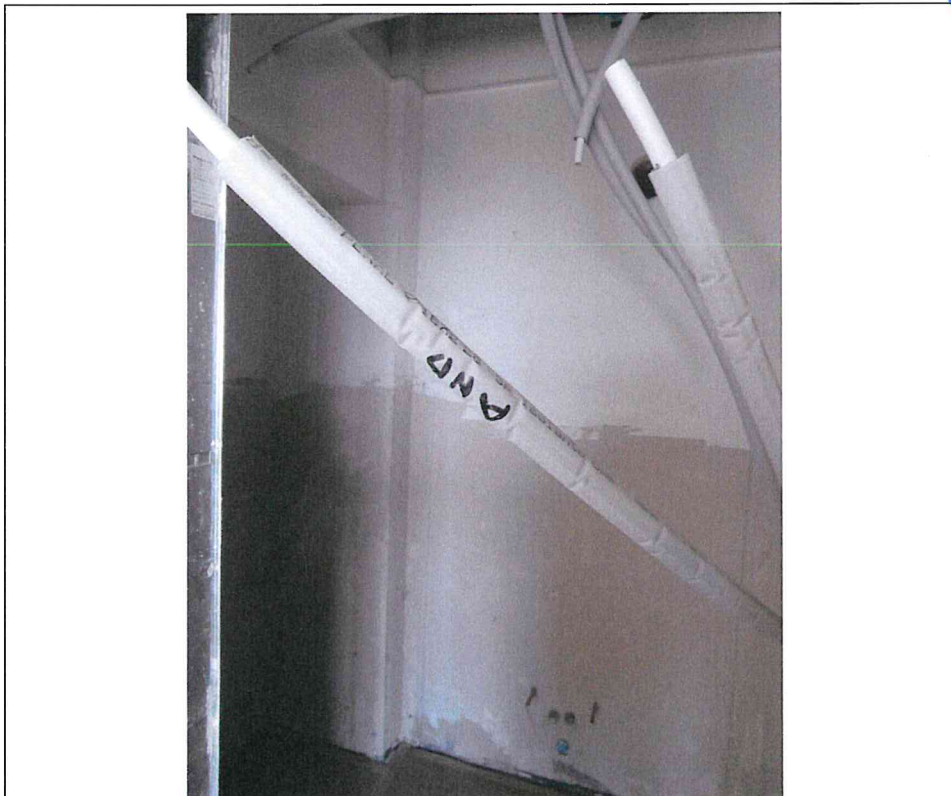
- Lotto 2: capannone industriale in Via delle Orobie, 282 a Urgnano (BG) – interno uffici: bagno 2 sx p. secondo -
