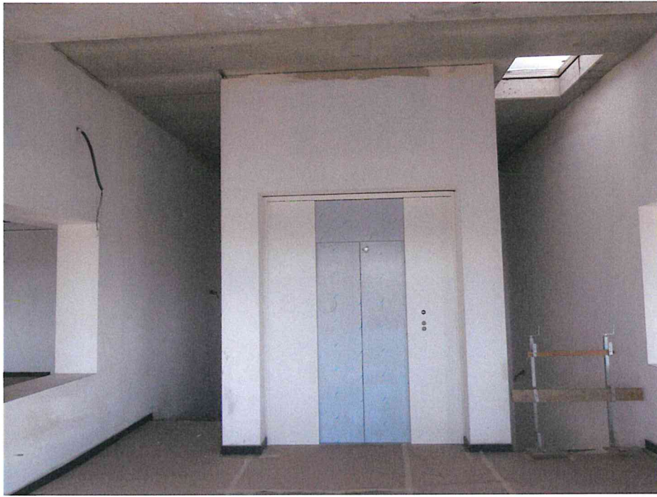
- Lotto 2: capannone industriale in Via delle Orobie, 282 a Ugnano (BG) – interno uffici pianerottolo p. secondo -
