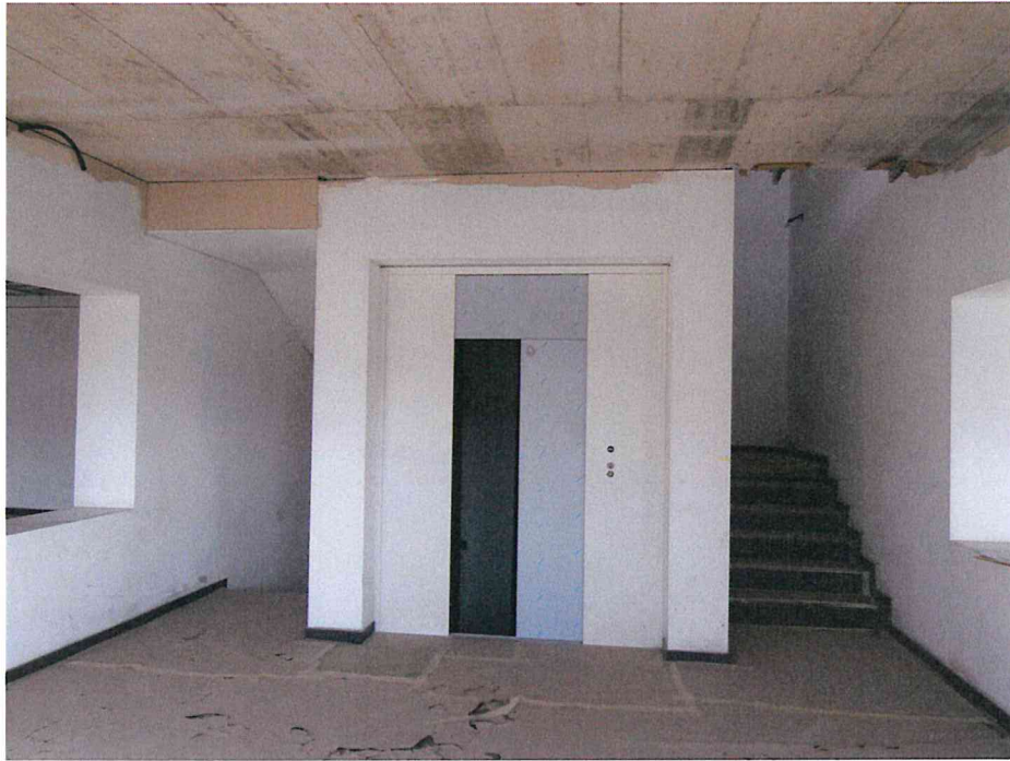
- Lotto 2: capannone industriale in Via delle Orobie, 282 a Urgnano (BG) – interno uffici: pianerottolo p. primo -
