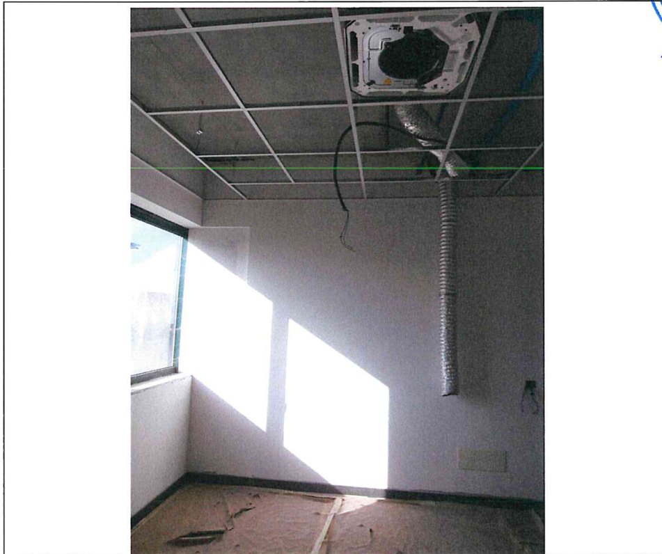
- Lotto 2: capannone industriale in Via delle Orobie, 282 a Urgnano (BG) – interno uffici: spogliatoio dx p.t. -
