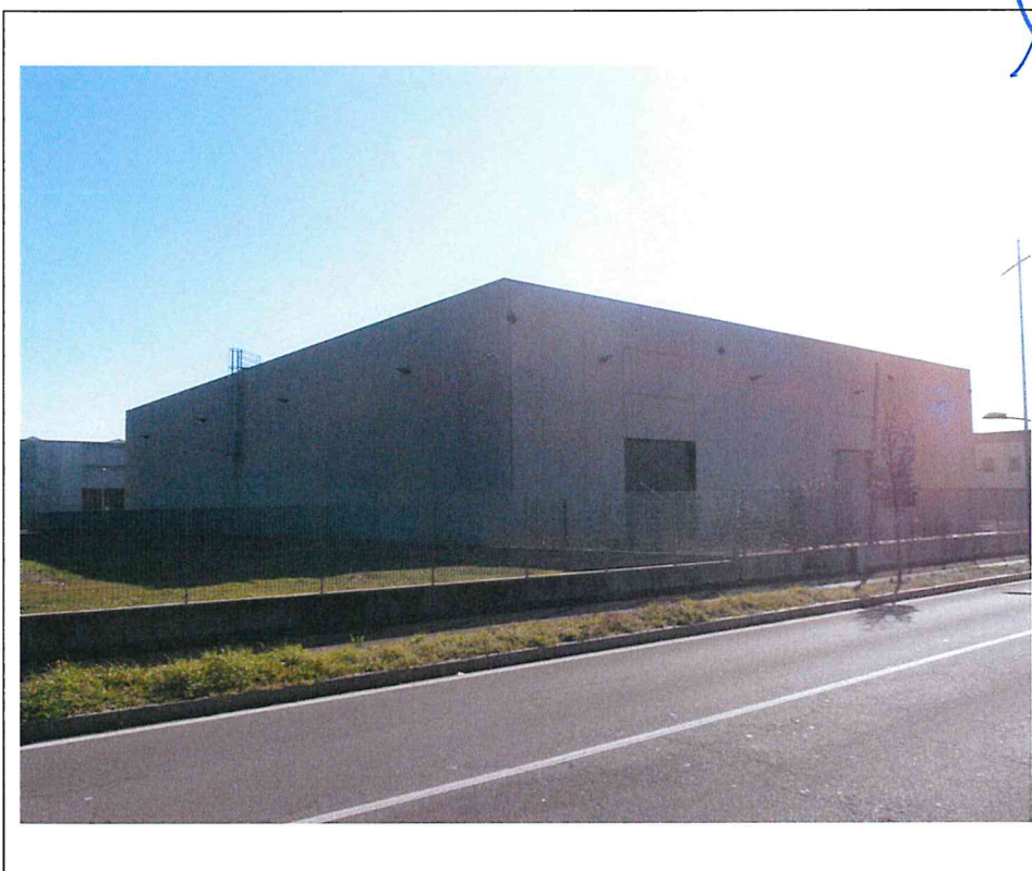
- Lotto 2: capannone industriale in Via delle Orobie, 282 a Urgnano (BG): prospetti Nord e Ovest -
