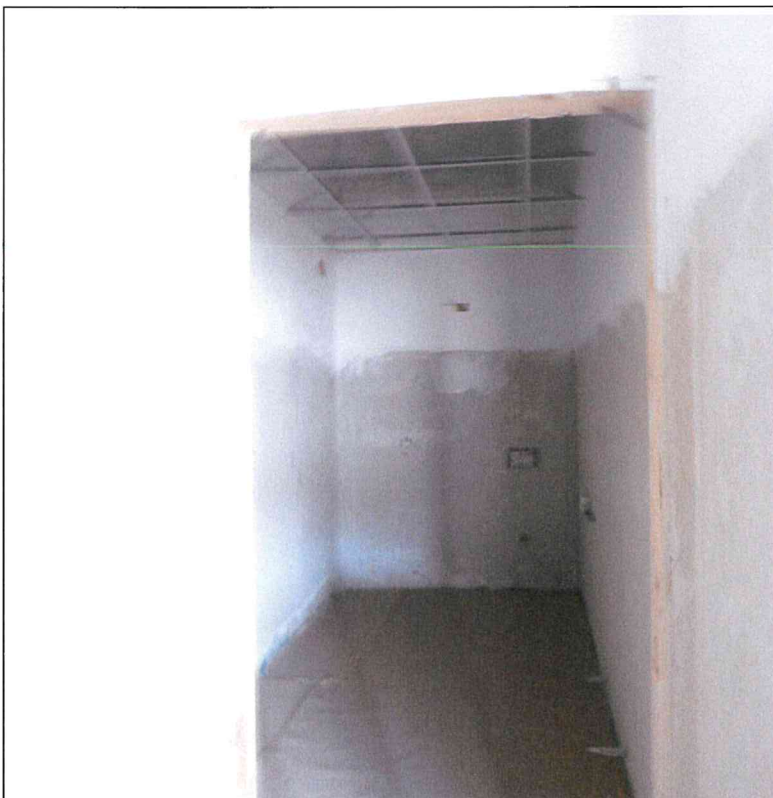
- Lotto 2: capannone industriale in Via delle Orobie, 282 a Urgnano (BG) – interno uffici: bagno capannone sx p.t. -
