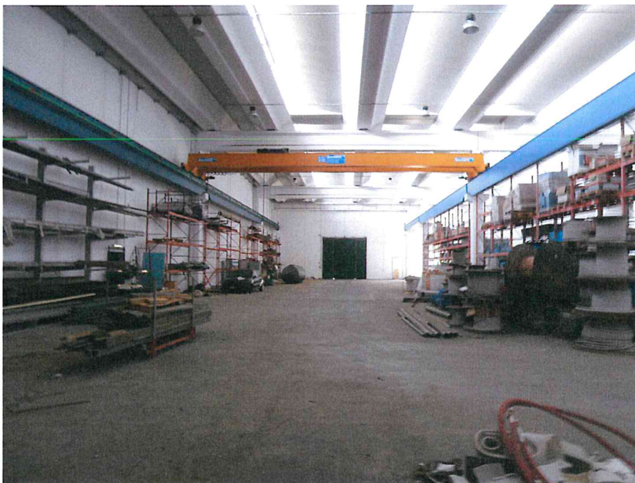
- Lotto 2: capannone industriale in Via delle Orobie, 282 a Urgnano (BG) – interno capannone: campata longitudinale a Nord con carroponete (vista da Ovest a Est) -
