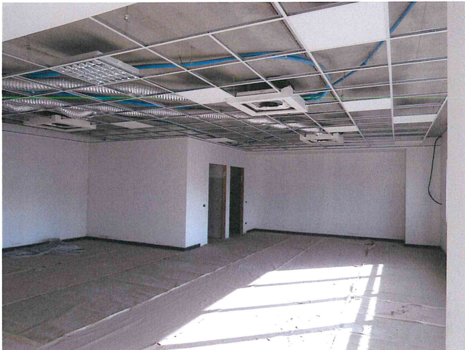
- Lotto 2: capannone industriale in Via delle Orobie, 282 a Urgnano (BG) – interno uffici: ufficio dx p.primo -
