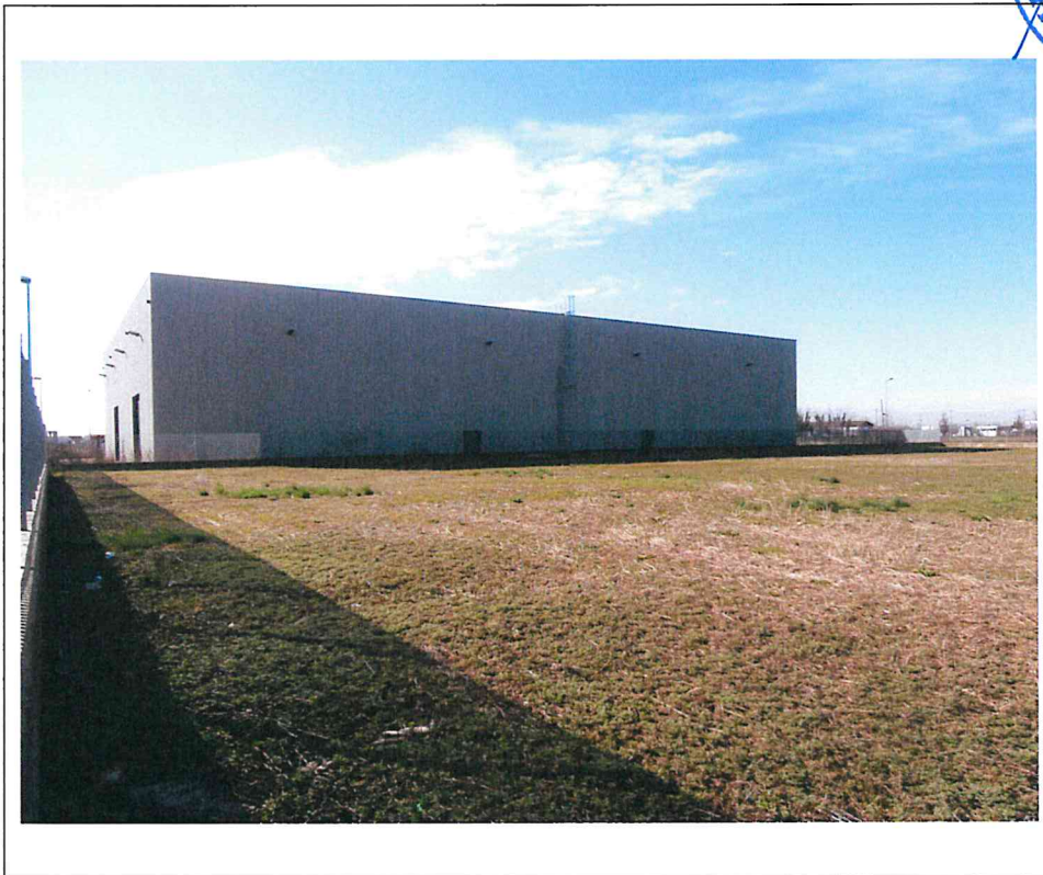
- Lotto 2: capannone industriale in Via delle Orobie, 282 a Urgnano (BG): prospetto Nord-
