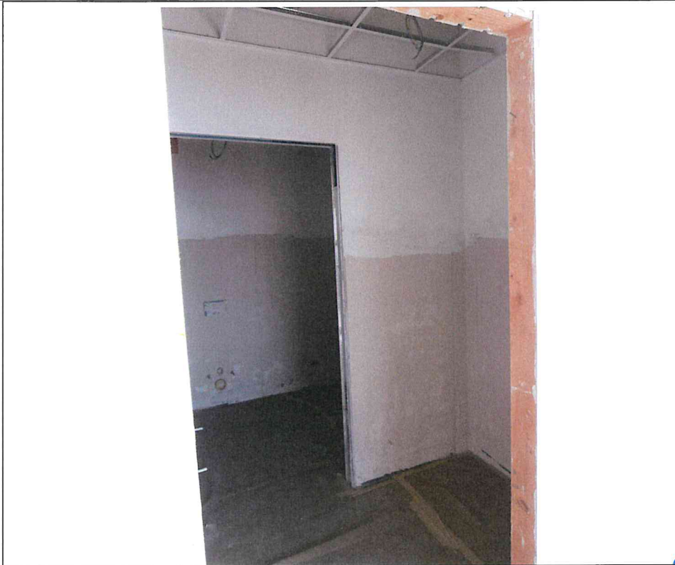
- Lotto 2: capannone industriale in Via delle Orobie, 282 a Urgnano (BG) – interno uffici: antibagno 1 sx p. secondo -
