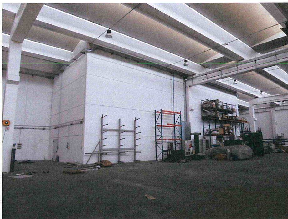
- Lotto 2: capannone industriale in Via delle Orobie, 282 a Urgnano (BG) – interno capannone: campata longitudinale centrale e prospetti interni uffici -
