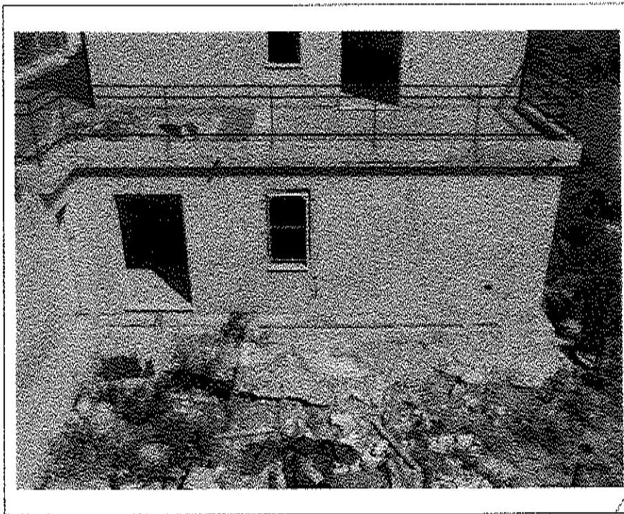
- Lotto n. A01: mapp. 482, fabbricato F2, u.i.u. n°1: prospetto Ovest -
