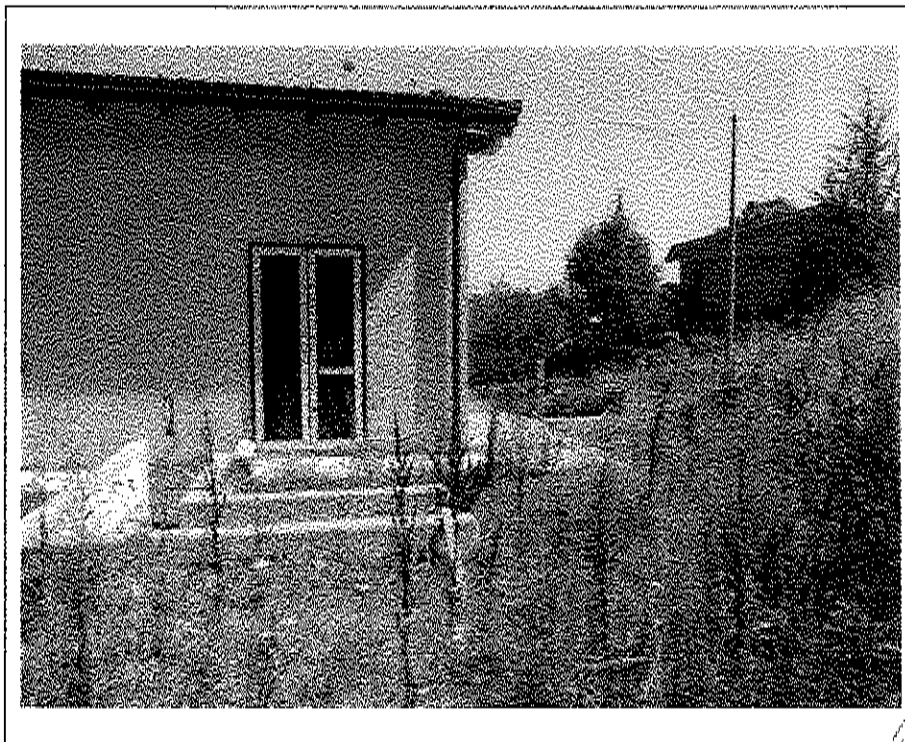
- Lotto n. A01: mapp. 482, Fabbricato F1, u.i.u. n°3: prospetto Nord-Ovest -
