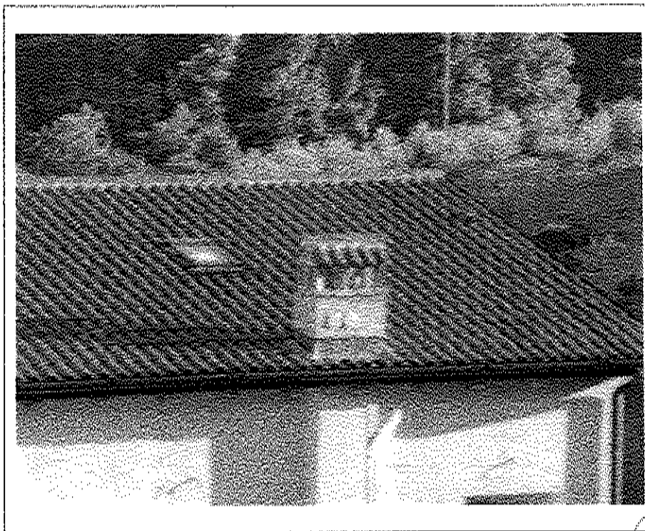
- Lotto n. A01: mapp. 482, fabbricato F2, u.i.u. n°6: falda copertura Nord -
