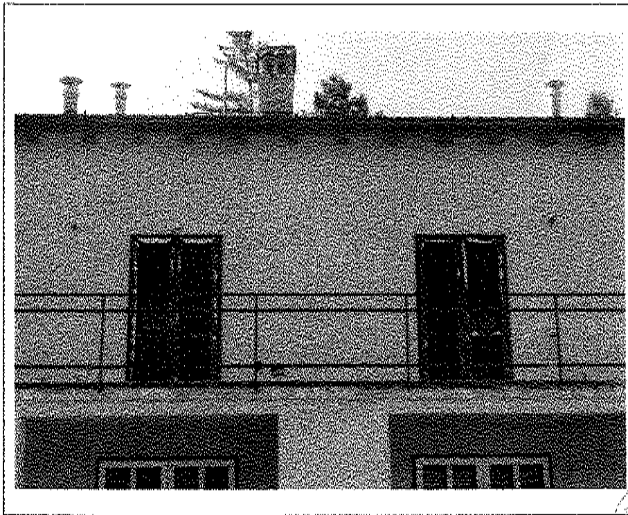
- Lotto n. A01: mapp. 482, Fabbricato F1, u.i.u. n°4: prospetto Sud-Est -
