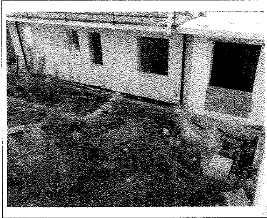
- Lotto n. A01: mapp. 482, fabbricato F3, u.i.u. n°4: prospetto Nord-Est ed area esterna -
