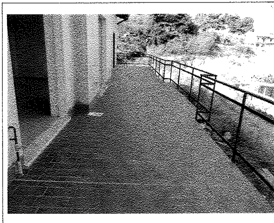
- Lotto n. A01: mapp. 482, fabbricato F3, u.i.u. n°6: terrazzo su prospetto Sud-Est -
