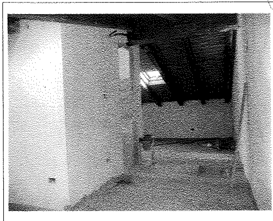
- Lotto n. A01: mapp. 482, fabbricato F5, u.i.u. n°8 – interno: sottotetto porzione Ovest -
