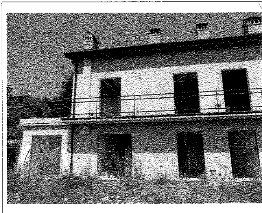
- Lotto n. A01: Fabbricato F2 denominato "Manarola": prospetto Sud, insistente sul mapp. 482 -
