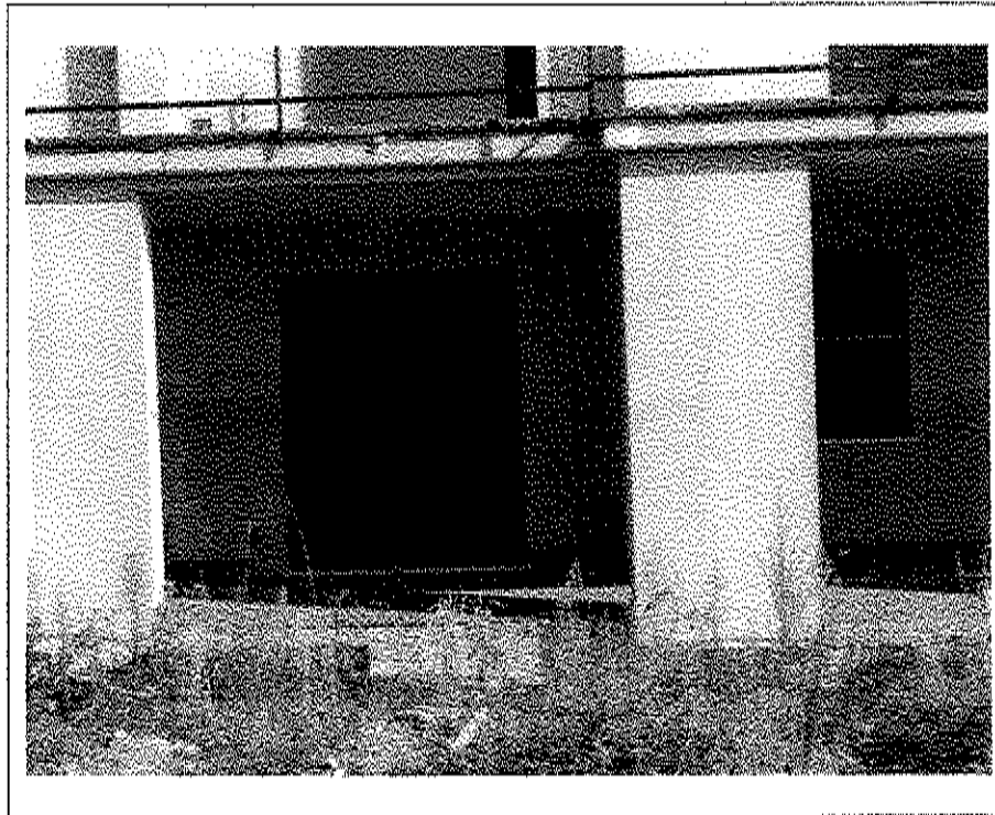
- Lotto n. A01: mapp. 482, fabbricato F5, u.i.u. n°2: prospetto Sud -
