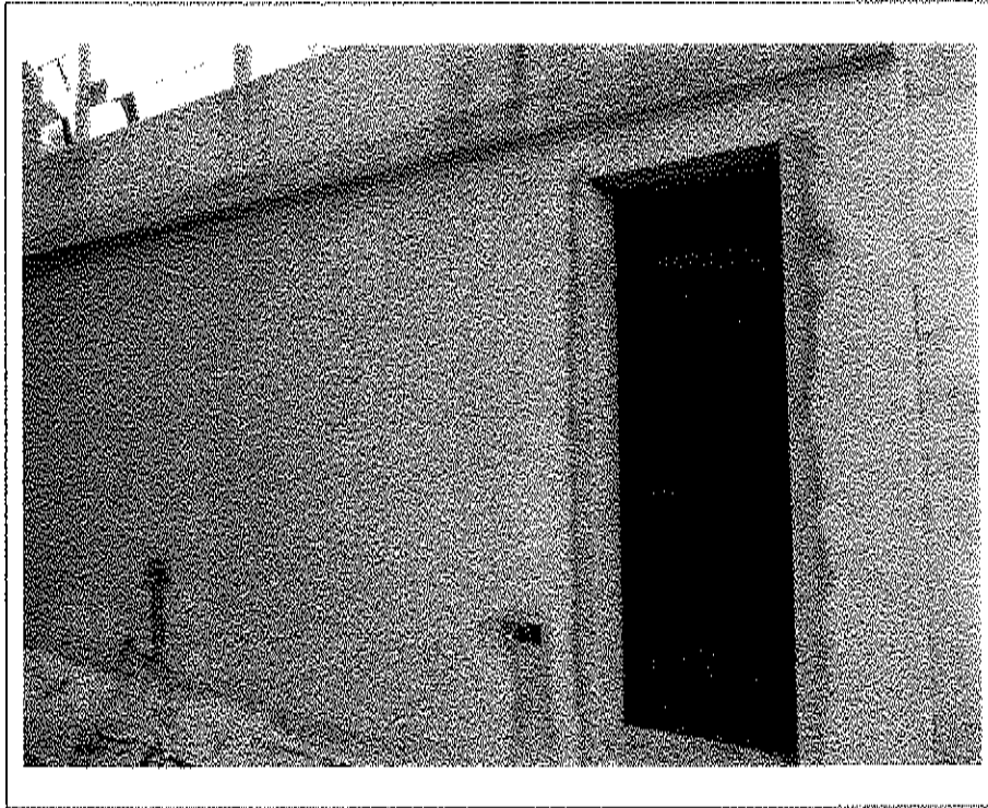
- Lotto n. A01: mapp. 482, fabbricato F5, u.i.u. n°4: prospetto Sud cantina -
