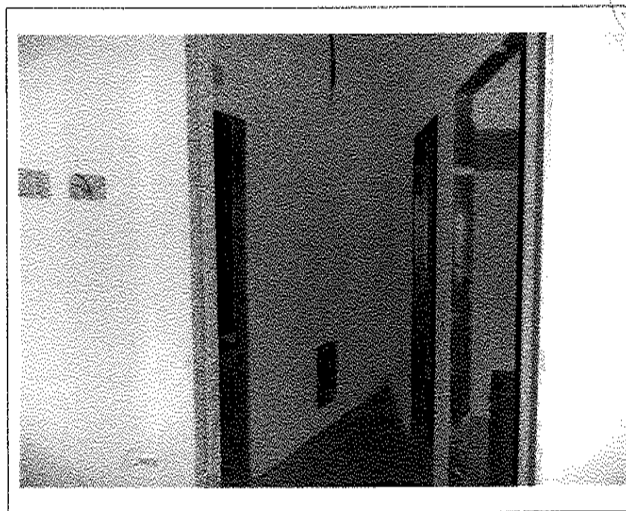
- Lotto n. A01: mapp. 482, fabbricato F4, u.i.u. n°1 – interno: disimpegno -
