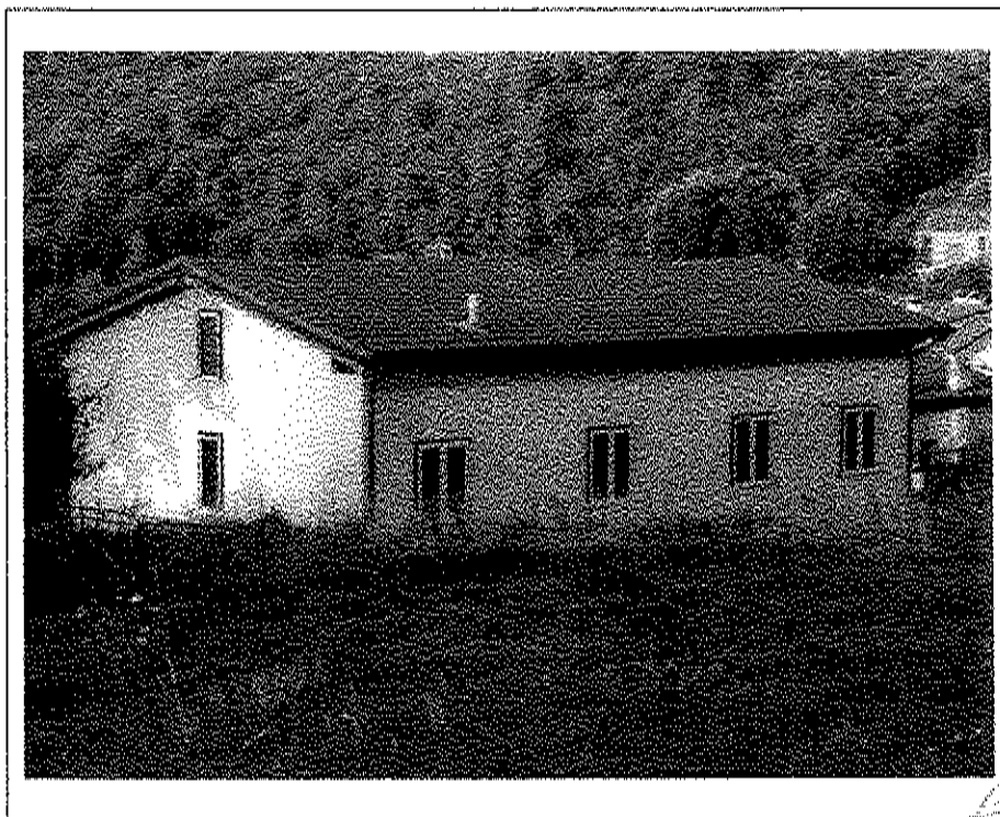
- Lotto n. A01: Fabbricato F4 denominato "Riomaggiore": prospetti Est e Nord, insistente sul mapp. 482 -
