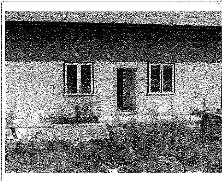
- Lotto n. A01: mapp. 482, Fabbricato F1, u.i.u. n°4: prospetto Nord-Ovest -
