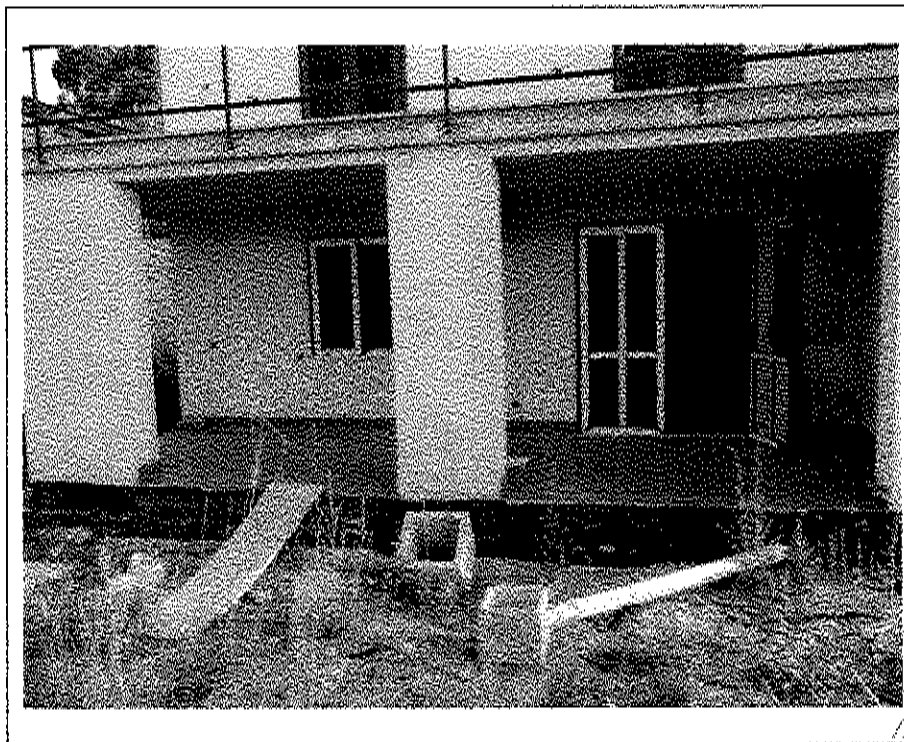
- Lotto n. A01: mapp. 482, Fabbricato F4, u.i.u. n°1: prospetto Sud -
