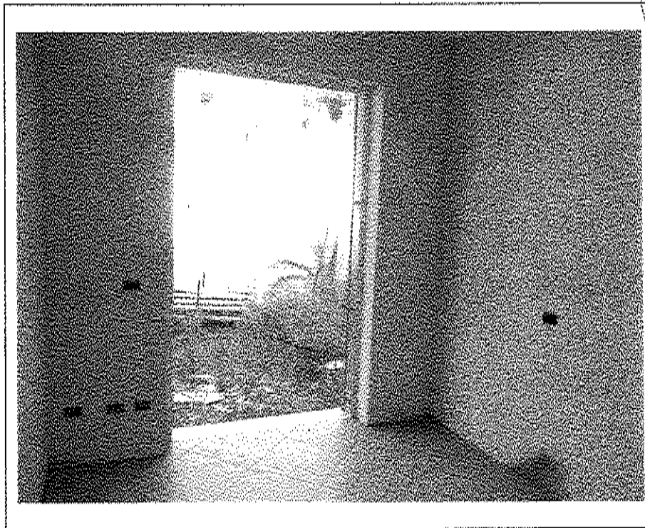
- Lotto n. A01: mapp. 482, fabbricato F5, u.i.u. n°1 – interno: camera -
