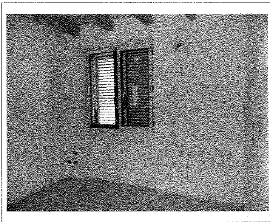
- Lotto n. A01: mapp. 482, Fabbricato F1, u.i.u. n°4 -- interno: camera -
