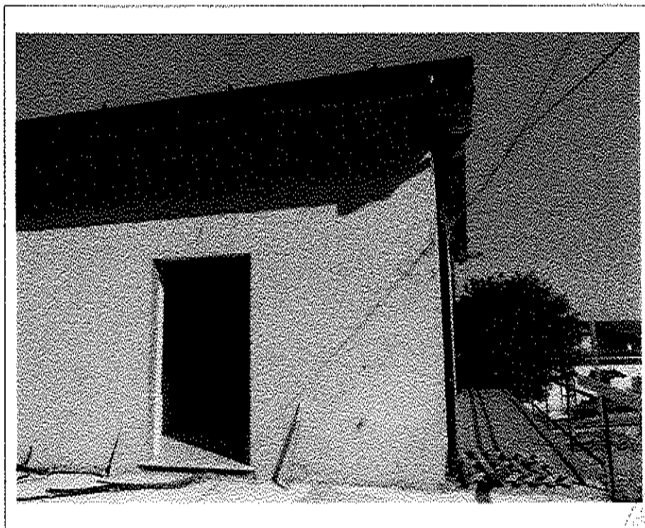
- Lotto n. A01: mapp. 482, fabbricato F3, u.i.u. n°5: prospetto Nord-Ovest -
