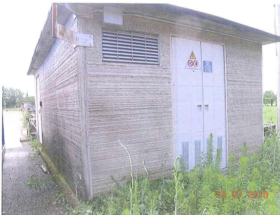
cabina elettrica e di trasformazione – fronte sud
