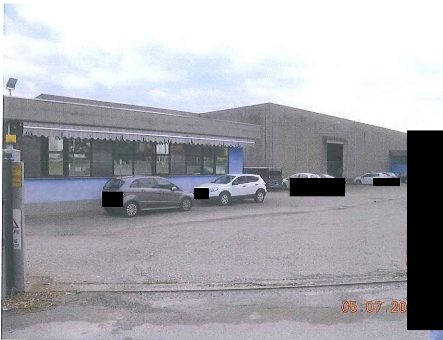
accesso via S. Rocco – fronte ovest
