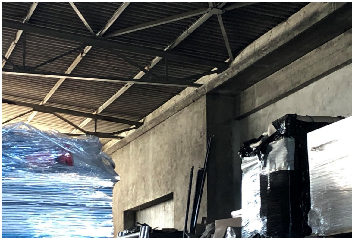
FOTO 9 - dettaglio copertura e capriate in ferro e portone tra i due capannoni
