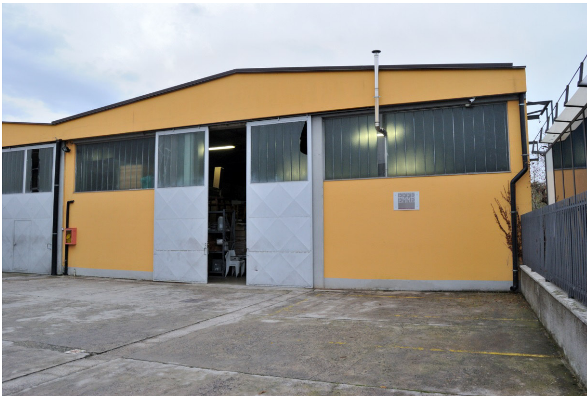
FOTO 3 - fronte capannone lato ovest
