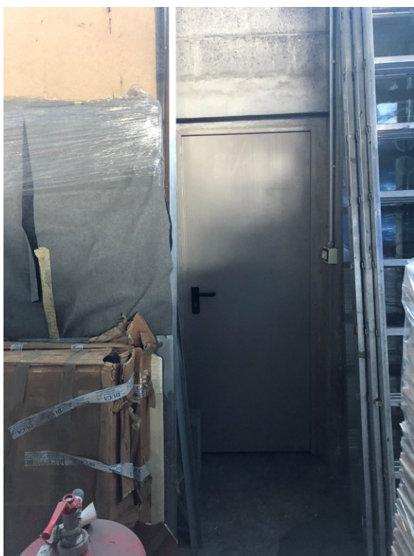
FOTO 16 – dettaglio porta ingresso al deposito sul fondo del capannone
