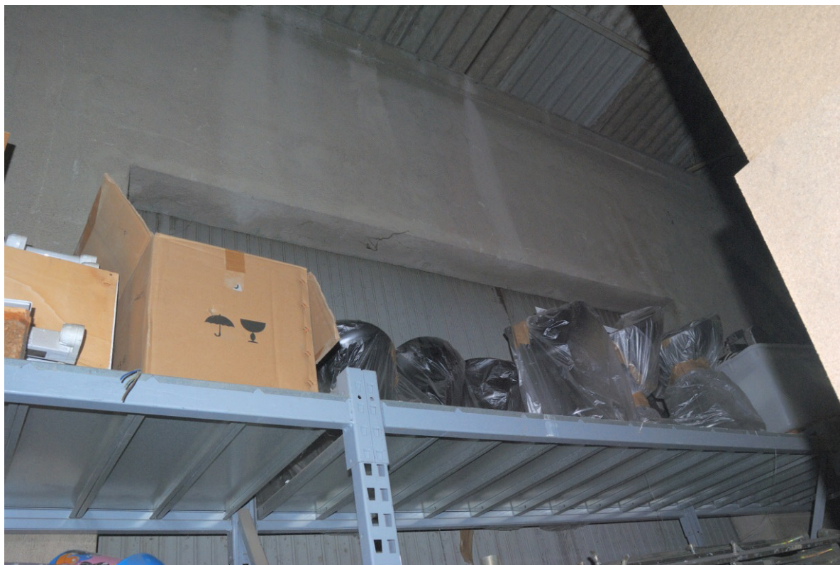
FOTO 15 - dettaglio portone comunicante tra i due capannoni
