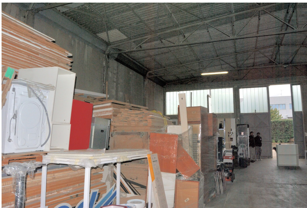
FOTO 8 - interno capannone verso ovest (lato ingresso)
