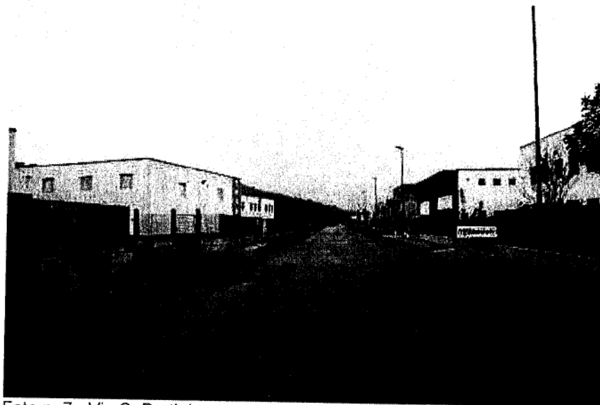
Foto n. 7 - Via S. Pertini
