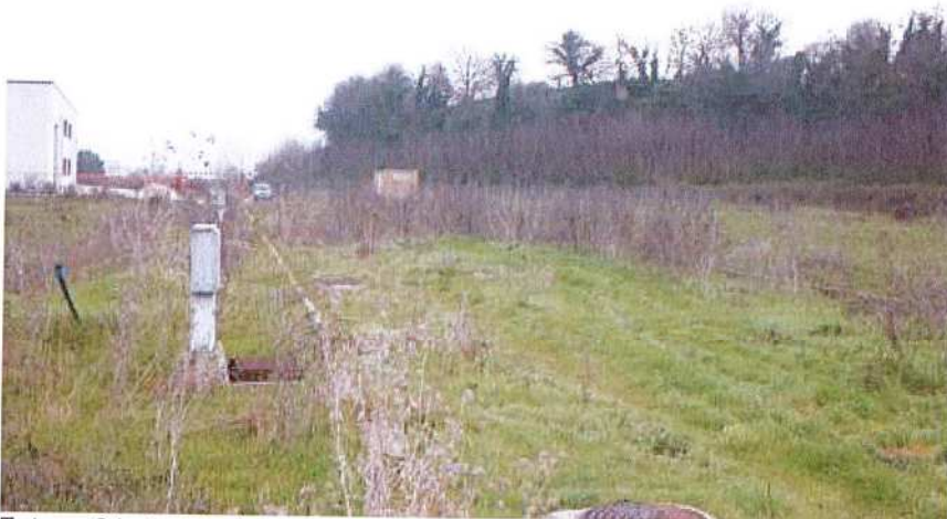
Foto n. 24 - tratto della Via S. Pertini non ultimato
