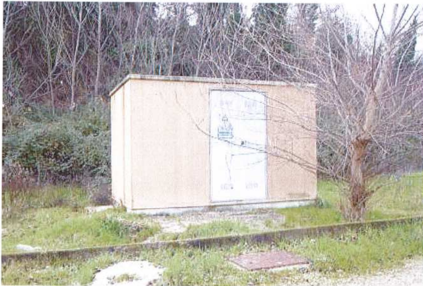
Foto n. 28 - opere eseguite nel tratto della Via S. Pertini non ultimato
