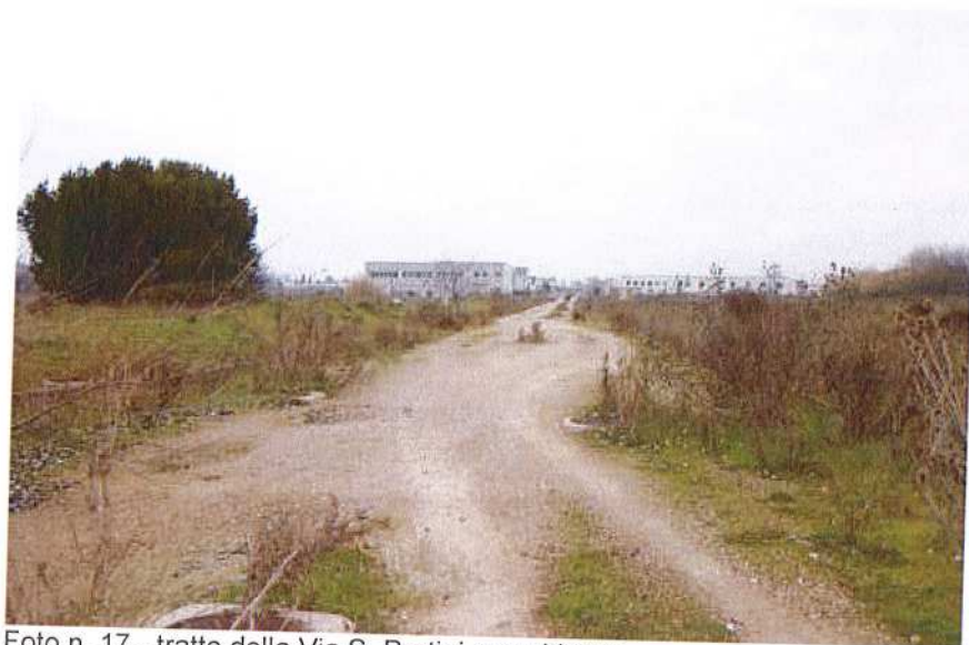
Foto n. 17 - tratto della Via S. Pertini non ultimato
