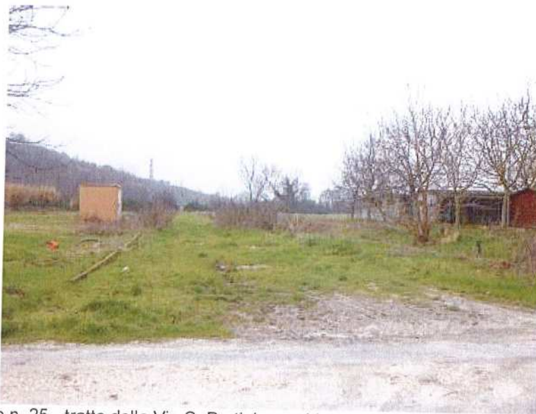
Foto n. 25 - tratto della Via S. Pertini non ultimato
