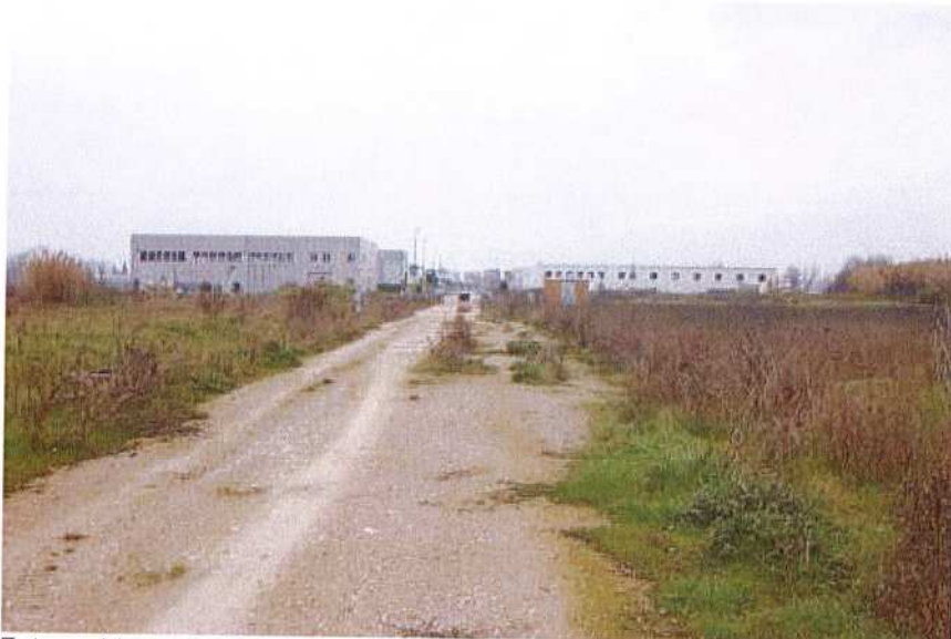
Foto n. 14 - tratto della Via S. Pertini non ultimato
