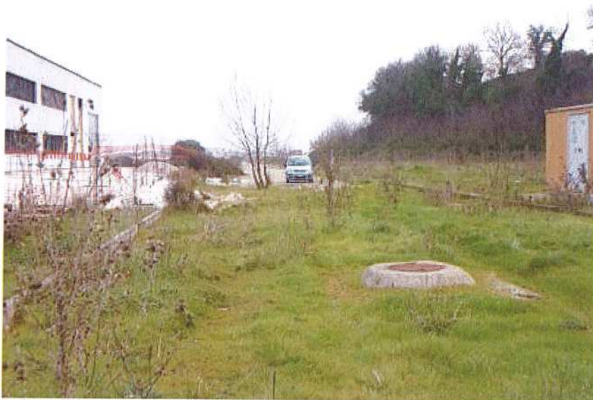
Foto n. 19 - tratto della Via S. Pertini non ultimato
