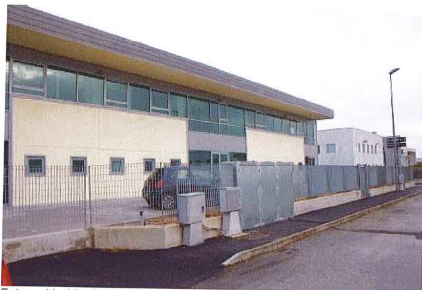
Foto n. 11 - Via S. Pertini
