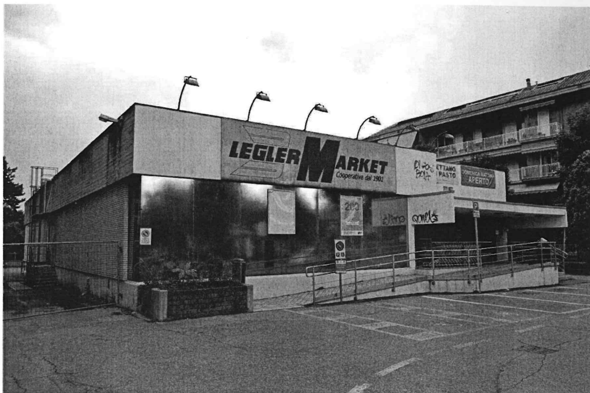
01. FRONTE SUD-OVEST – INGRESSO IMMOBILE
