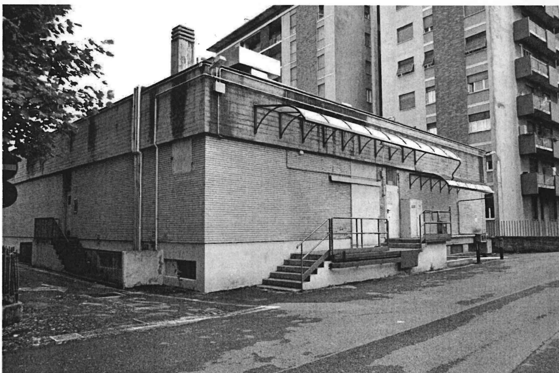
02. FRONTE NORD_EST – RETRO IMMOBILE
