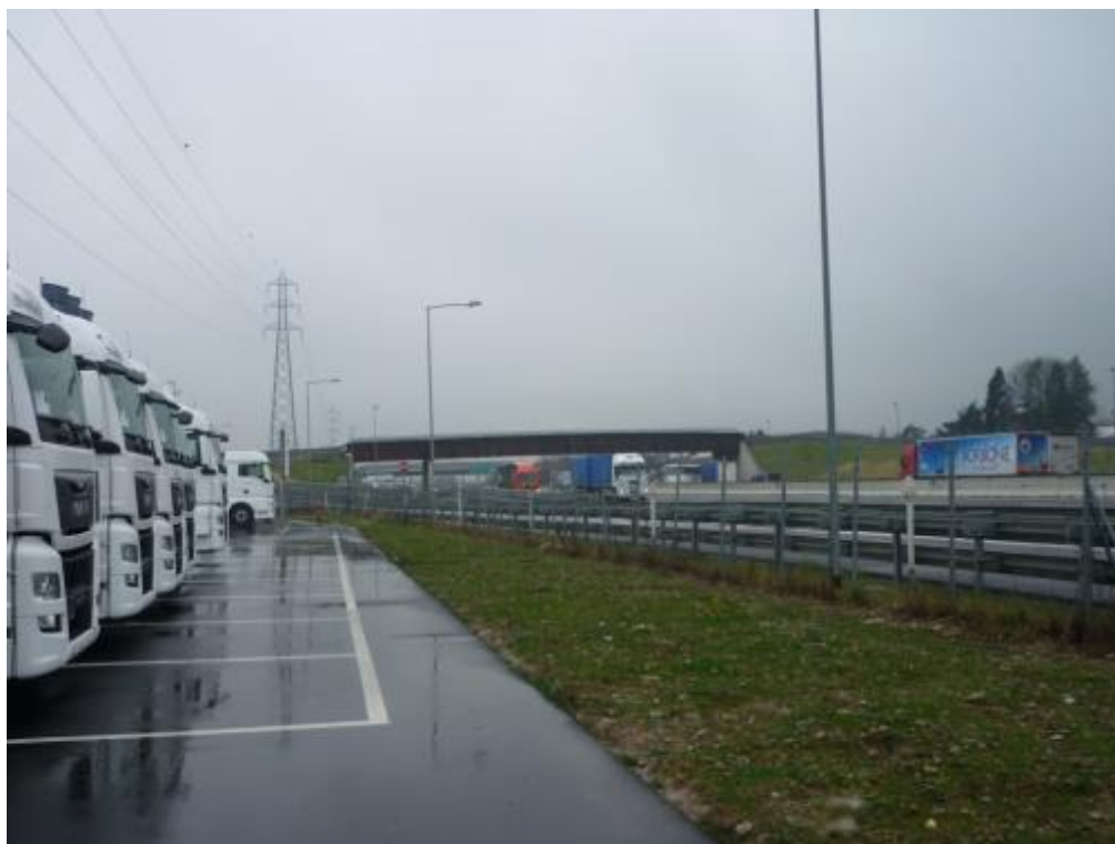
Cavenago d Brianza, Via Piave 20 - Lotto fronte A4
