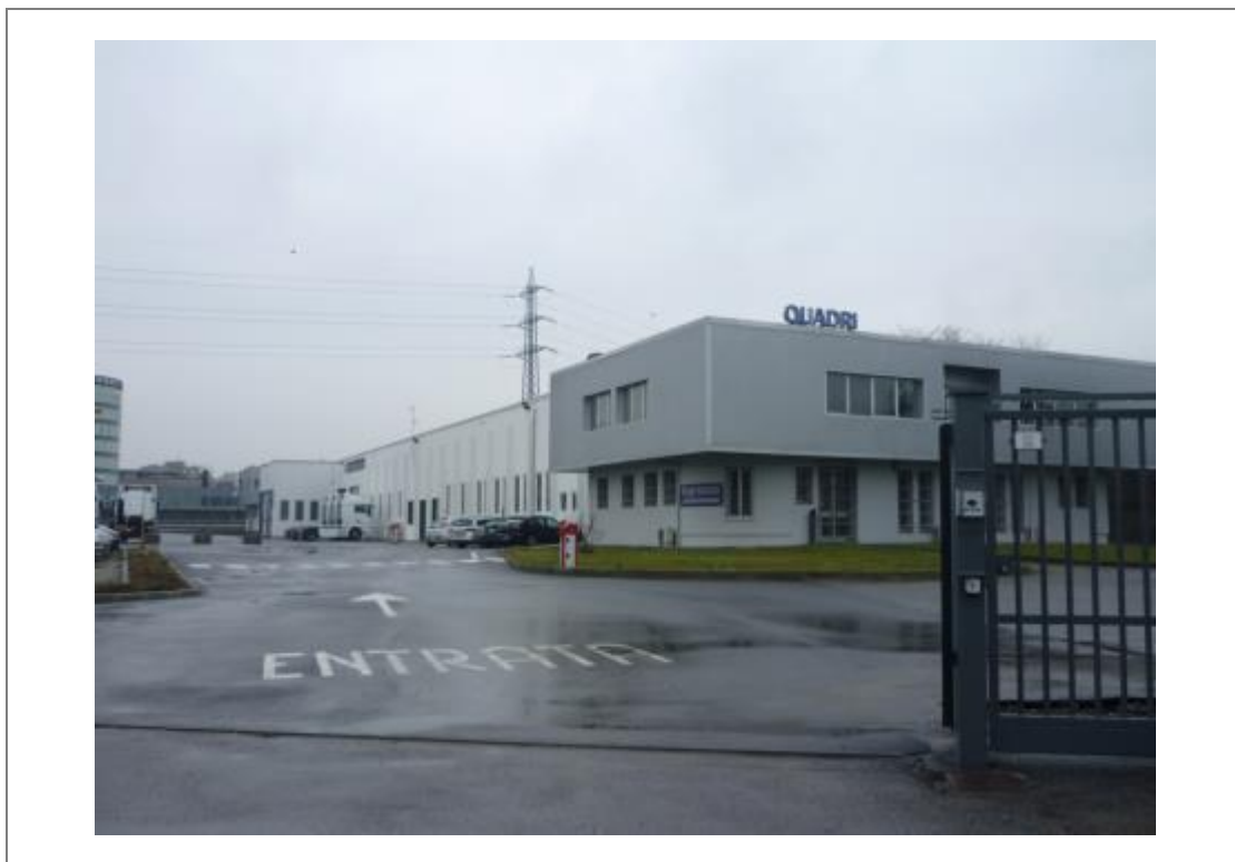
Cavenago d Brianza, Via Piave 20 – Uffici ed Officina fronte Via Piave
