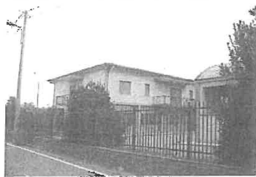
Foto 4- vista dalla via Rampine
