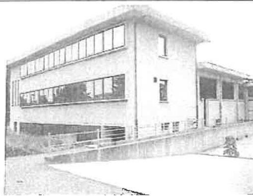
Foto 7- corpo di fabbrica centrale
