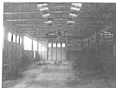
Foto 14- vista interna corpo di fabbrica centrale
