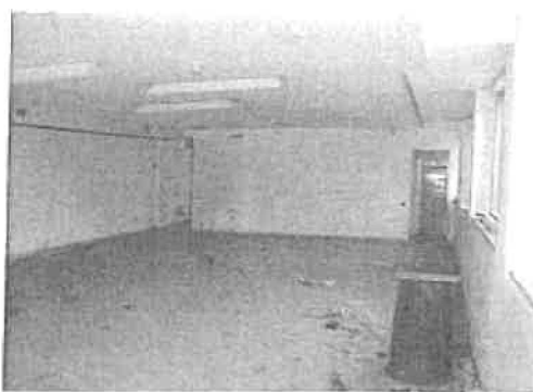
Foto 11- vista interna corpo di fabbrica centrale
