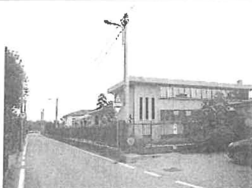
Foto 5- vista dalla via Rampine
