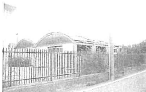
Foto 2- vista dalla via Rampine
