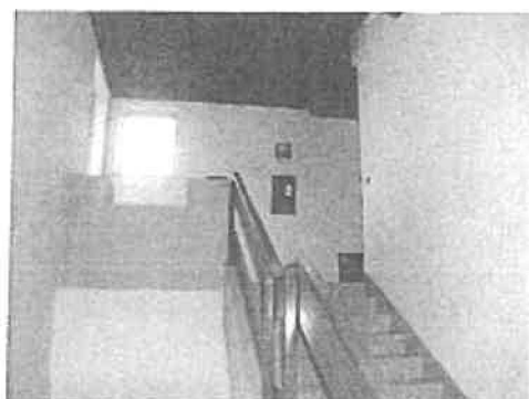
Foto 12- vista interna corpo di fabbrica centrale
