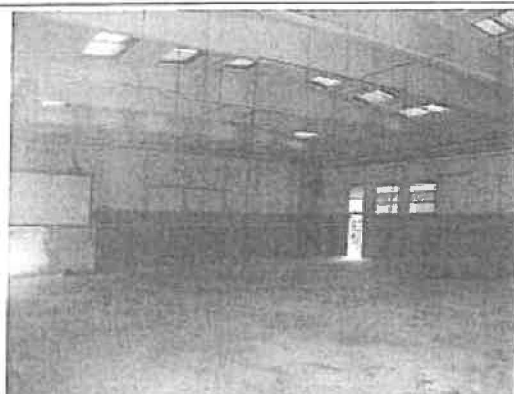
Foto 6- vista interna fabbricato a sud
