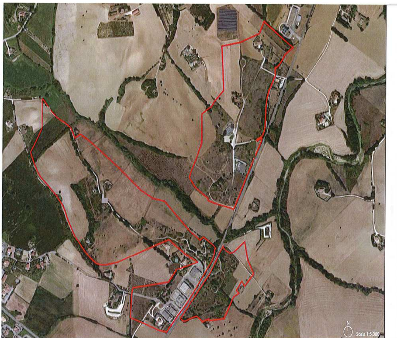
Foto Aerea del compendio immobiliare nel suo complesso fra aree Agricole e aree inserite nel nuovo PL a completamento.
