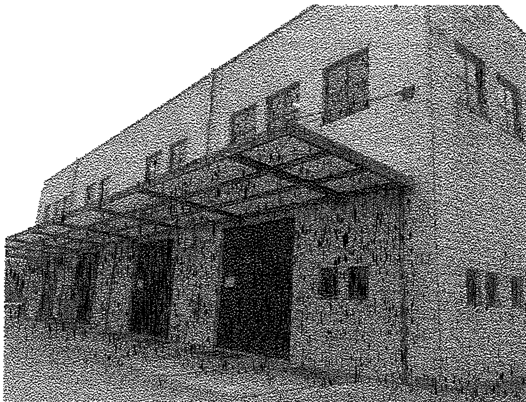
vista posteriore edificio.
