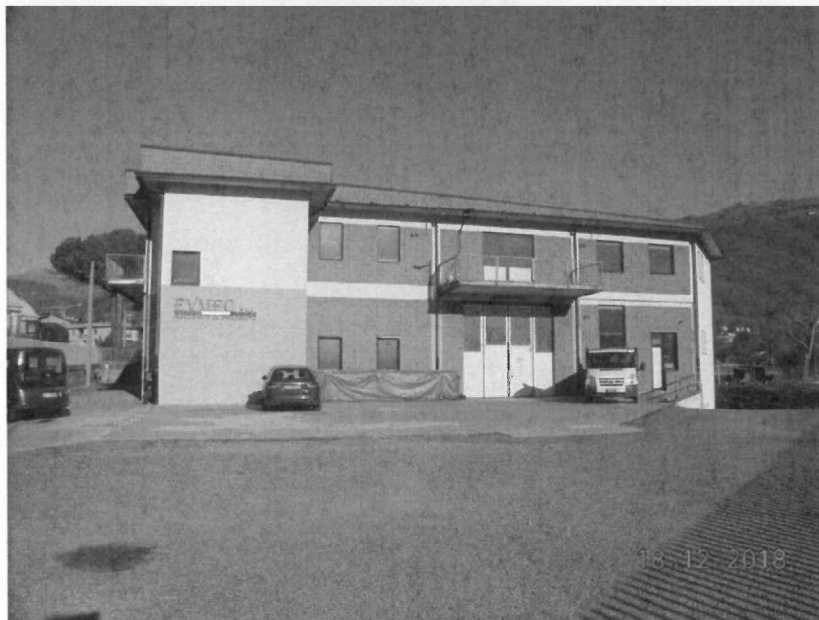
EDIFICIO VIA S. CARLO 65 – FRONTE SUD
