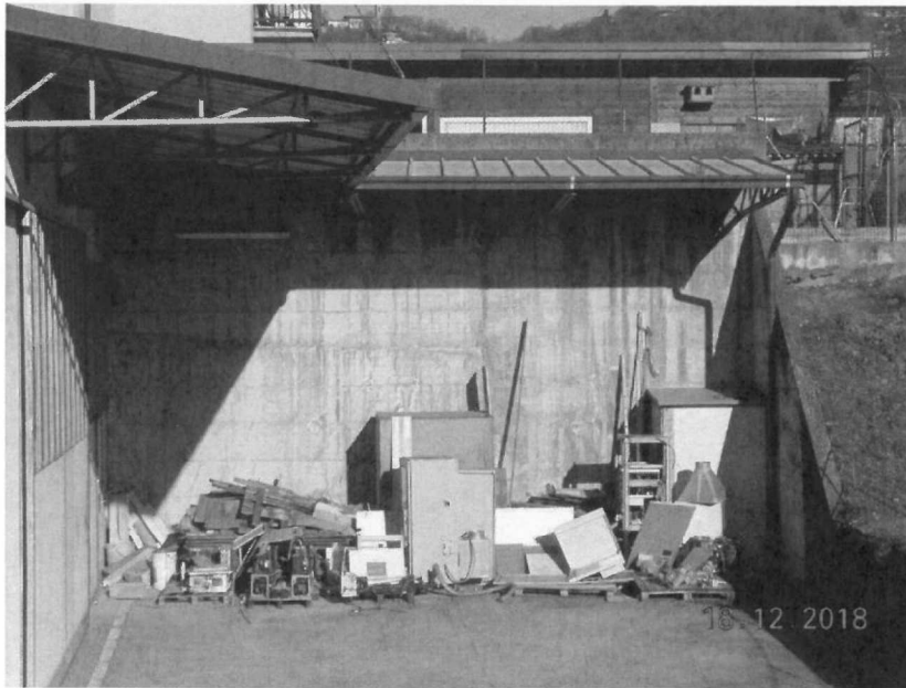
EDIFICIO VIA S. CARLO 65 – PARTE TERMINALE SCIVOLO LATO EST
