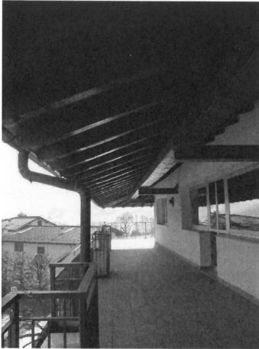
TERRAZZO PERIMETRALE PRIMO PIANO
