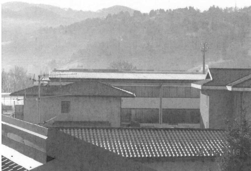
EDIFICIO VIA S. CARLO 65 – COPERTURA IN ETERNIT – VISTA DA EDIFICIO VIA S. CARLO 45/47
