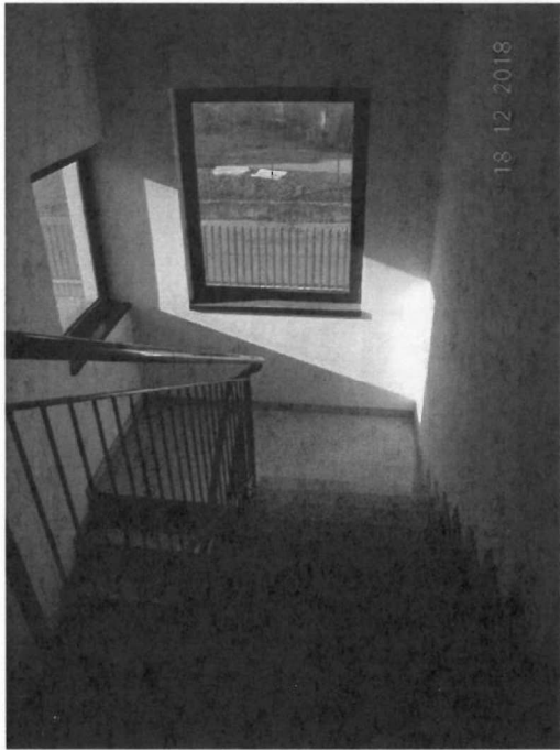
VANO SCALA – COLLEGAMENTO PIANO TERRA/PIANO PRIMO
