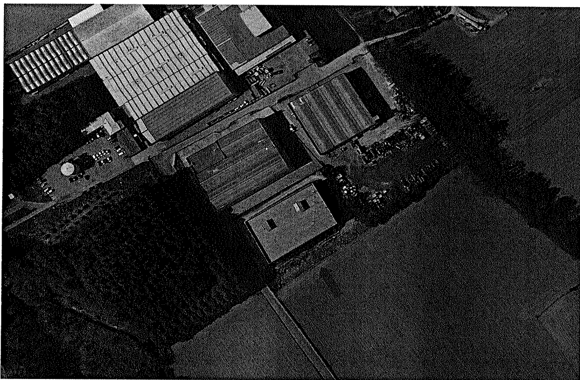
Foto n. 1 - vista aerea – via Lombardia
