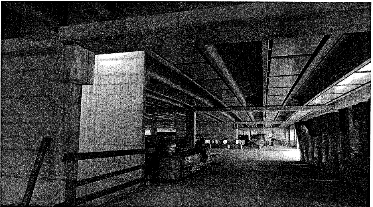
Foto n. 12 - vista dell'interno a piano primo
