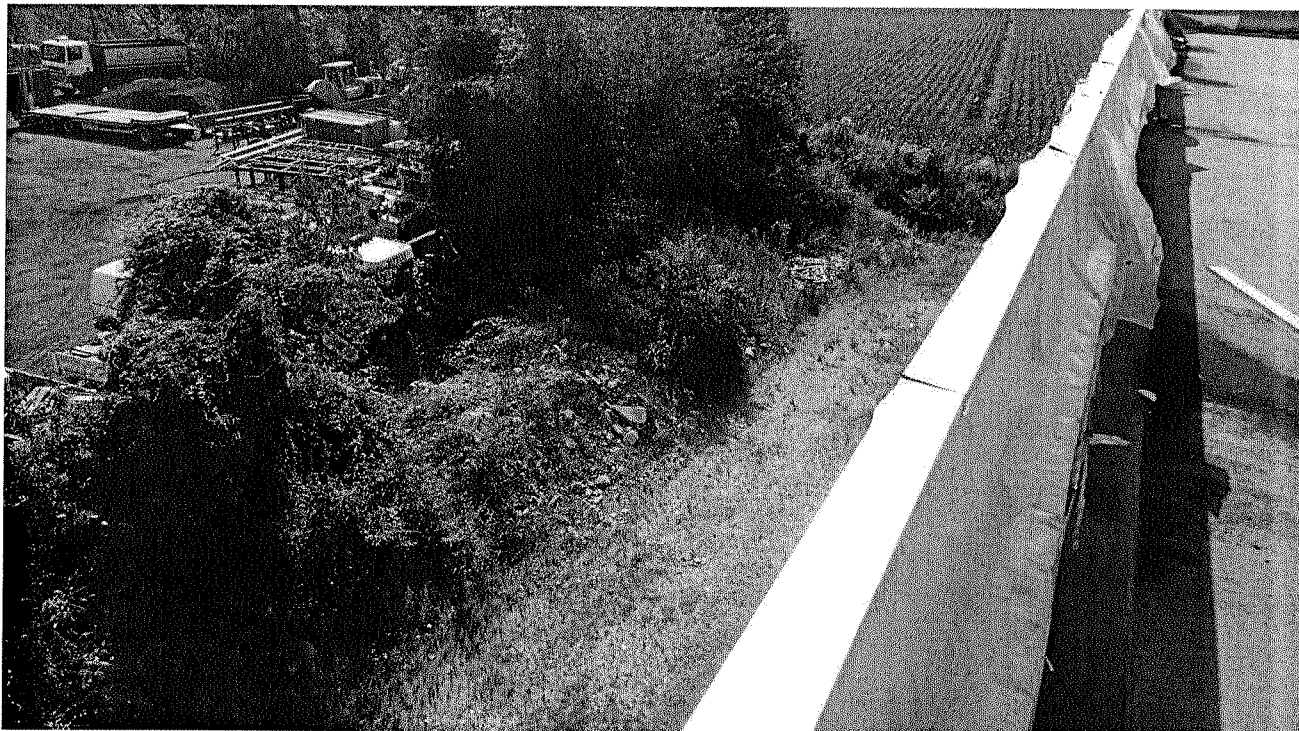
Foto n. 19 - vista recinzione lato est
