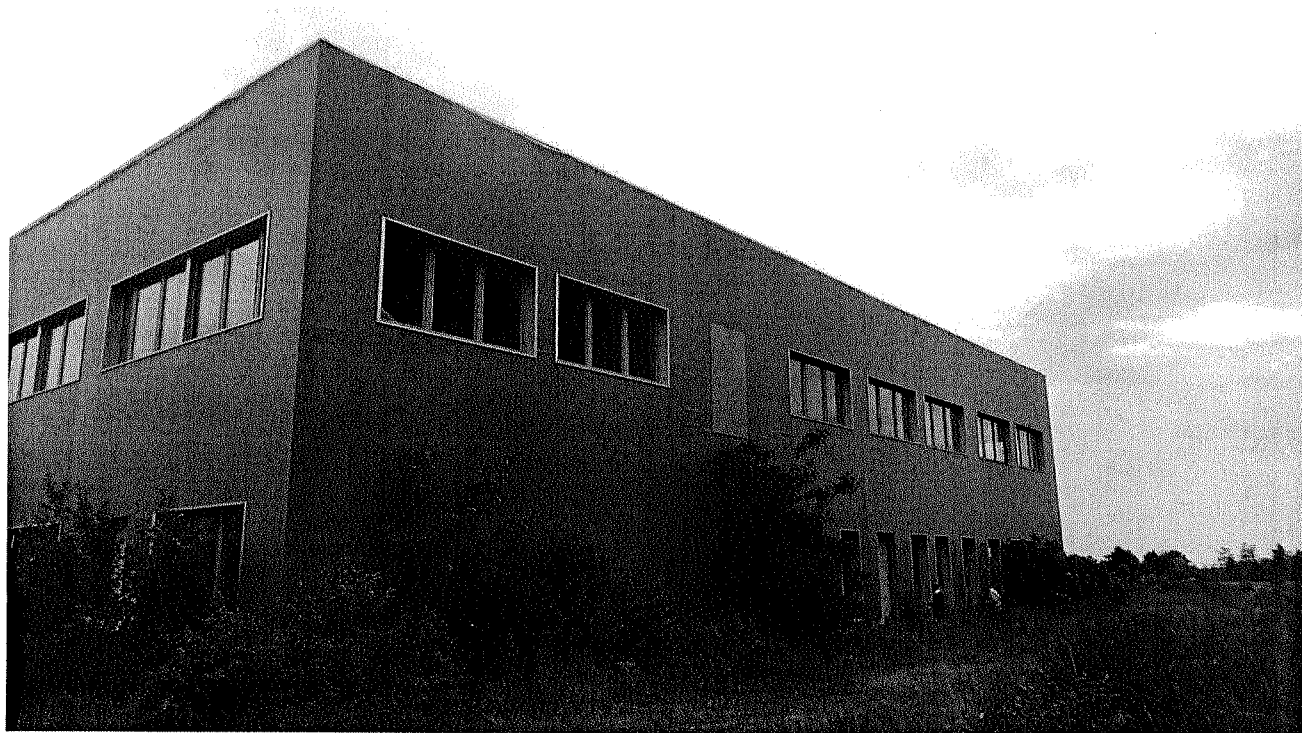
Foto n. 7 - vista del fabbricato - lato ovest
