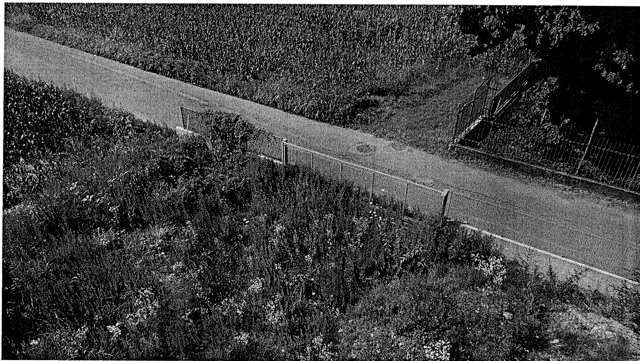
Foto n. 21 - vista recinzione lato ovest – via Lombardia
