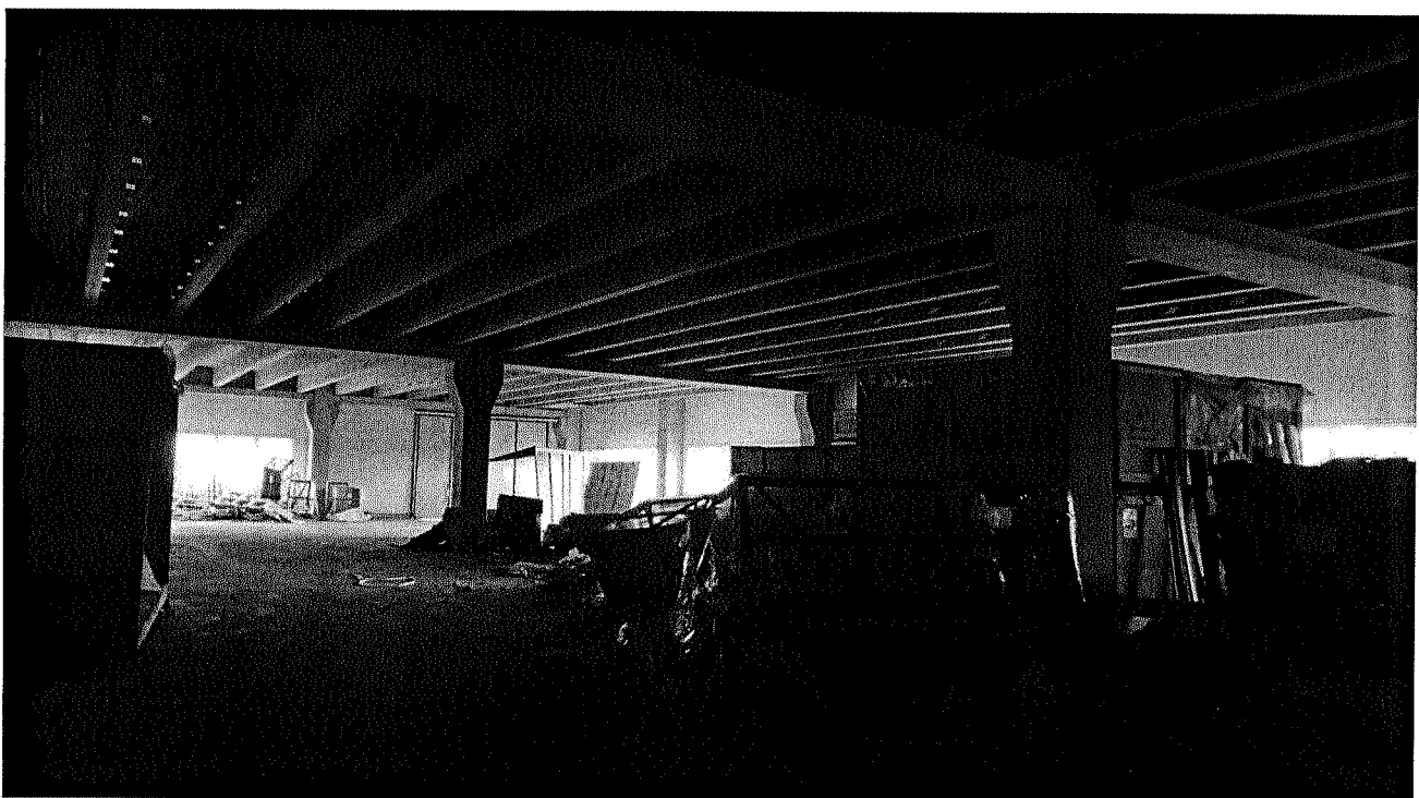
Foto n. 8 - vista dell'interno a piano terra
