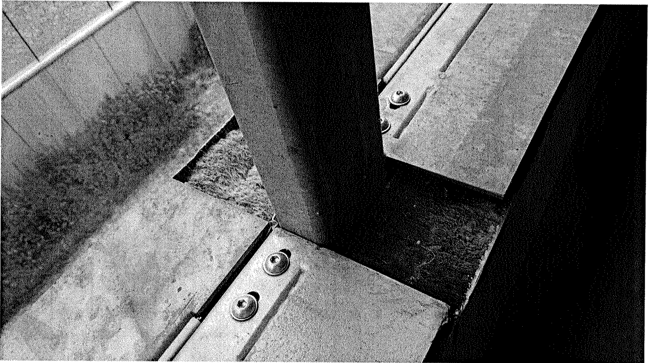
Foto n. 16 – particolare tamponamenti laterali
