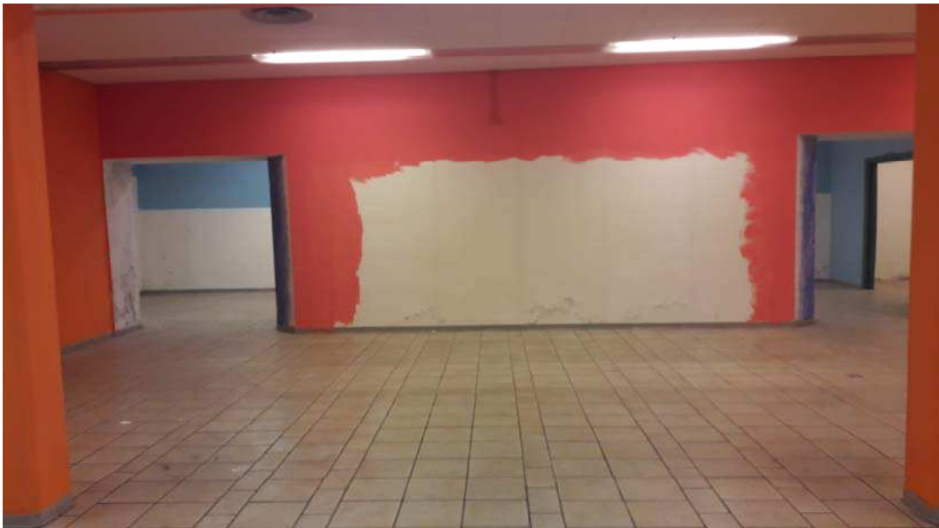
Foto 09 – magazzino – P. interrato
