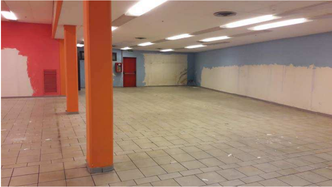
Foto 08 – magazzino – P. interrato
