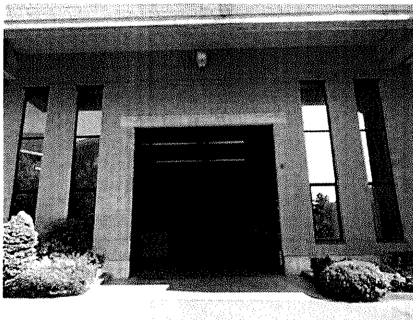
Foto 1 –vista esterna deposito
