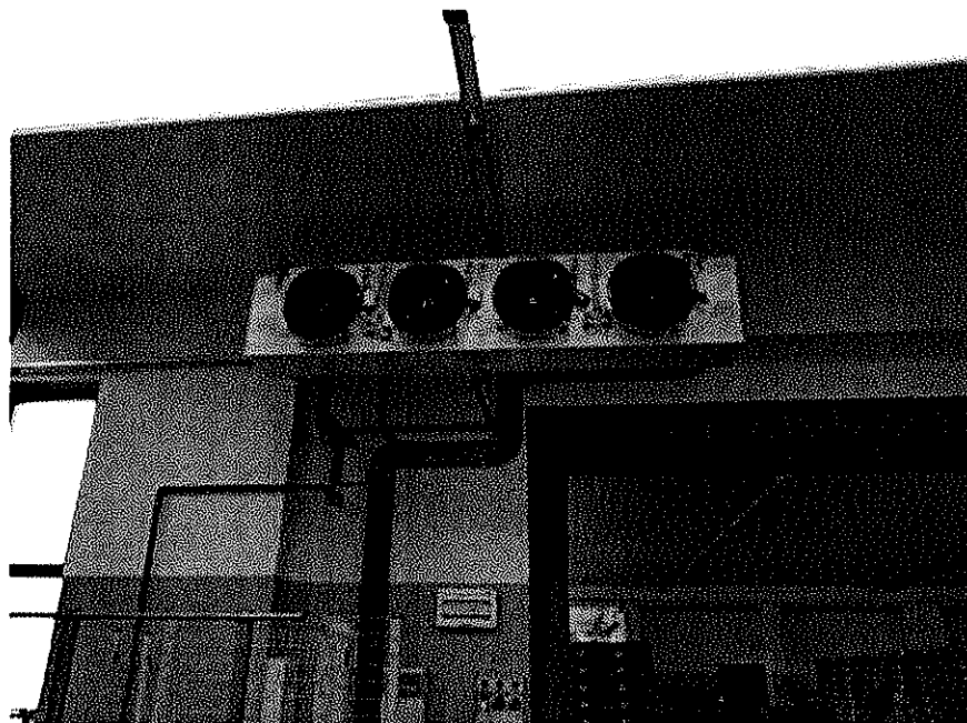
Foto 12 – impianto di raffrescamento
