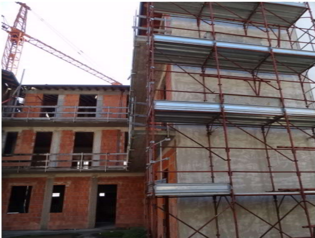
LATO INTERNO CORTILE INTERVENTO SU PIAZZA MAGGIORE
