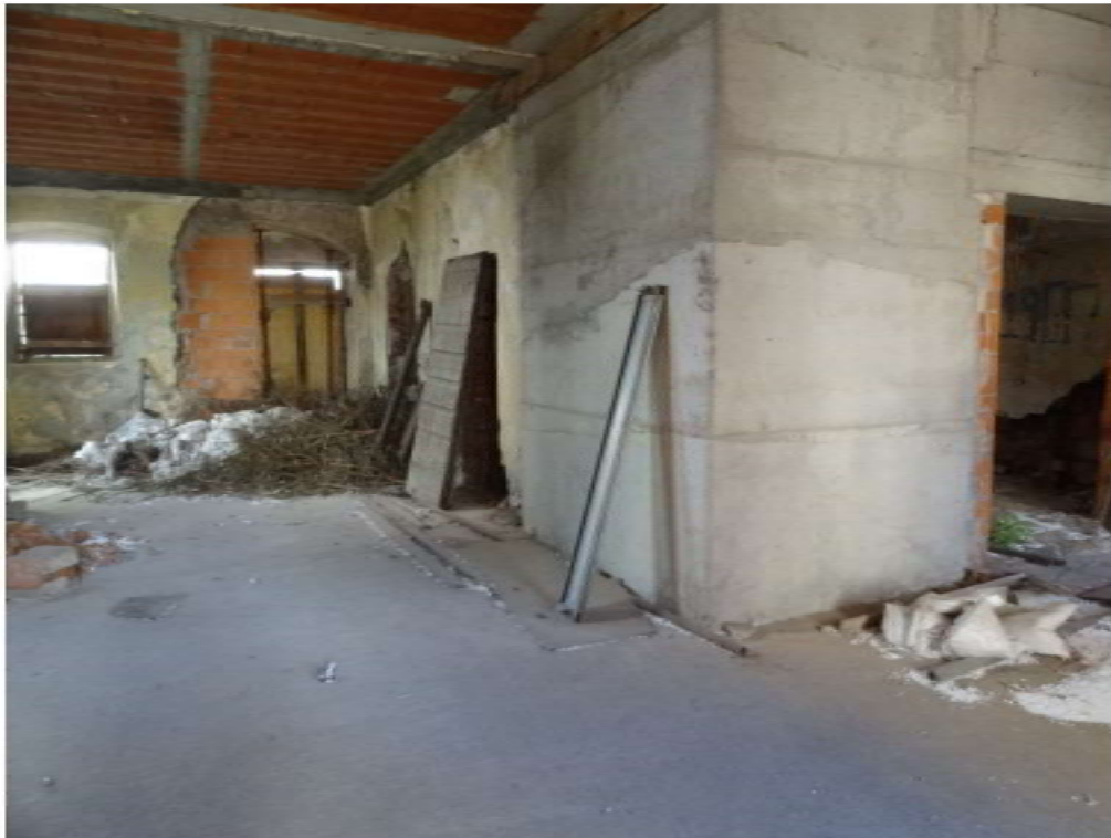
LOCALE INTERNO INTERVENTO PIAZZA MAGGIORE
