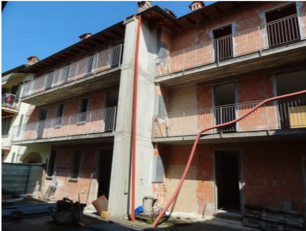
LATO INTERNO CORTILE INTERVENTO SU VIA ODASIO
