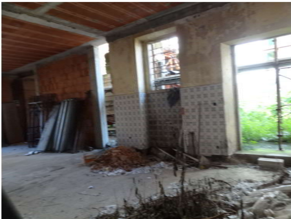
LOCALE INTERNO INTERVENTO PIAZZA MAGGIORE
