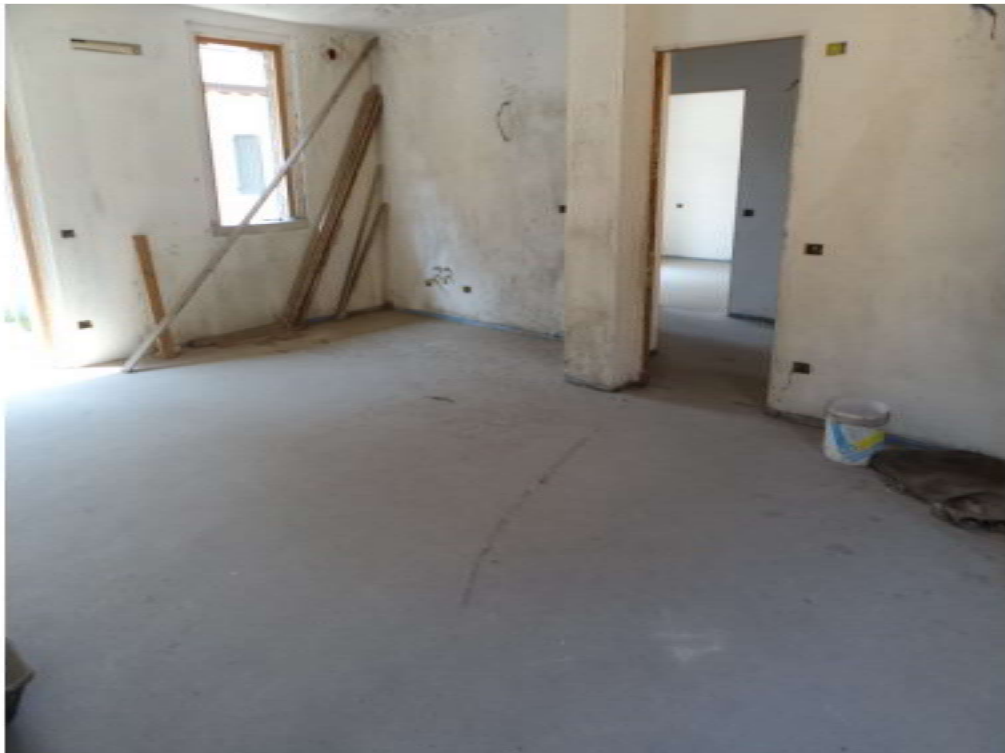
FINITURE INTERNE INTERVENTO SU VIA ODASIO
