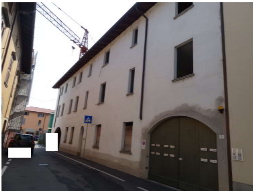
FRONTE SU VIA ODASIO (INTERVENTO SU VIA ODASIO)
