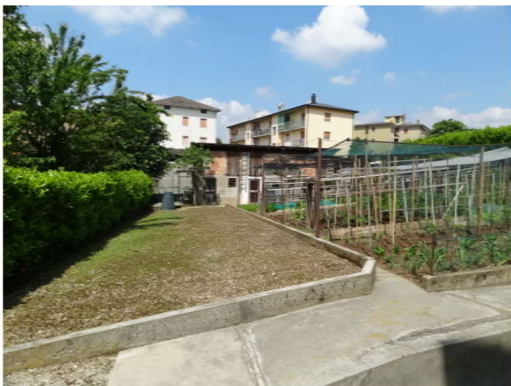
AREA URBANA ESCLUSIVA E SULLO SFONDO PARTE DI RIPOSTIGLIO ESTERNO
