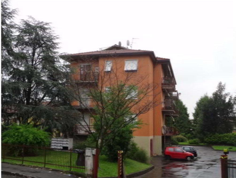
MANSARDA FRONTE STRADA COMUNALE
