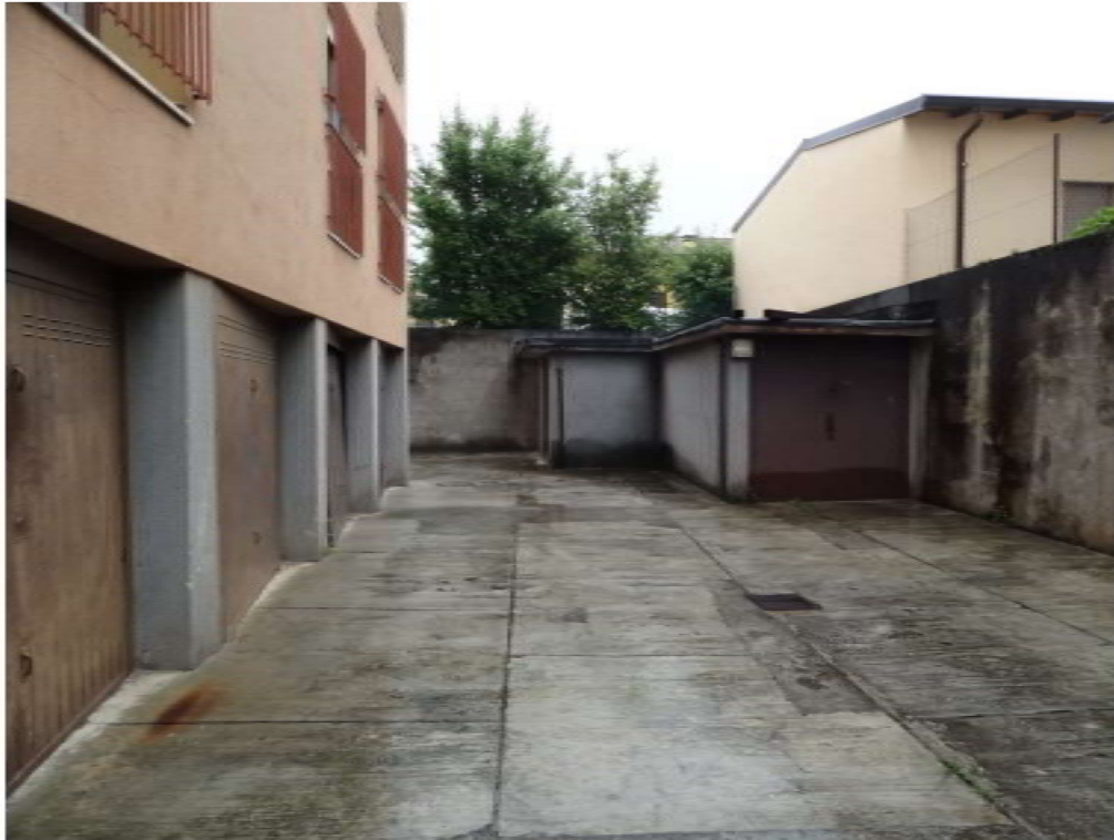
CORSELLO SCOPERTO PER ACCESSO ALL'AUTORIMESSA AL PIANO INTERRATO IMMOBILE FGL. 5 - PART. 911 - SUB. 19
