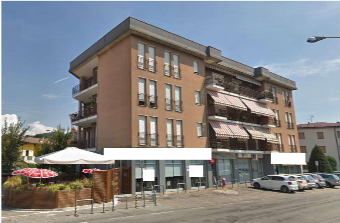
FRONTE VIA SAN FRANCESCO D'ASSISI
