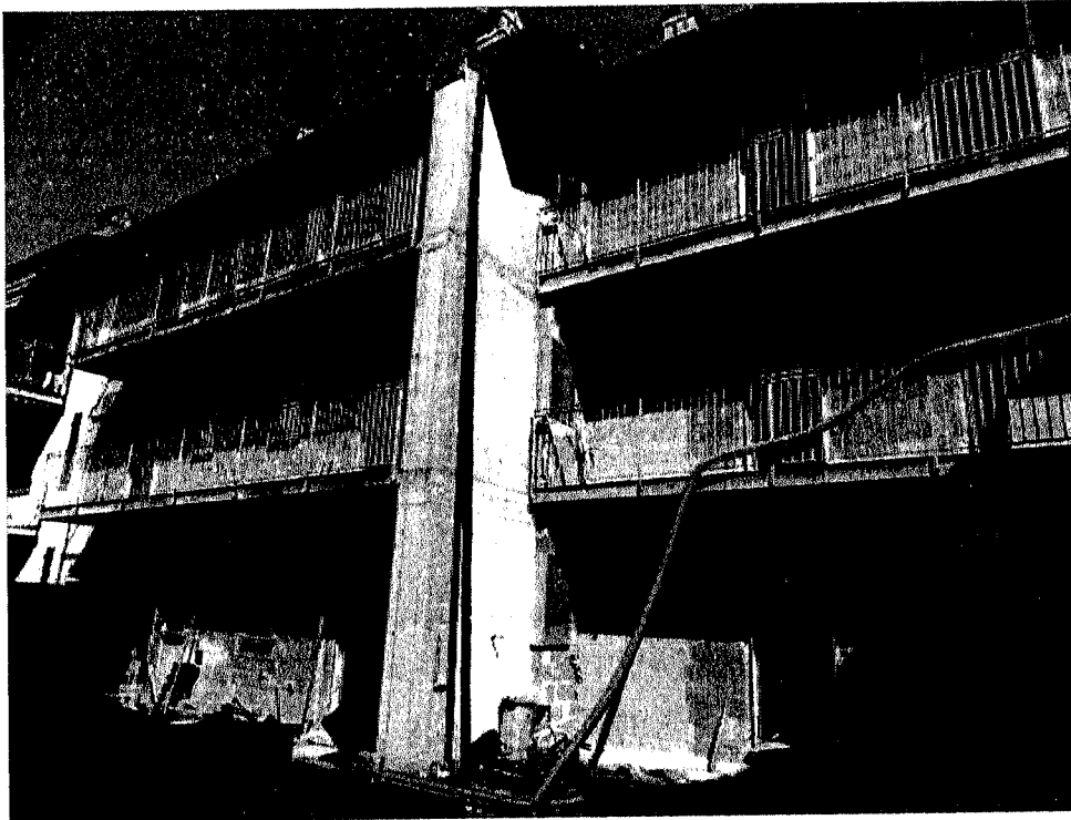
LATO INTERNO CORTILE INTERVENTO SU VIA ODASIO
