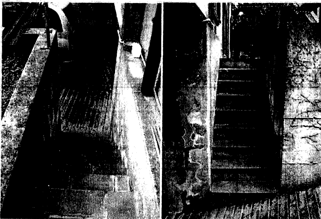
Foto 185 e 186 - Rilievo pertinenza – La scaletta di accesso alla autorimessa e' collegata allo scivolo carrale.
