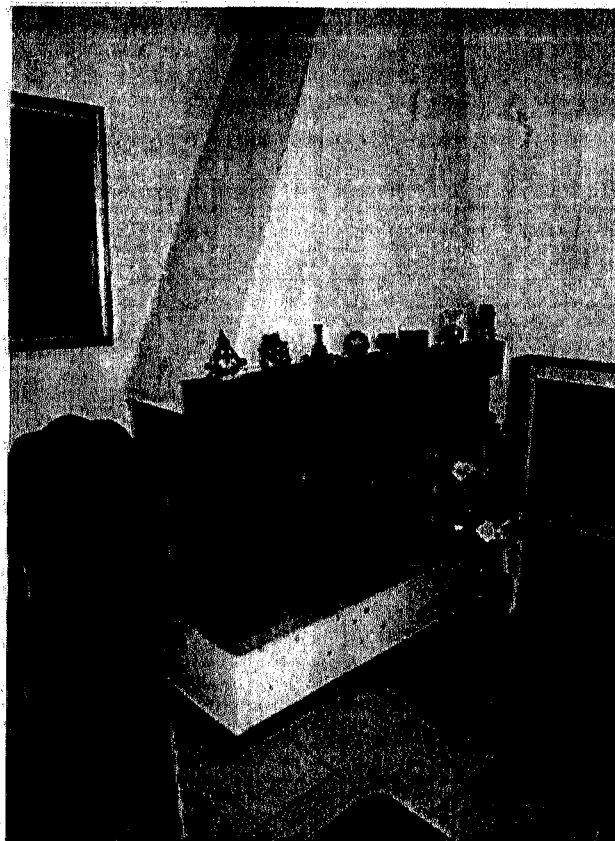
Foto 115, 116 e 117 - Rilievo particolari – Termostato, caldaia termo-autonoma a gas Metano a servizio dell'alloggio del primo piano (Sub. 2) installata nel locale cucina. Camino del locale soggiorno.
