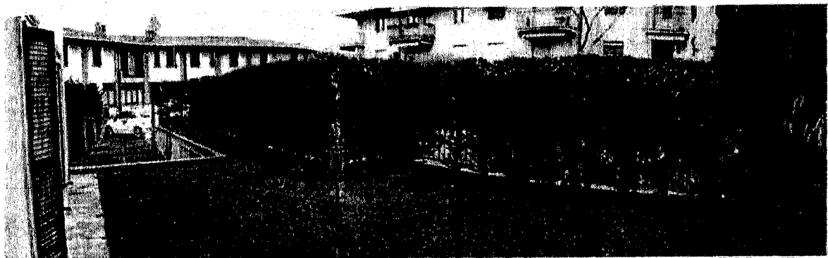
Foto 9, 10 e 11 - Rilievo esterno - Panoramica dell'area esterna piantumata ad Ovest del fabbricato e dell'autorimessa interrata costruita in aderenza sia al fabbricato che al confine Ovest del lotto (rilevata difformità catastale e progettuale).
