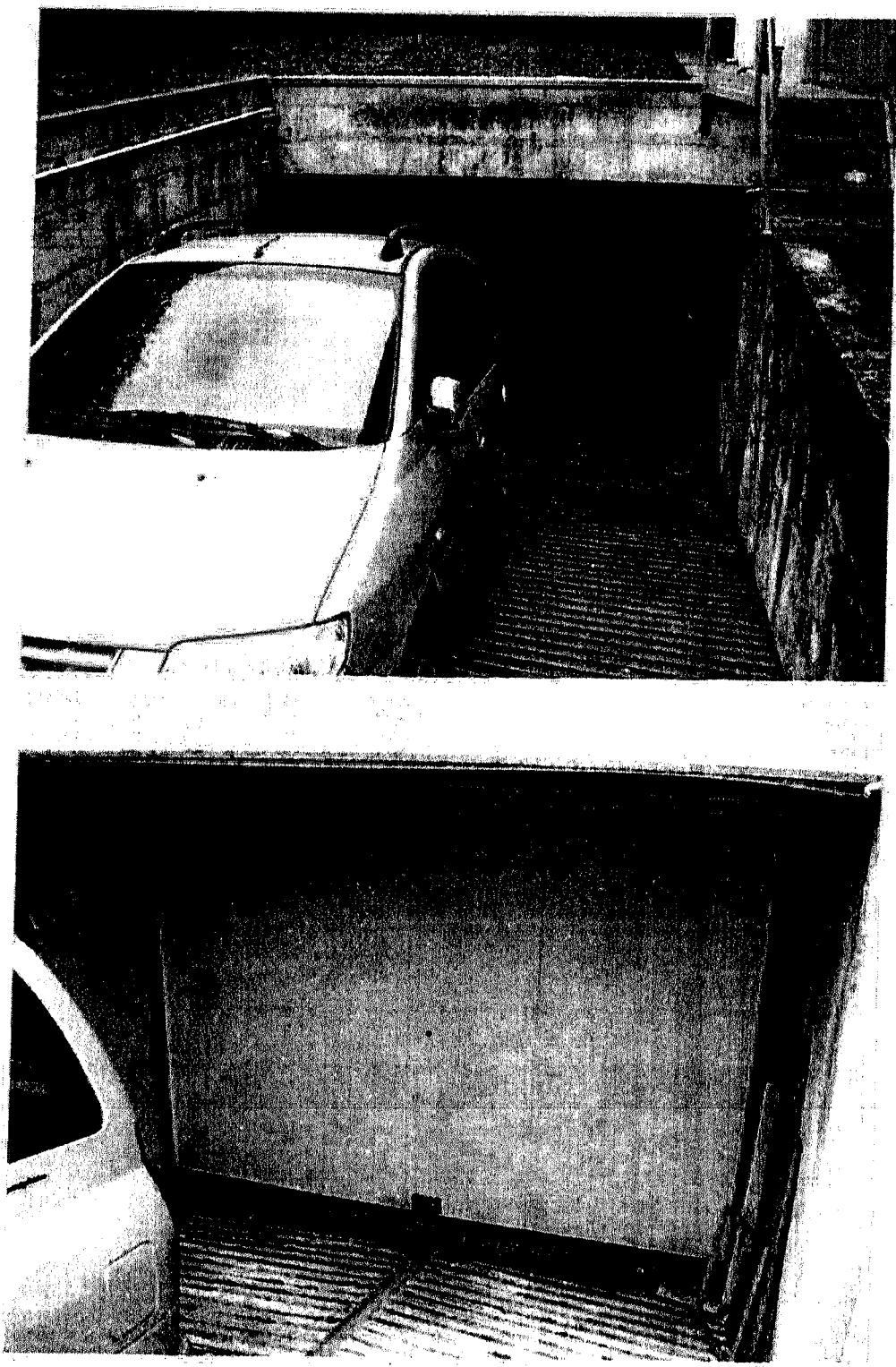
Foto 183 e 184 - Rilievo pertinenza – L'autorimessa interrata (Sub. 4), realizzata in adiacenza al fabbricato, di cui si è rilevata la difformità catastale e progettuale in occasione del perimetro di confine Ovest del lotto (vedasi foto 11a).
