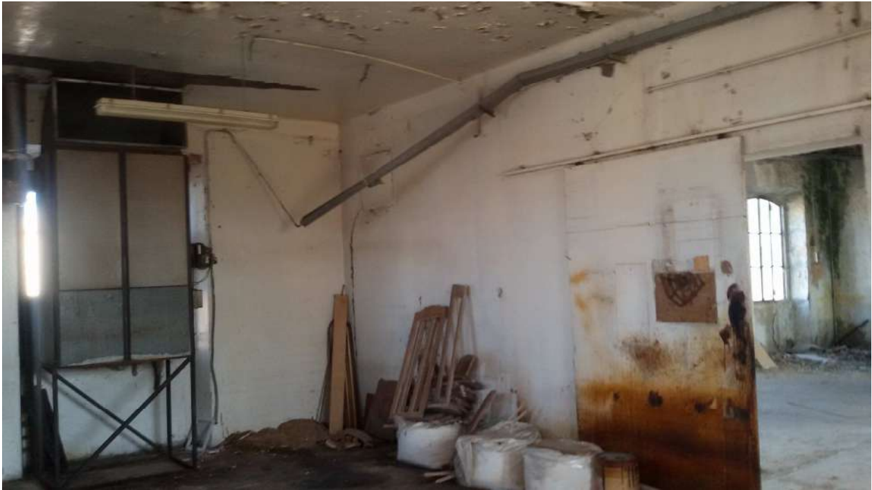
VEDUTE INTERNE LABORATORIO - DEPOSITO
