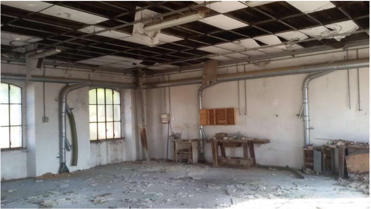
VEDUTE INTERNE LABORATORIO - DEPOSITO
