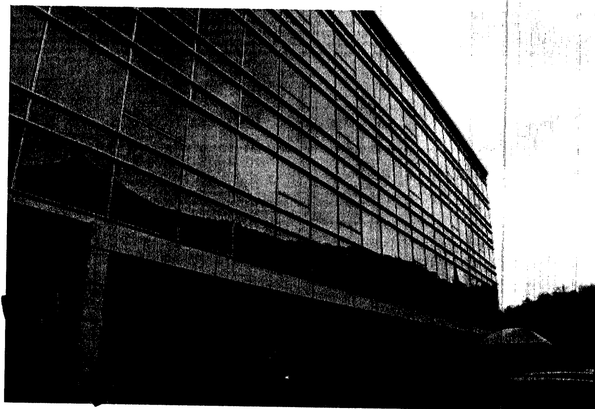
Figura 7 Facciata nord del complesso edilizio.
