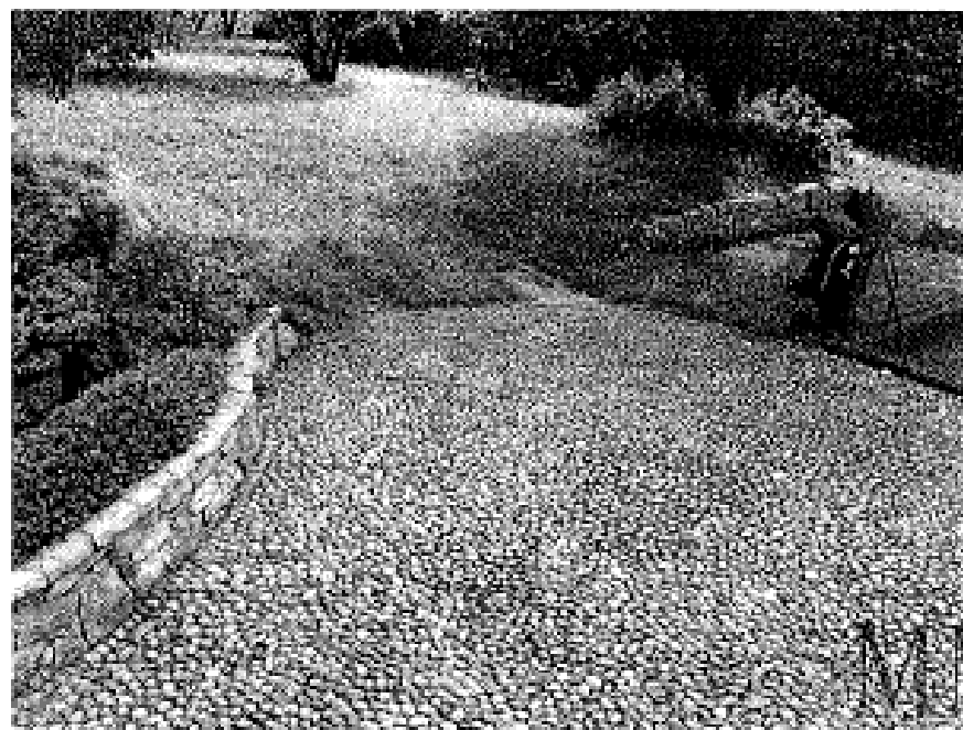
4. Particolare acciottolato vialetto d'ingresso;
