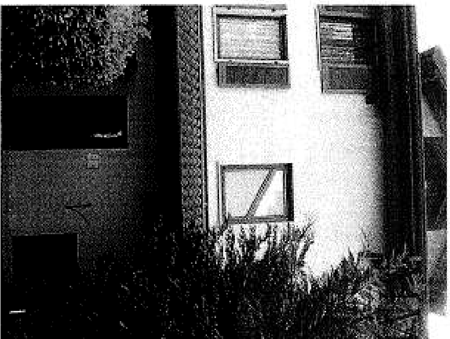
6. Vista fronte ovest verso nord;
