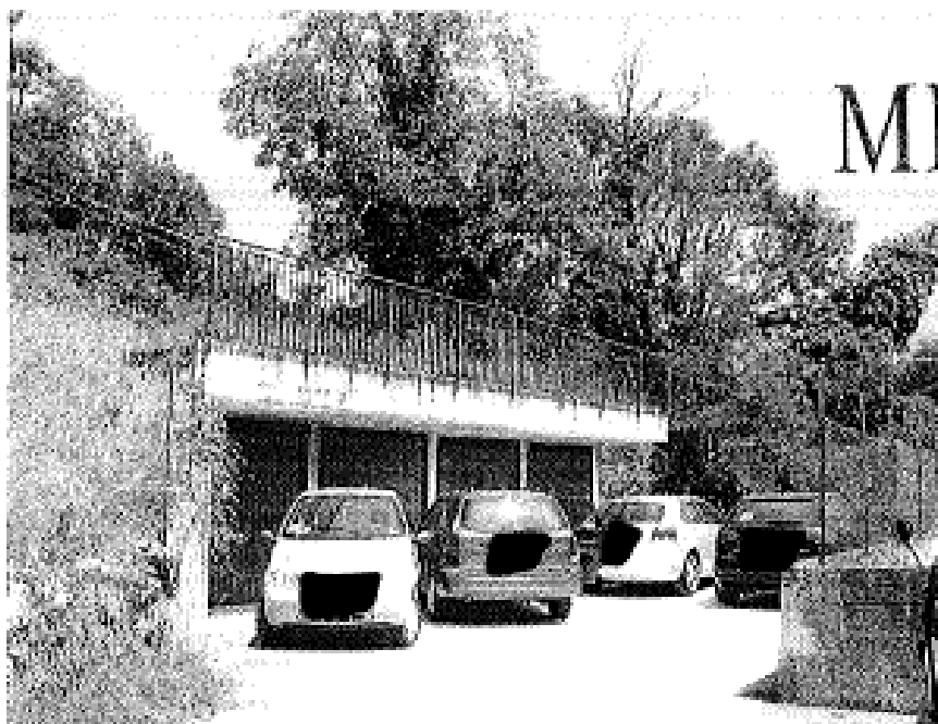
1. Vista fronte sud autorimesse interrante oggetto di stima;
