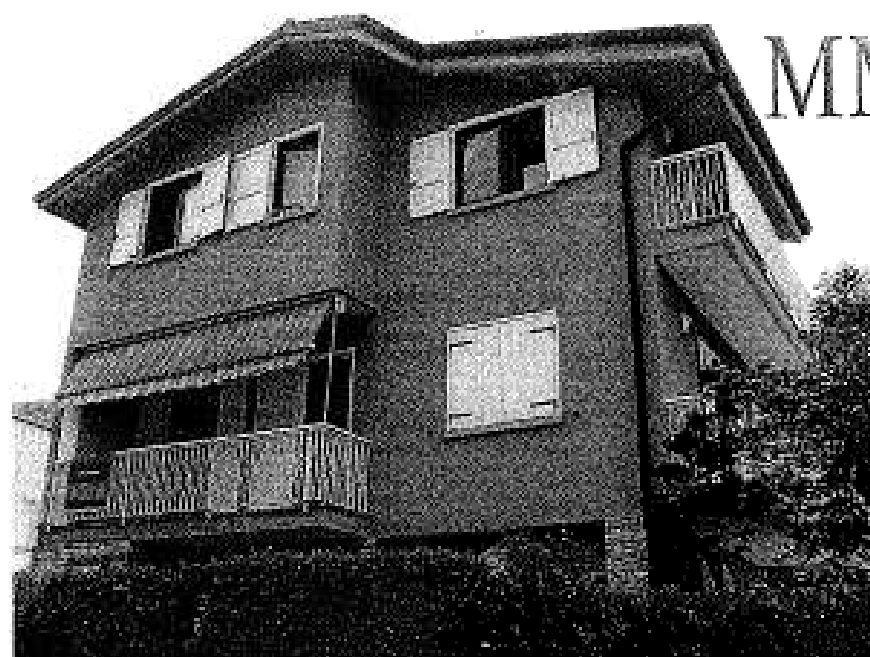
2. Vista fronte nord / ovest edificio;
