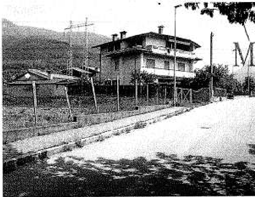
5. Idem, in corrispondenza terreno edificabile al blocco E;
