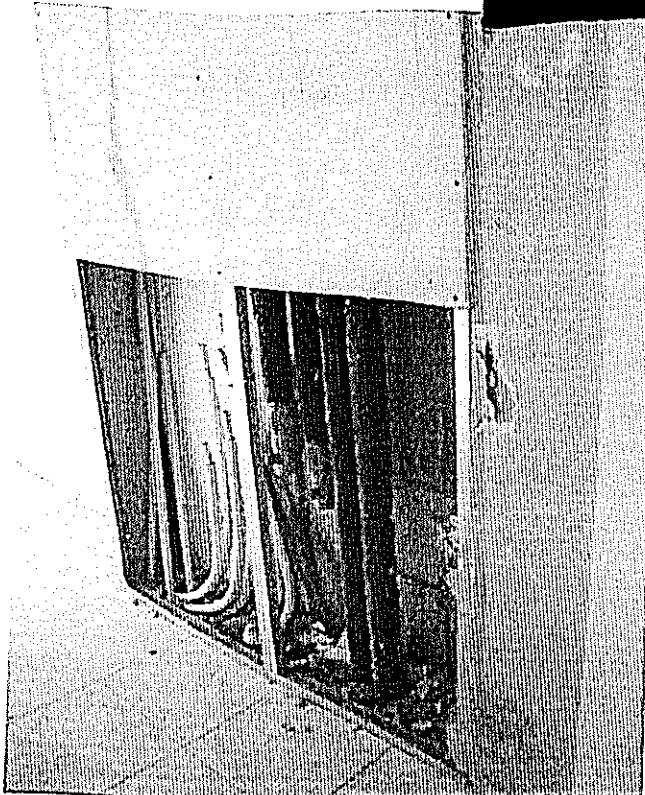
Particolare: distribuzione impianti
