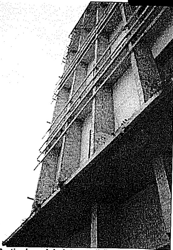
Particolare del sistema di fissaggio dei pannelli Alubond di finitura facciata
