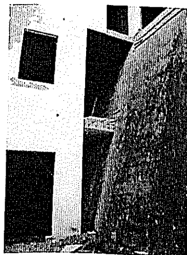
Particolare: collegamento edificio (corpo est) con il terrazzamento della palestra
