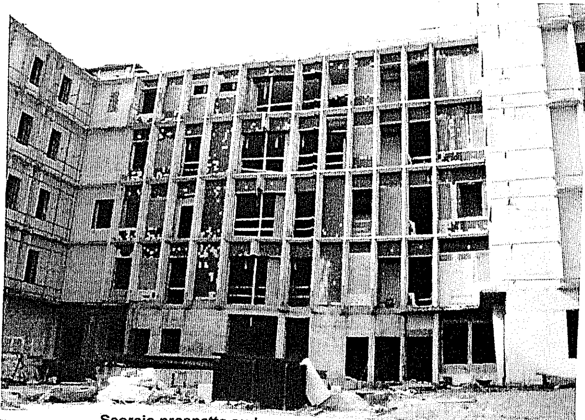
Scorcio prospetto sud corpo centrale dal cortile centrale sud
