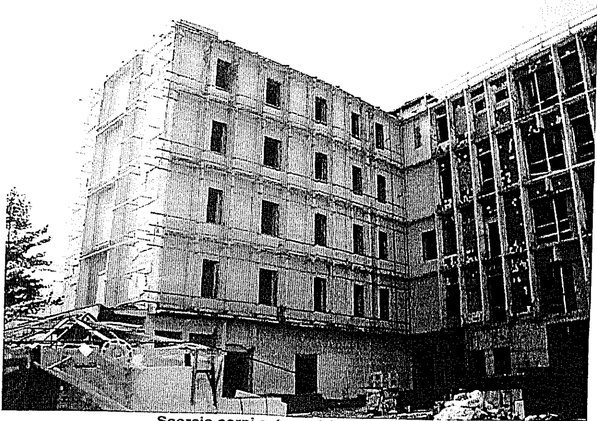
Scorcio corpi est e sud dal cortile centrale sud
