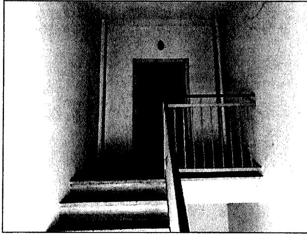
FOTO 19: Ingresso sottotetto dal vano scala
