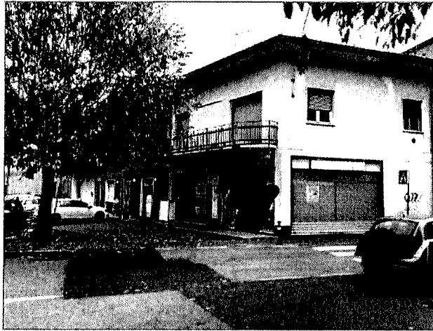
FOTO 1: Angolo immobile tra Via Cap. G. Facchinetti e Piazza Marconi
