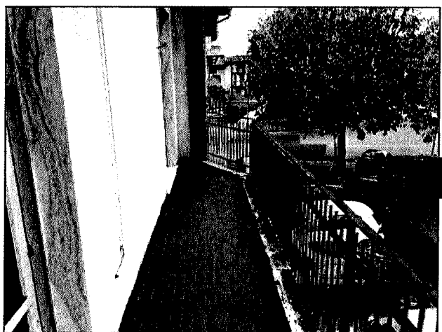
FOTO 18: Balcone lato est primo piano (sub.5)
