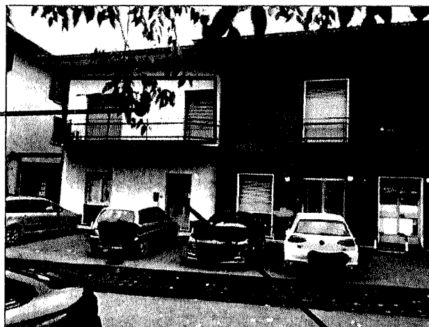
FOTO 3 : Prospetto su Piazza Marconi (ingresso salone acconciature)
