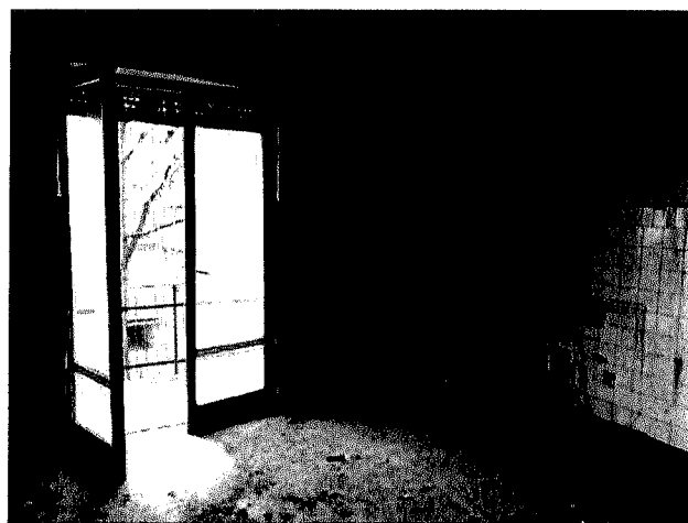
FOTO 15: Cucina primo piano (sub.5)
