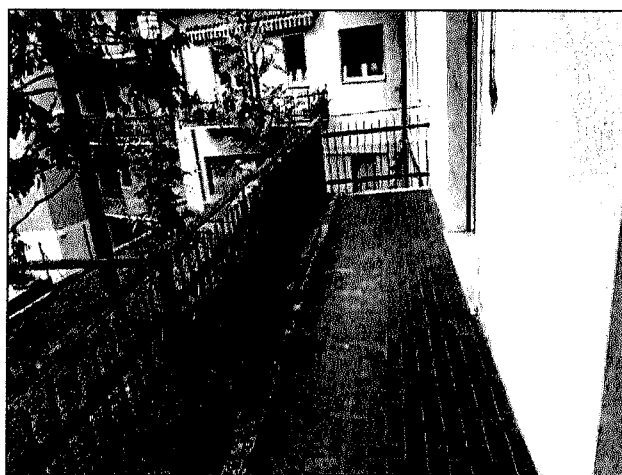
FOTO 17: Balcone lato ovest primo piano (sub.5)
