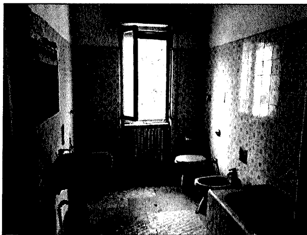
FOTO 16: bagno primo piano (sub.5)
